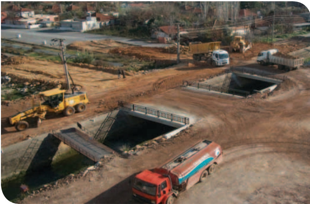
Ayanoğlu Mah. Selçuklular Cad. DSİ. Kanalı Üzerine Köprü Yapımı Çalışması
