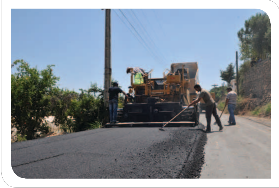
Sıcak Asfalt Serme Çalışması
