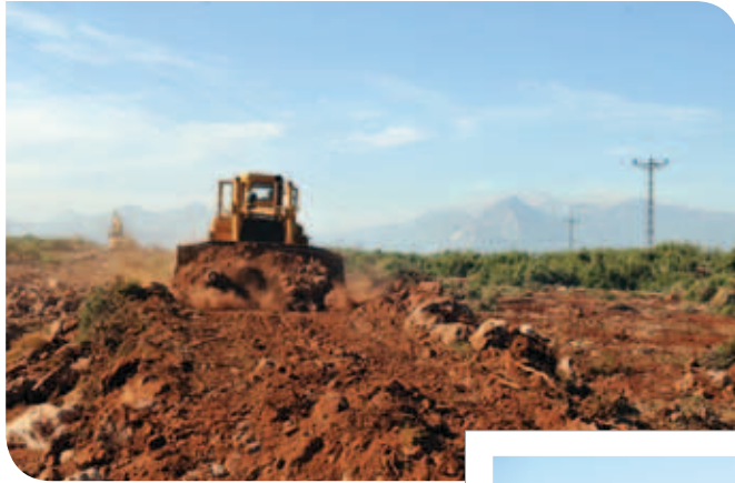
Çankaya Mahallesi-Göçerler Mahallesi Yeni Yol Açım Çalışması
