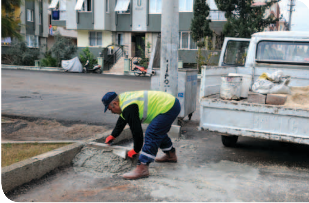
Konteynır Durağı Yapımı
