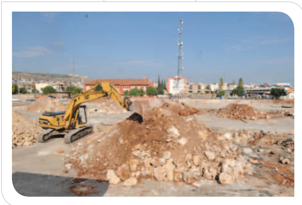
Yeni Mahalle Kapalı Pazar Yeri Yapım Çalışması Devam Etmektedir
