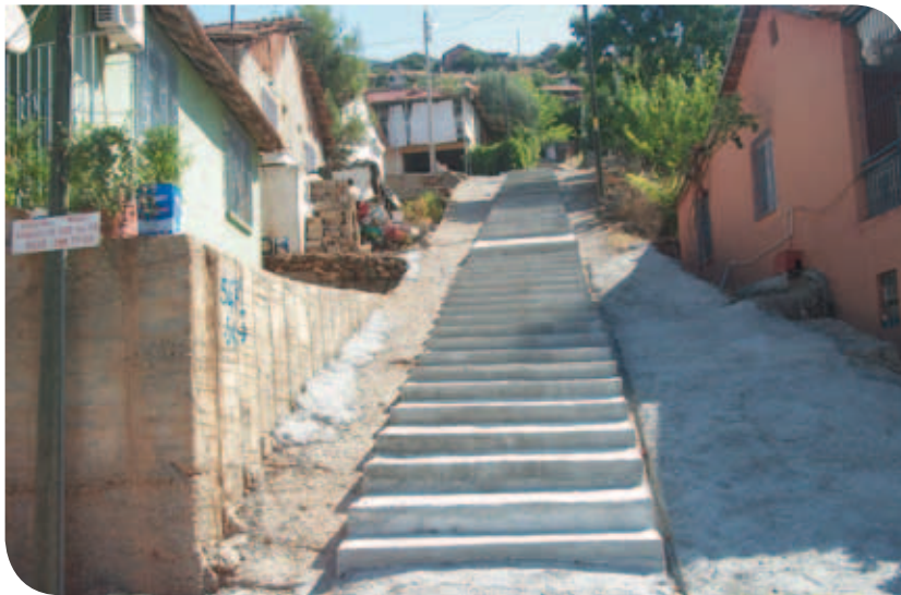
Kazım Karabekir Mah. 4571 Sokak Merdiven Yol Yapımı
