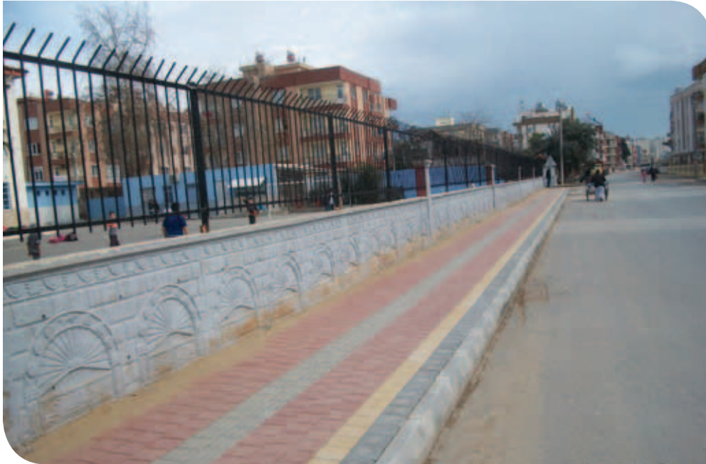
Mareşal Fevzi Çakmak İlköğretim Okulu Bahçe Duvarı Yapım Çalışması
