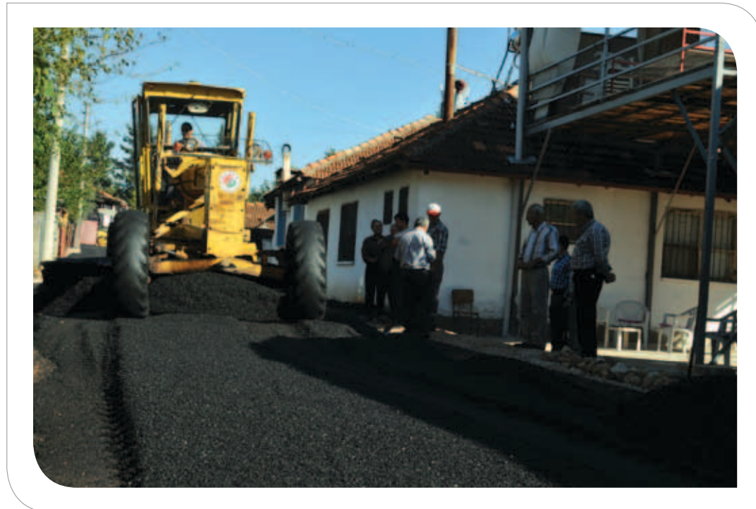
Sıcak Asfalt Serme Çalışması
