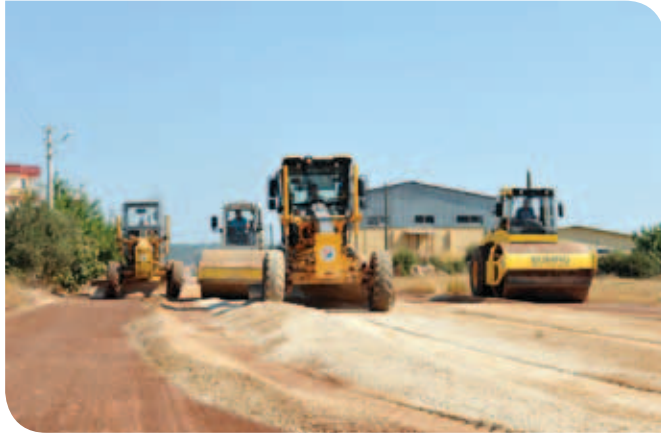
Varsak Karşıyaka Mahallesi Stabilize Yol Yapım Çalışması
