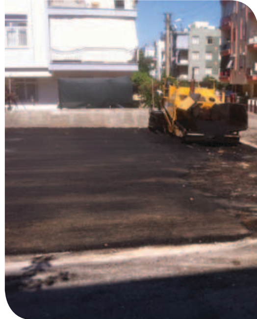
Gündoğdu Mahallesi Otopark Asfalt Çalışması
