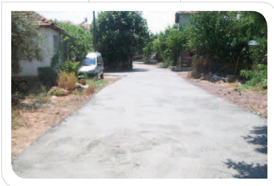
Göçerler Mahallesi Beton Yol Yapımı
