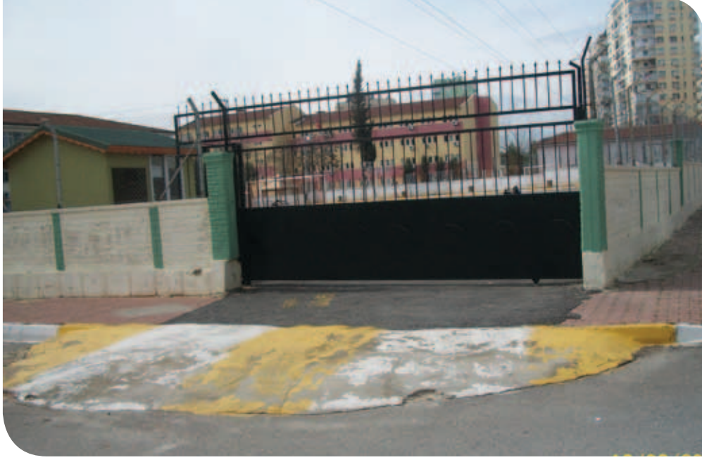
Hüseyin Ak İlköğretim Okulu Bahçesinde Sıcak Asfalt Çalışması
