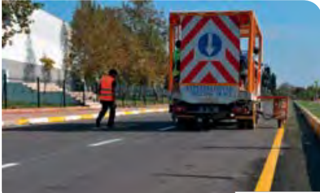
Varsak Demirel Mahallesi Hz. Ebubekir Caddesi Yol Çizgi Çalışması
