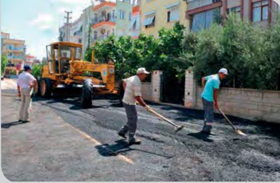
Kuzeyyaka Mahallesi 2515-2518 Sokak Otopark Düzenleme Çalışması
