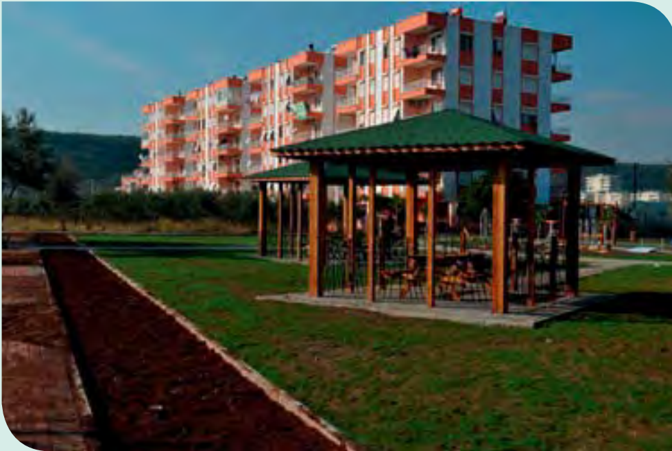
Varsak Karşıyaka Mahallesi 1541-1537 Sokak Pergola Montajı
