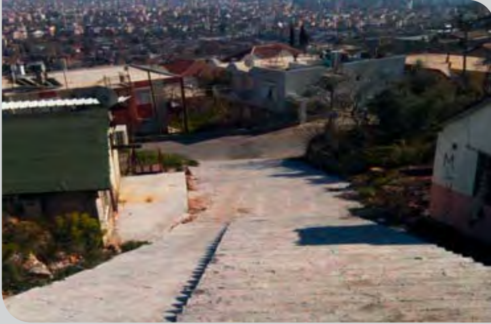
Yavuz Selim Mahallesi 6113 Sokak Merdiven Yol Yapılması Çalışması
