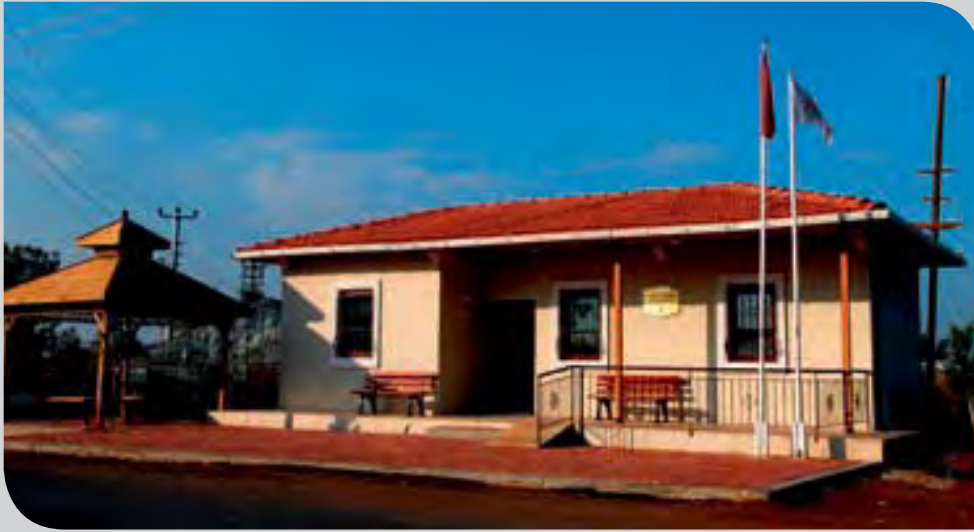
Altınova Düden Mahallesi Muhtarlık Binası
