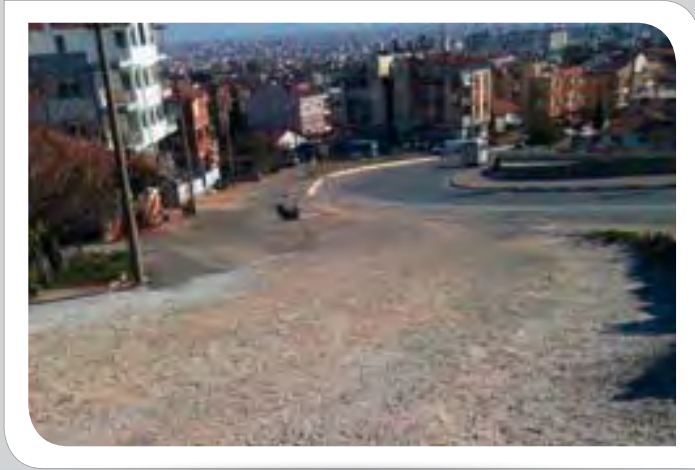
Barış Mahallesi 2924 Sokak Beton Yol Yapılması Çalışması
