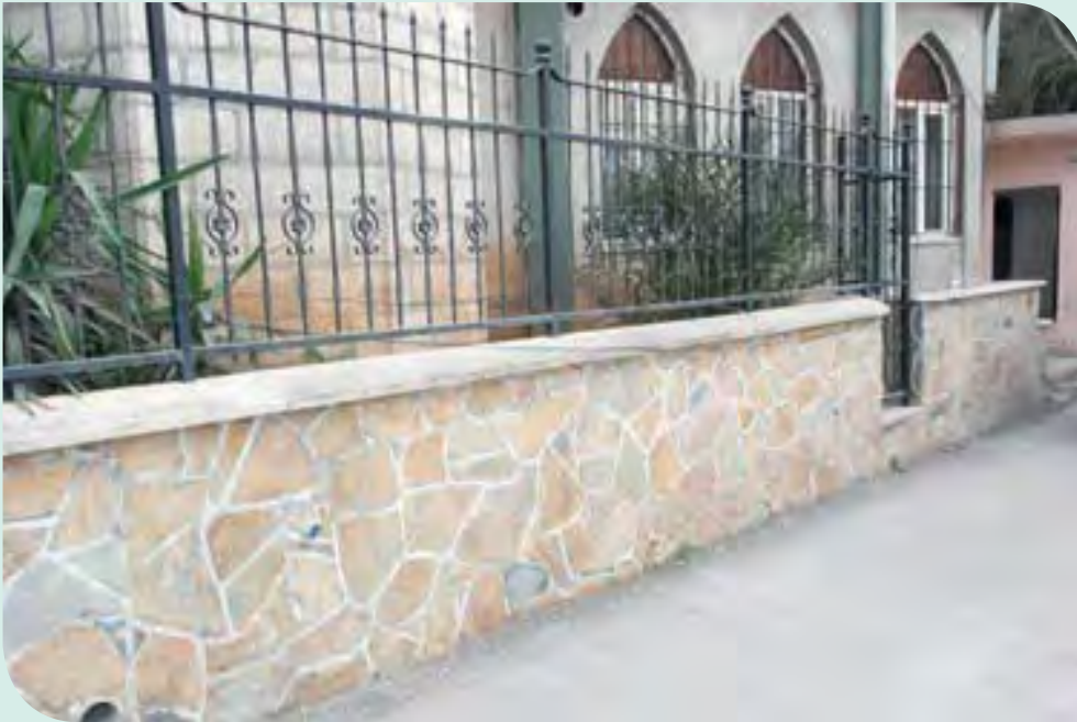
Fatih Mahallesi Çamlık Camisine Çevre Düzenlemesi Yapıldı.
