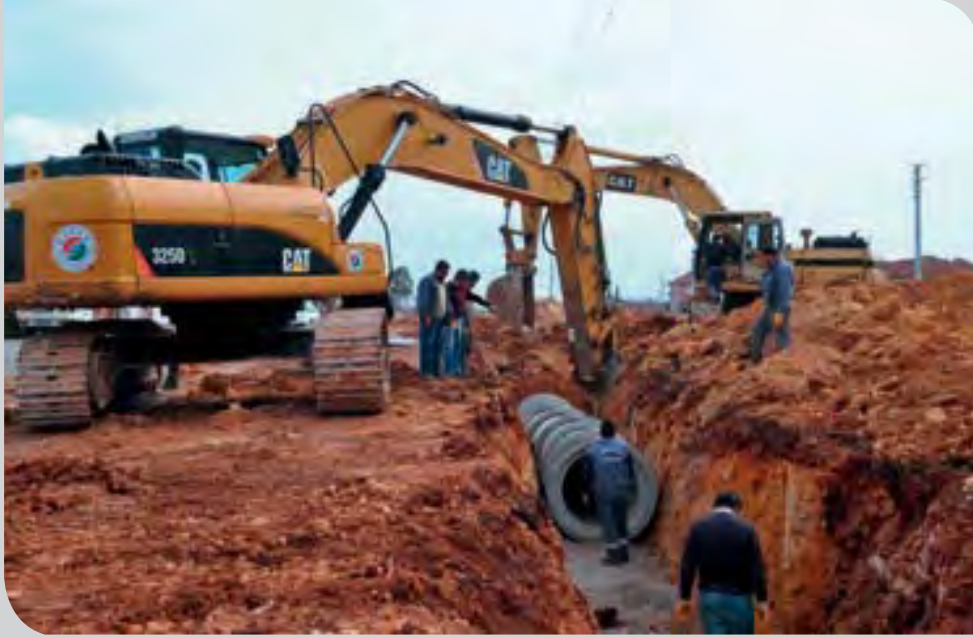
Baraj Mahallesi 5877 Sokak Yağmur Suyu Drenaj ve Menfez Yapımı Çalışması
