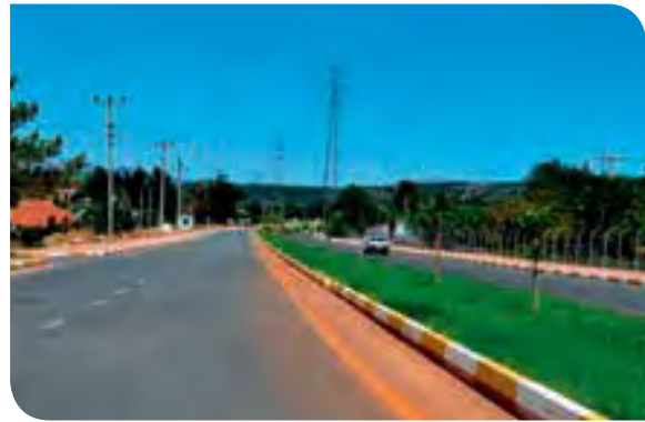
Ünsal Mahallesi 5086 Sokak Orta Refüj Çalışması
