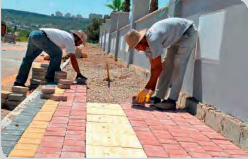
Fevzi Çakmak Mahallesi 6162 Sokak Prefabrik Parke Kaldırım Yapılması
