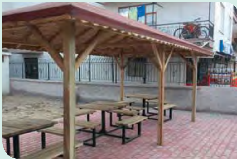
Fabrikalar Mahallesi Ülfet Camisine Çevre Düzenlemesi Yapıldı.
