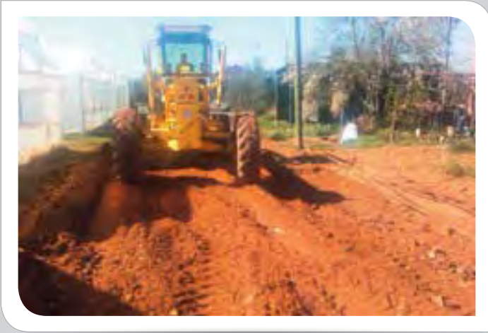
Varsak Demirel Mahallesi 11. Cadde Stabilize Yol Yapılması Çalışması
