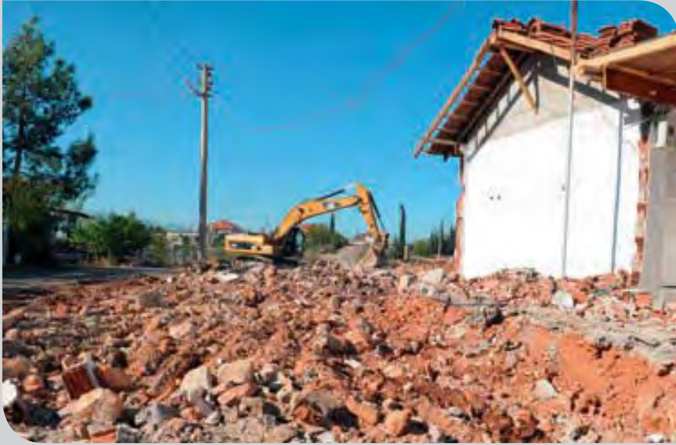
Beşkonak Mahallesi Yeni Yol Açılması Çalışması
