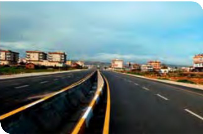
Habibler Mahallesi 6619 Sokak Sıcak Asfalt Çalışması
