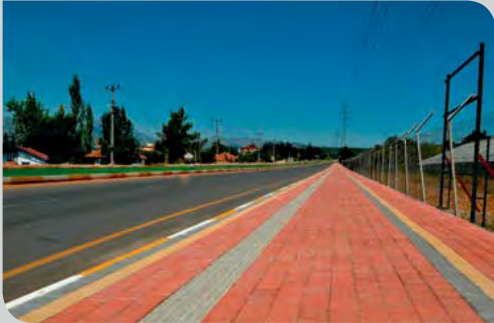
Ünsal Mahallesi 5061 Sokak Prefabrik Parke Kaldırım Yapılması
