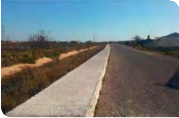
Göksu Mahallesi 6800 Sokak Beton Kaldırım Çalışması
