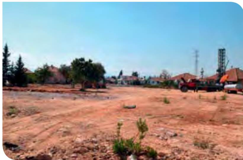
Güneş Mahallesi Sondaj Kuyusu
