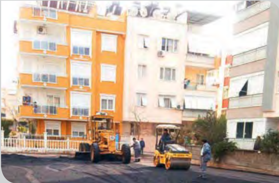
Yeşilyurt Mahallesi 4354-4347 Sokak Otopark Düzenleme Çalışması
