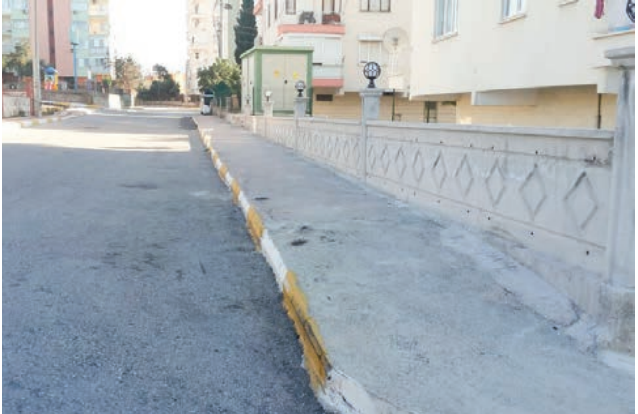
Esentepe Mahallesi Beton Kaldırım Çalışması
