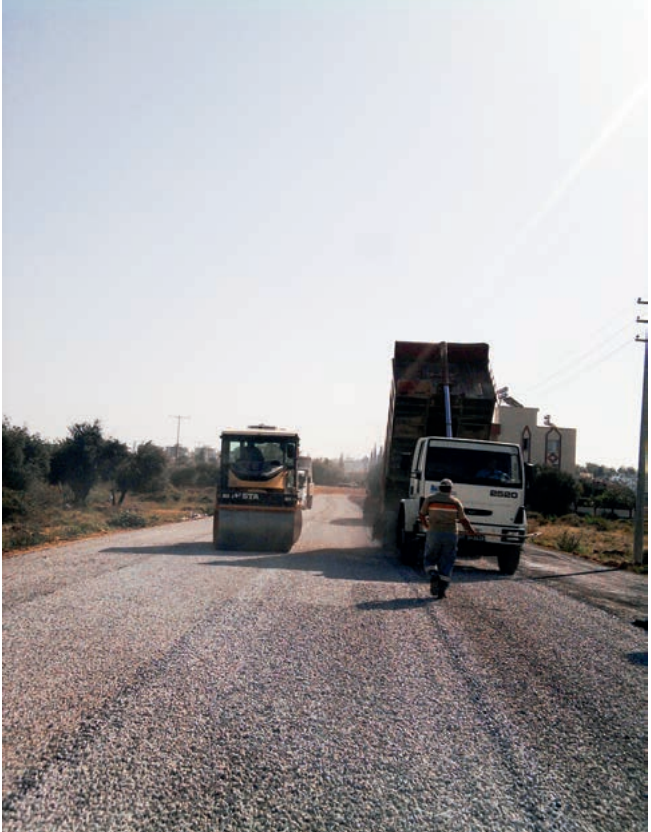
Göçerler Mahallesi Sathi Kaplama Asfalt Çalışması
