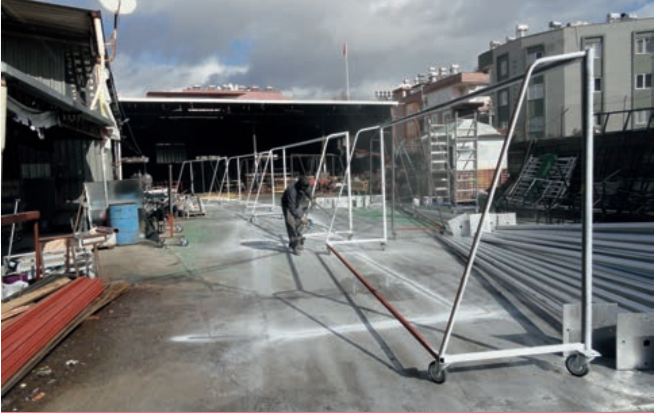
Atölyemizde Kale Direği Yapımı
