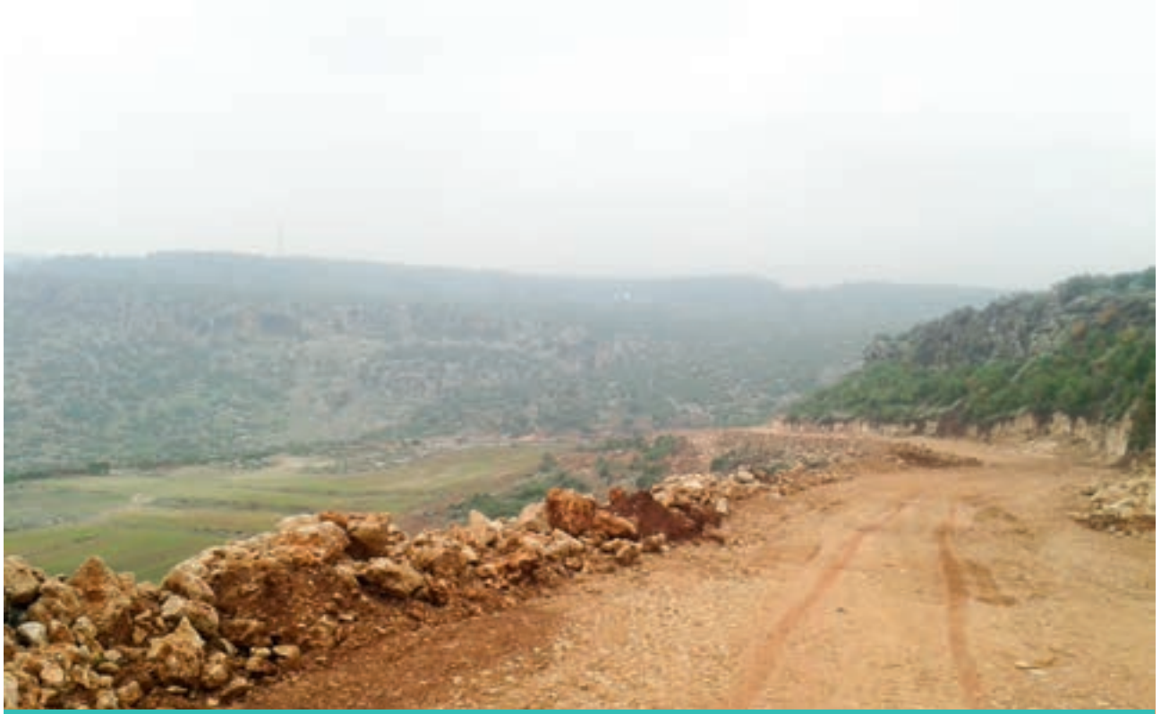
Göçerler Mahallesi'nde Yeni Yol Açım Çalışması
