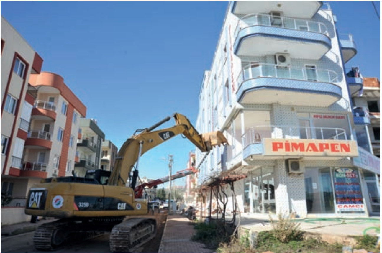
Kaçak Bina Yıkımı
