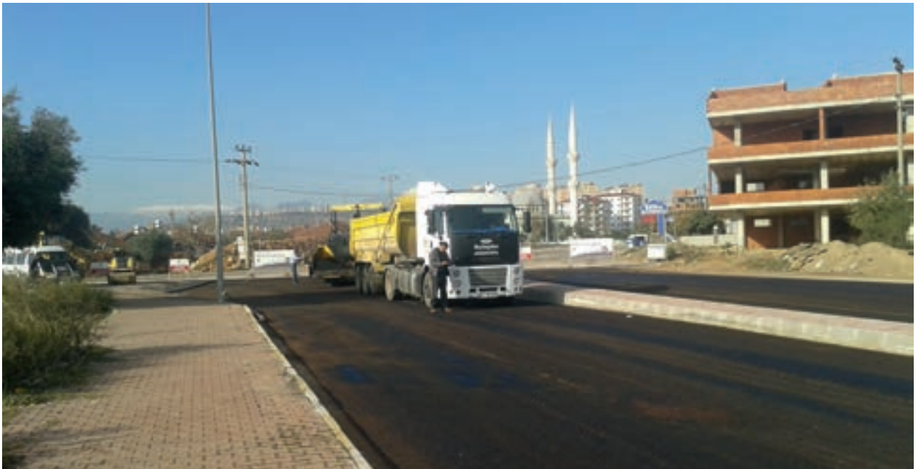
Hüsni Karakaş Mahallesi Sıcak Asfalt Serme Çalışması
