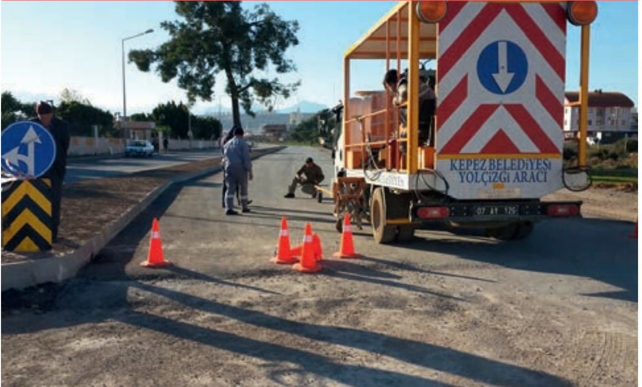
Hüsnü Karakaş Mahallesi Yol Çizgi Çalışması
