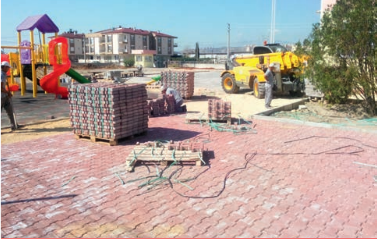
V. Şelale Mahallesi Alpay Kalkan Delen Anaokulunda Çevre Düzenlemesi Yapıldı.
