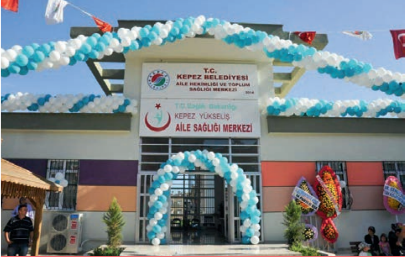
Yükseliş Mahallesi Sağlık Ocağı
