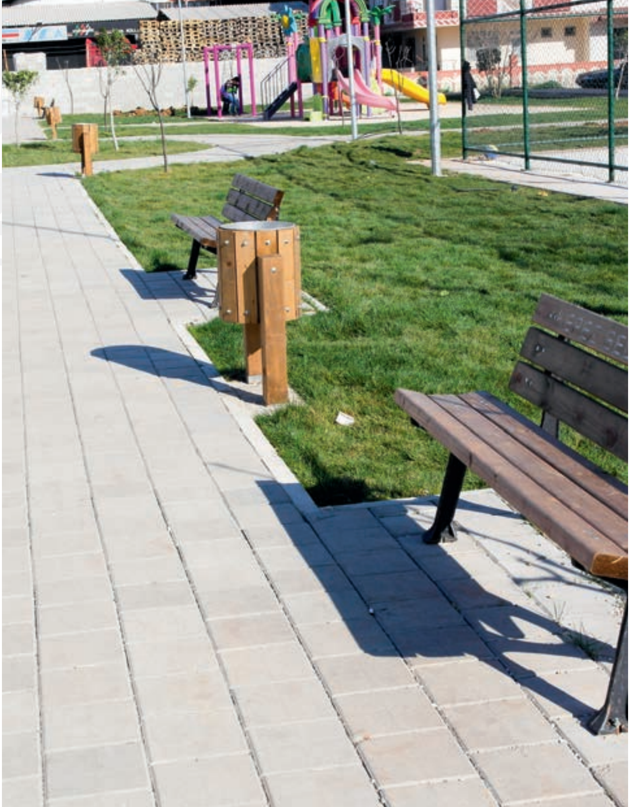
Parklarımıza Bank ve Çöp Sepeti Montajı Yapılmaktadır
