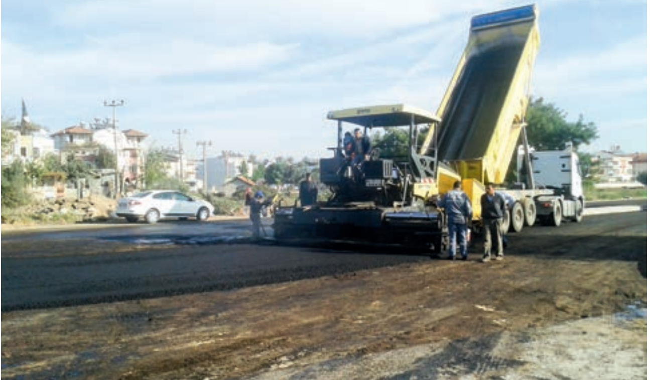
Hüsnü Karakaş Mahallesi Sıcak Asfalt Serme Çalışması
