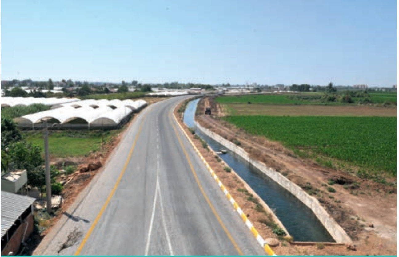
Altınova Hanımeli Sokak Asfalt Çalışması
