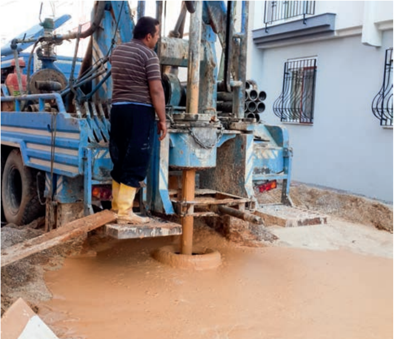
Kanal Mahallesi 4700 Sokak Sondaj Kuyusu Açılması
