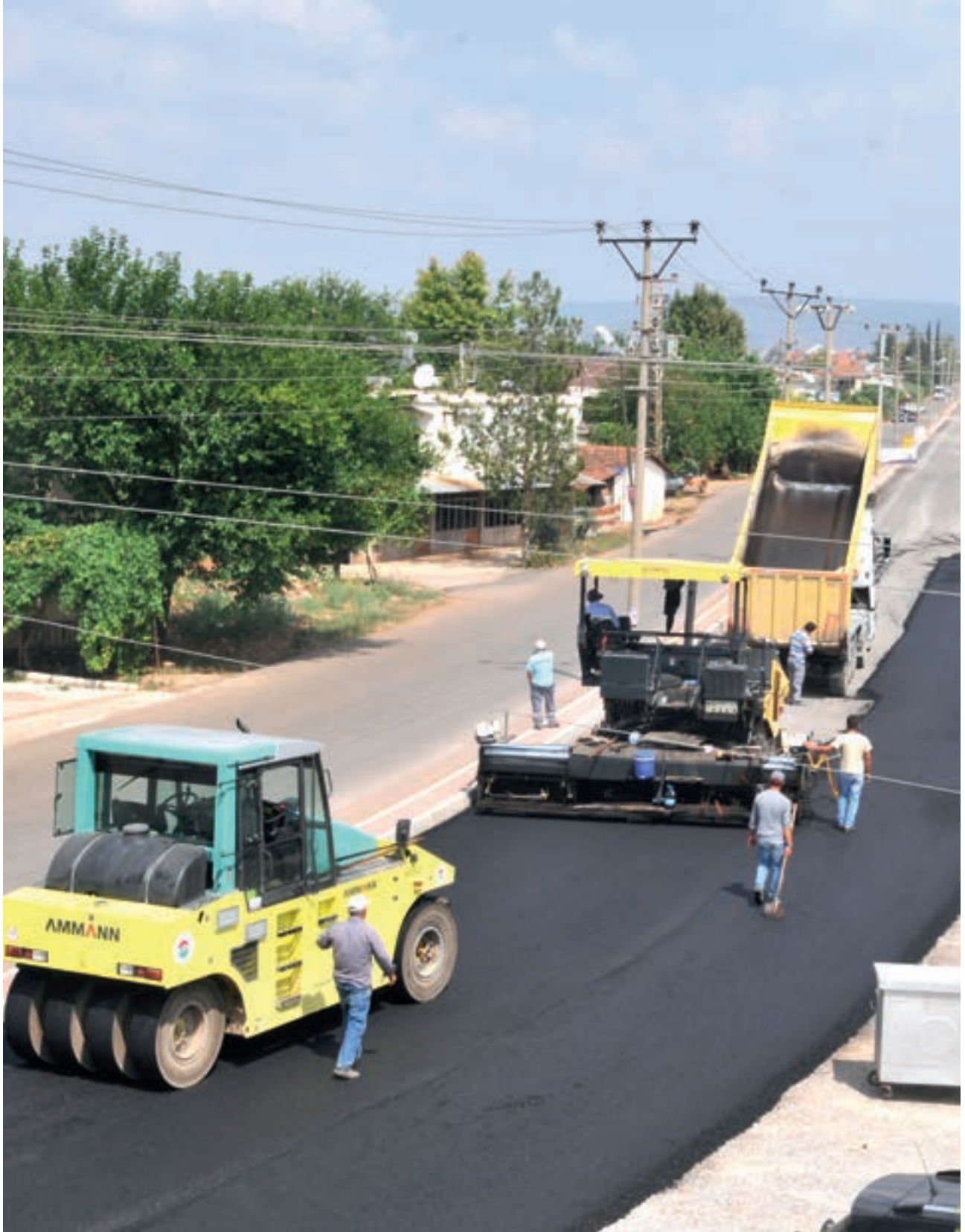
Zeytinlik Mahallesi Atatürk Caddesi Sıcak Asfalt Serimi
