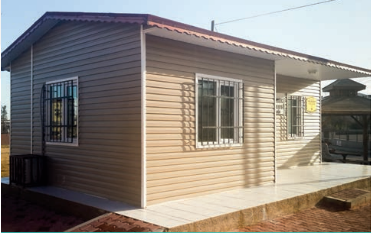
Yeniemek Mahallesi Muhtarlık Hizmet Binası
