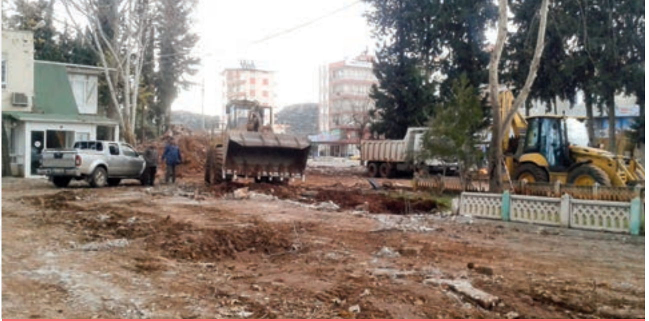
Varsak Karşıyaka Mahallesinde Yeni Yol Açım Çalışması
