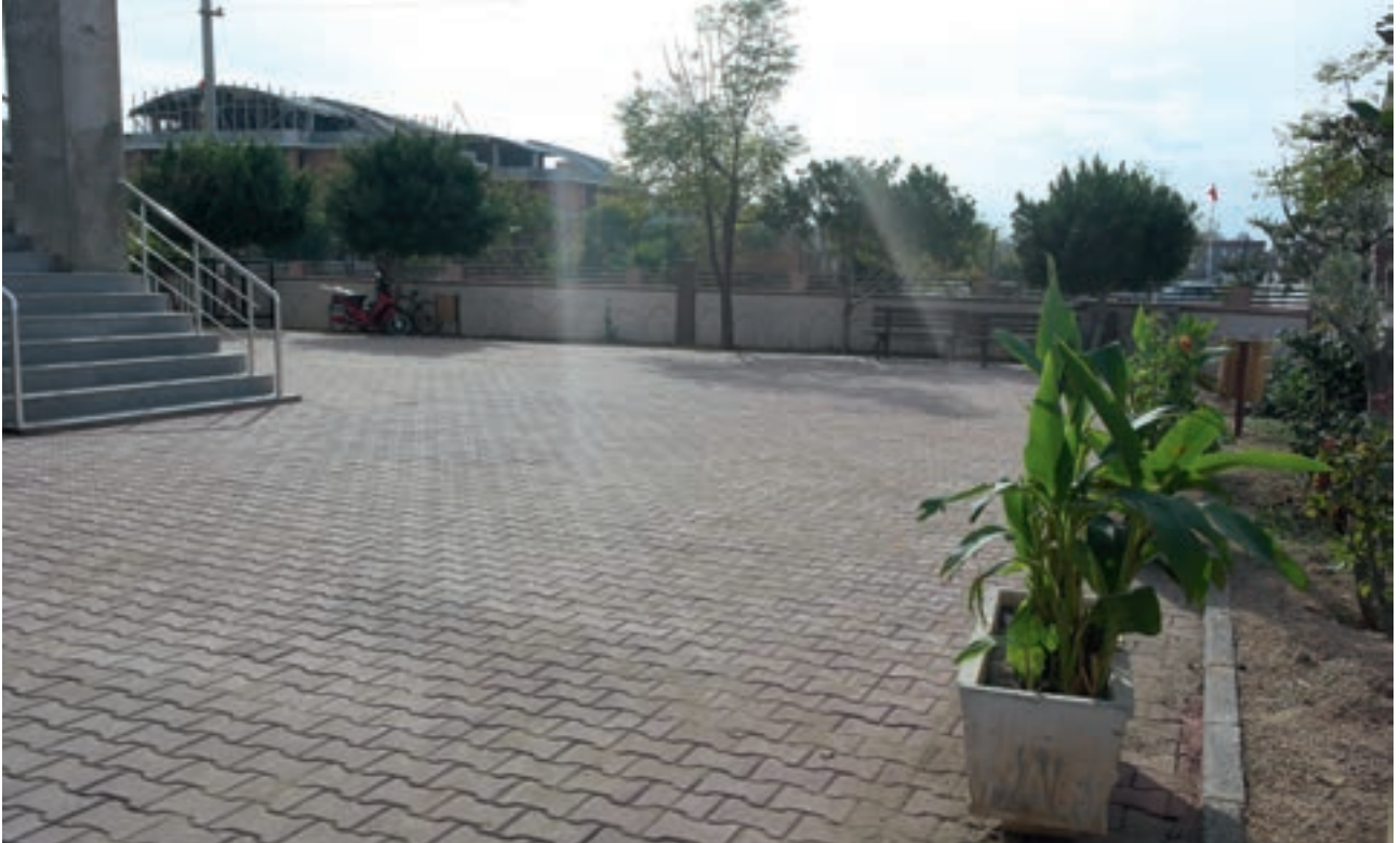
Altınova Hz. Hamza Cami Çevre Düzenlemesi Yapıldı
