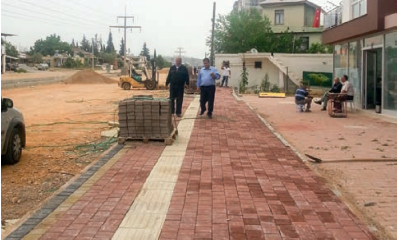
Şafak Mahallesi Prefabrik Parke Kaldırım Çalışması
