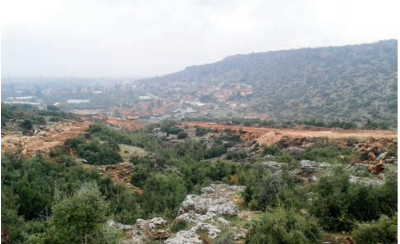
Göçerler Mahallesi'nde Yeni Yol Açım Çalışması
