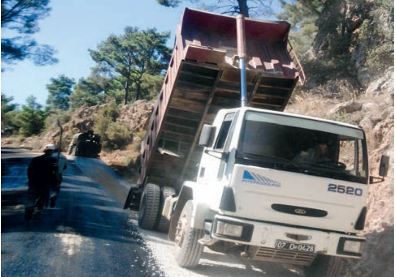
Duacı Mahallesi-Kindıra Yolu Sathi Kaplama Asfalt Çalışması
