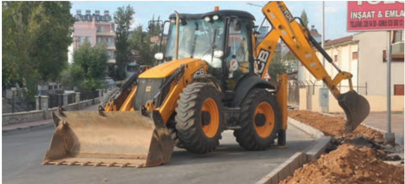
Şelale Caddesi Kaldırım Çalışması
