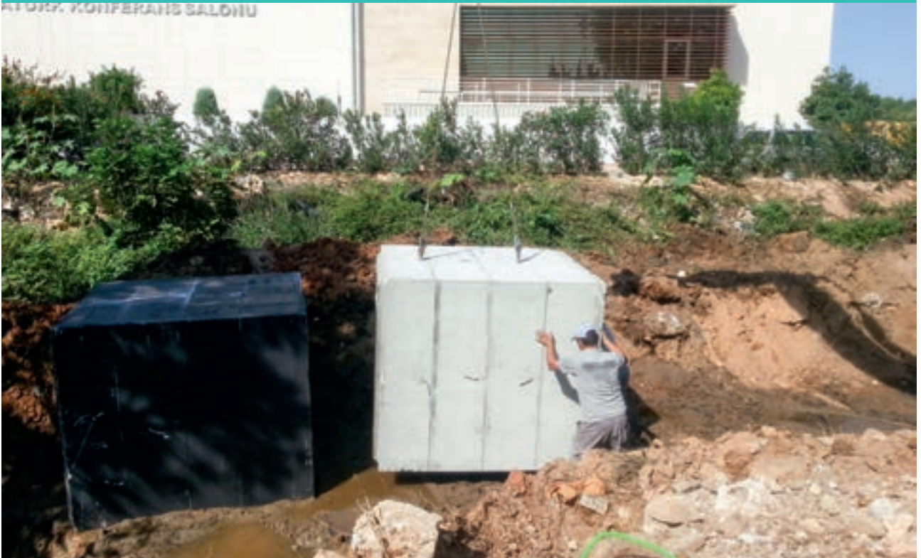
Göksu Mahallesi Menfez Çalışması
