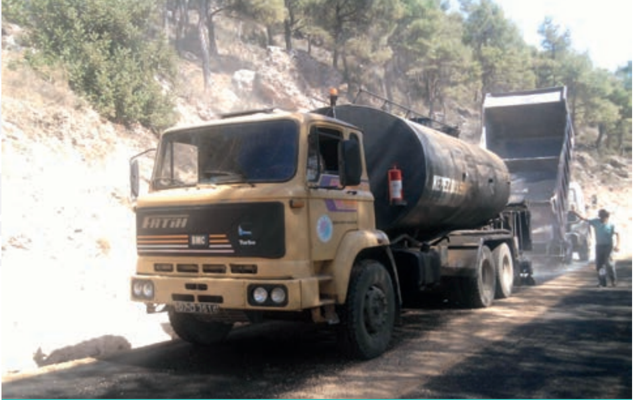
Duacı Mahallesi-Kindıra Yolu Sathi Kaplama Asfalt Çalışması
