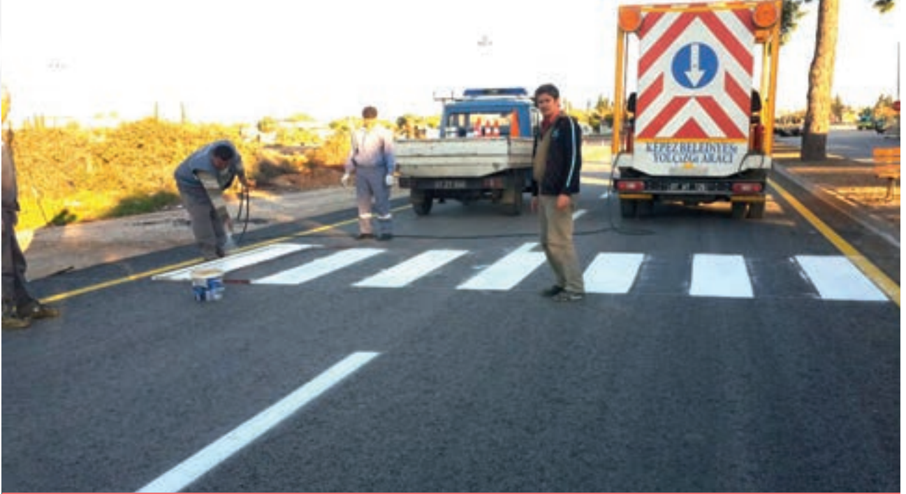
Hüsnü Karakaş Mahallesi Yol Çizgi Çalışması
