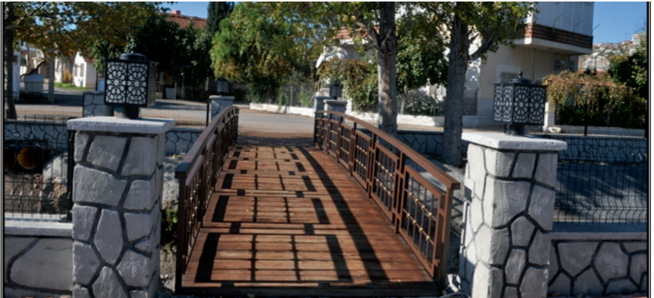
Kanal Boyu Köprü ve Korkuluk Montajı Yapıldı
