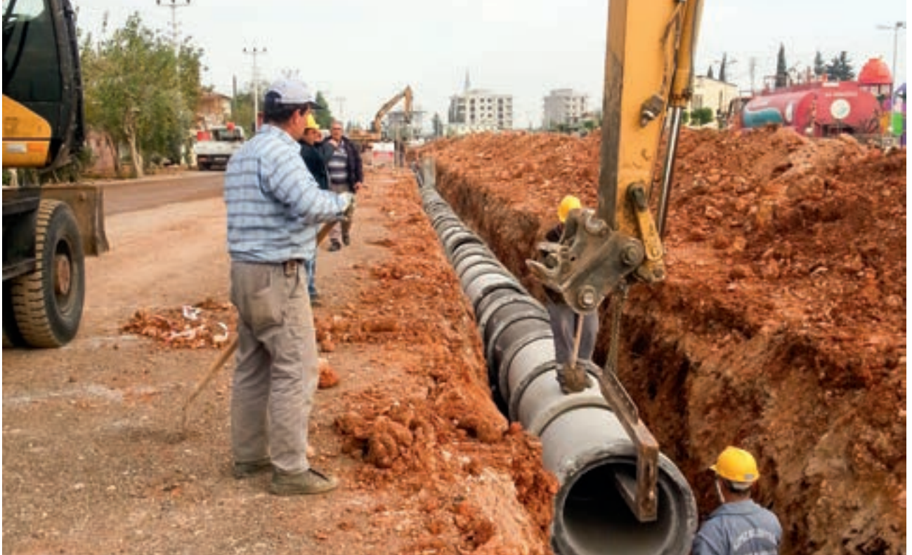
Hüsnü Karakaş Mahallesi Menfez Çalışması
