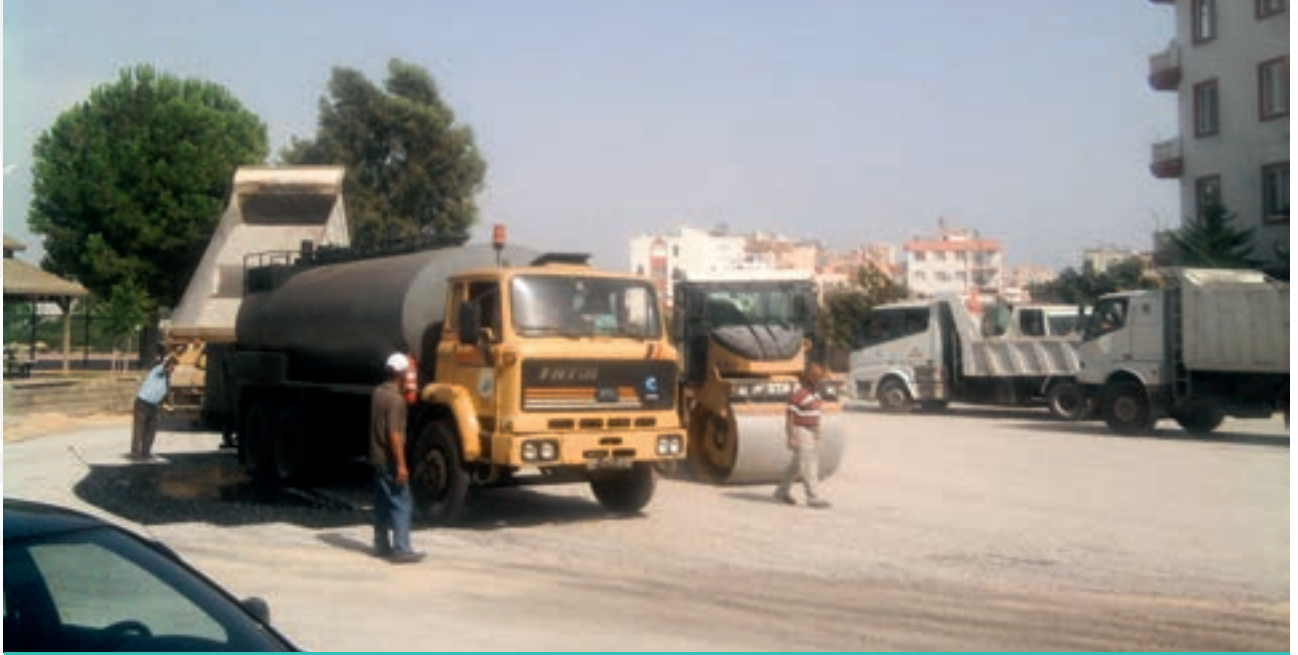
Varsak Karşıyaka Mahallesi Sathi Kaplama Asfalt Çalışması
