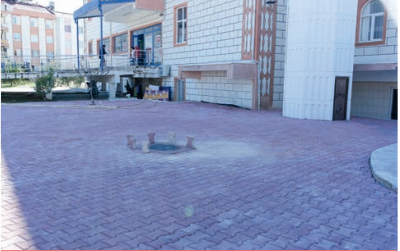
Gülveren Mahallesi Yeşilyurt Camii Çevre Düzenlemesi Yapıldı.
