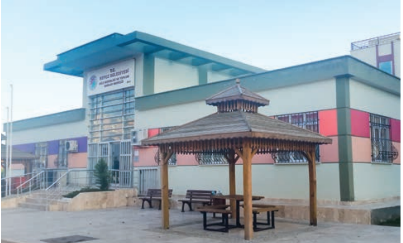
Yükseliş Mahallesi Sağlık Ocağı
