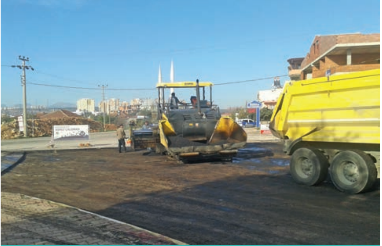
Hüsnü Karakaş Mahallesi Sıcak Asfalt Serme Çalışması
