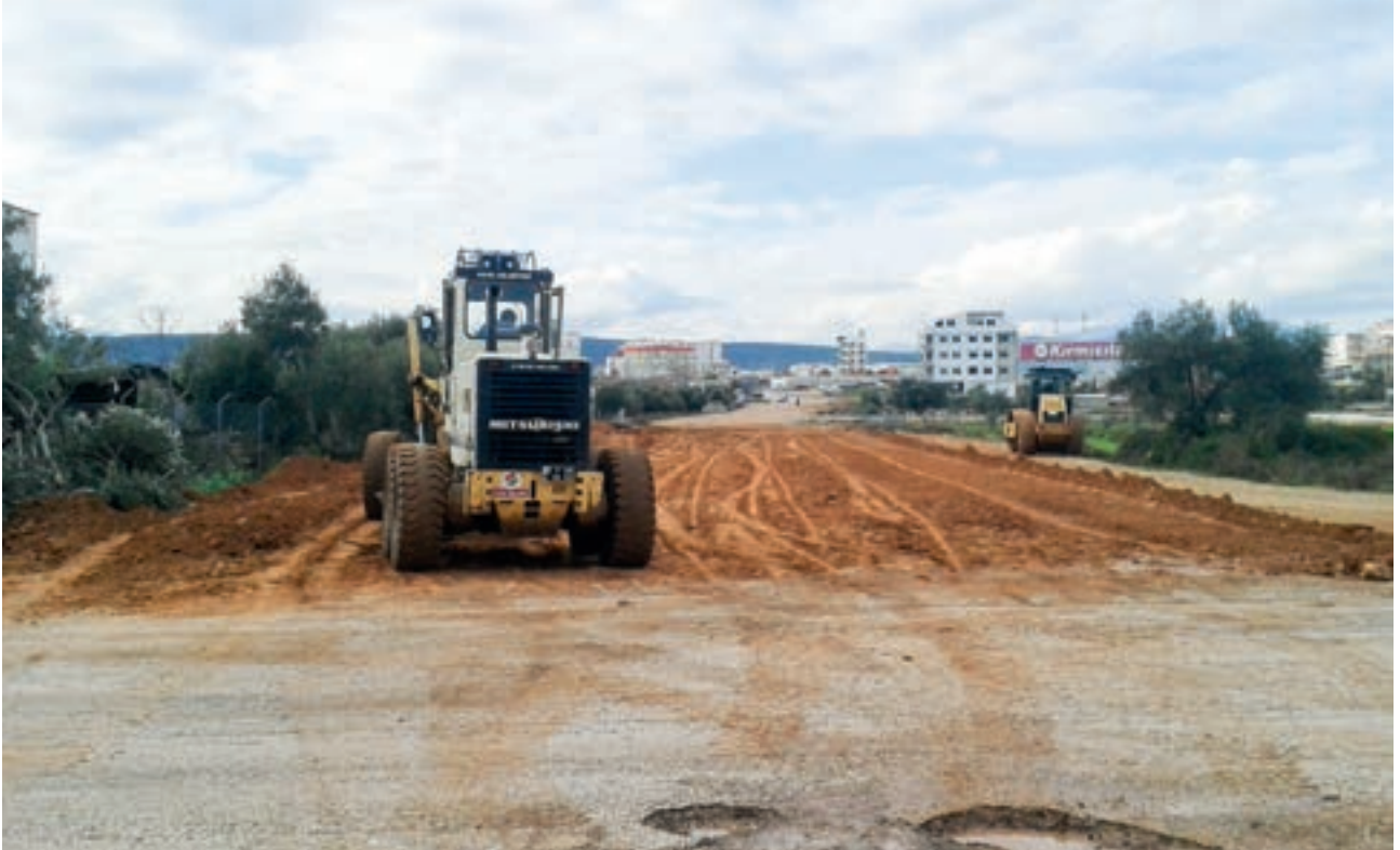
Varsak Demirel Mahallesi 11.Cadde Stabilize Yol Yapımı Çalışması
