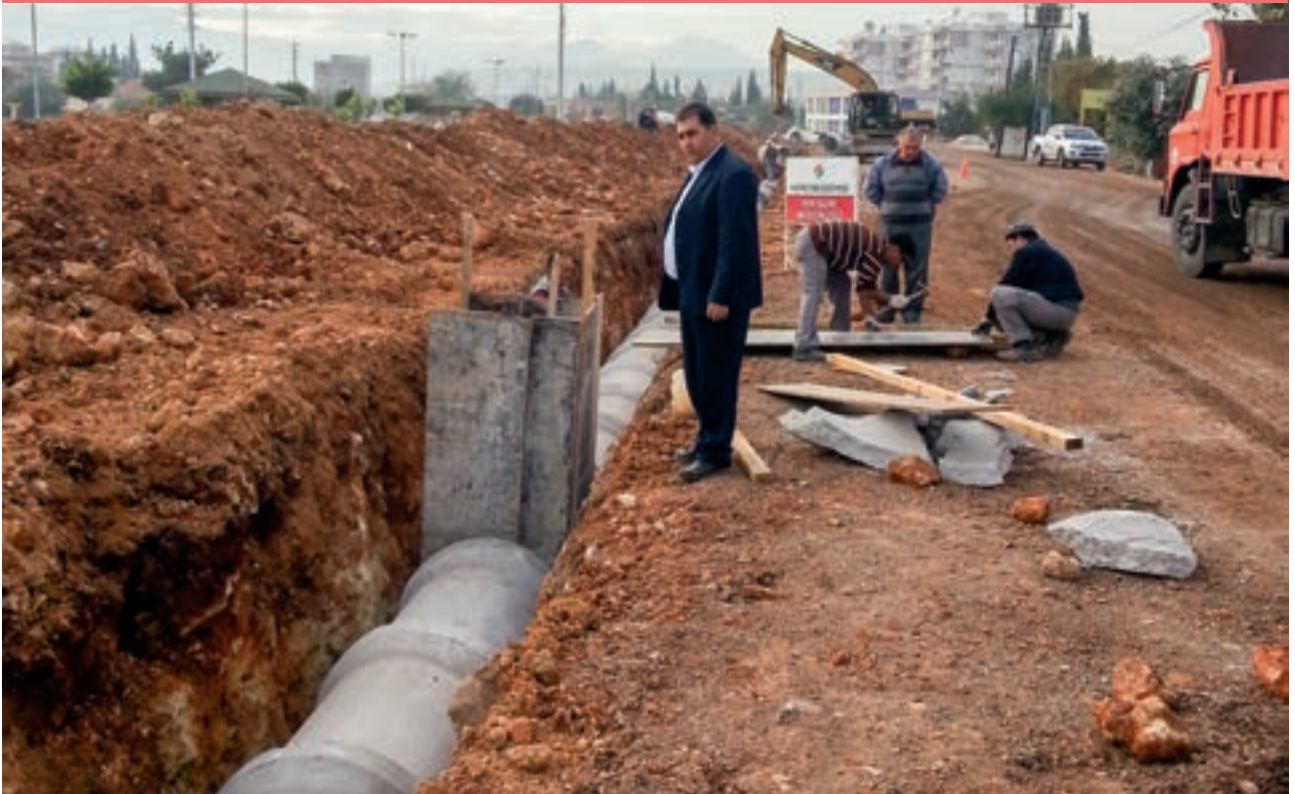
Hüsnü Karakaş Mahallesi Menfez Çalışması
