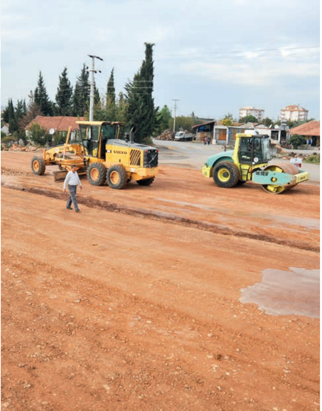
Hüsnu Karakaş Mahallesi Fatih Rüştü Zorlu Caddesi Stabilize Yol Yapımı Çalışması
