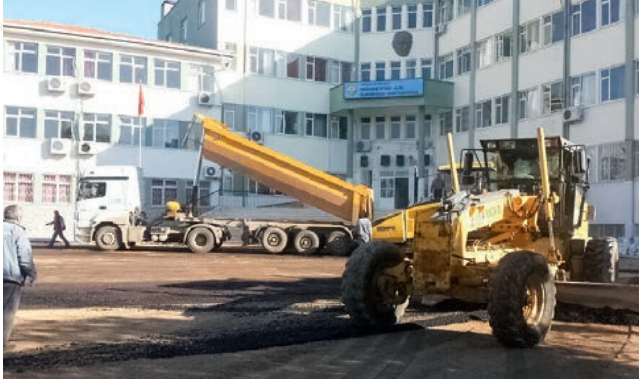
Atatürk Mahallesi Hüseyin Ak İlkokulu / Ortaokulu Bahçe Düzenlemesi Asfalt Dökümü
