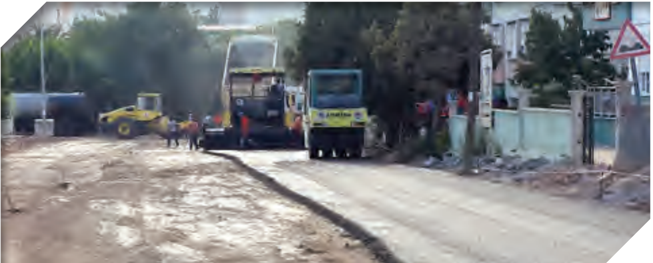
Fabrikalar Mahallesi Sıcak Asfalt Serim Çalışması
