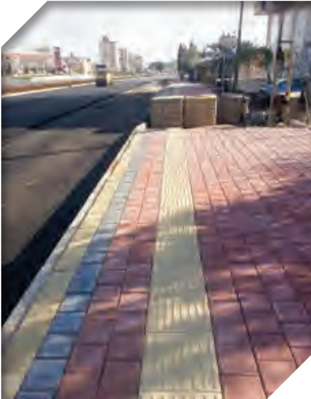
Varsak Menderes Mahallesi-Hamza Taş Bulvarı Prefabrik Kaldırım Çalışması
