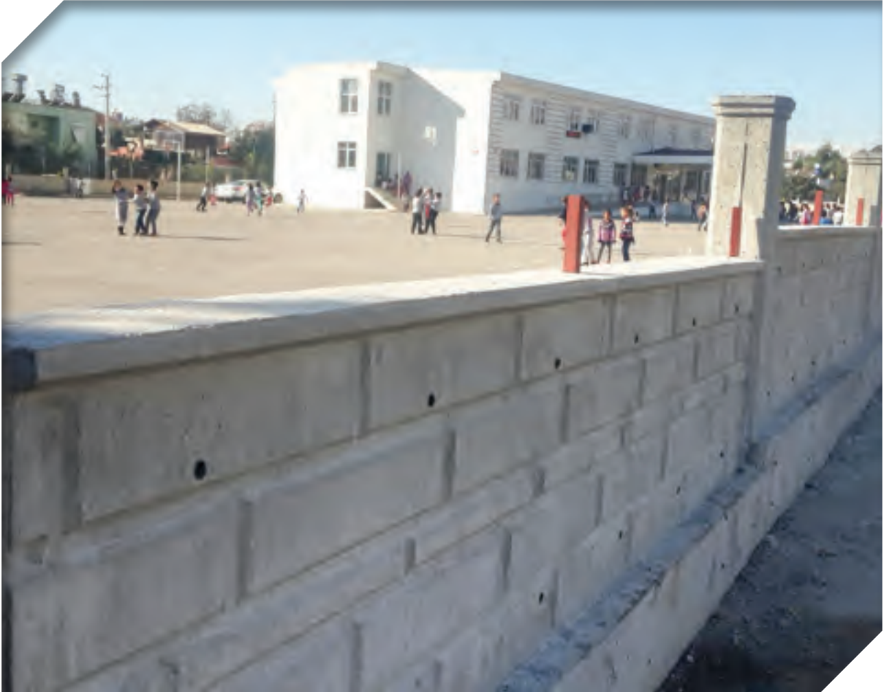
Yeniemek Mahallesi Çevre Duvarı Çalışması
