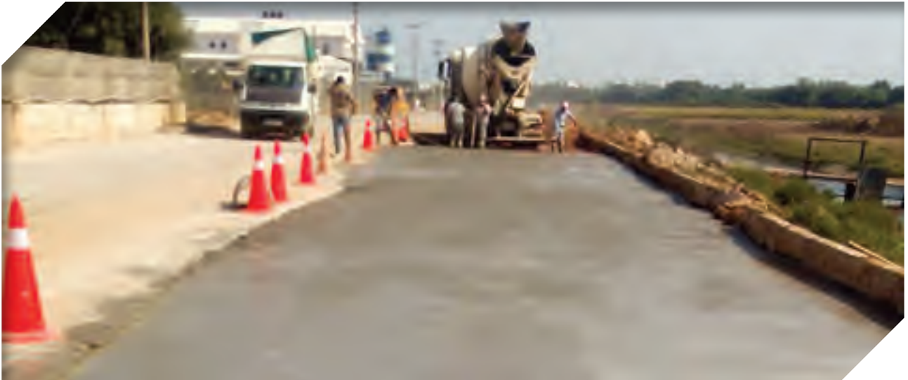
Altınova Sinan Mahallesi Hanımeli Sokak Beton Yol Çalışması
