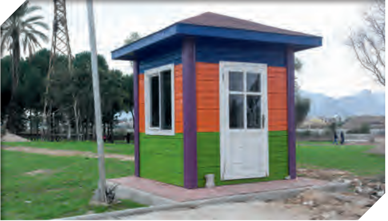
Atölyemizde İmalatı Yapılan Güvenlik Kulübesinin Dokuma Alanına Montajı Yapıldı
