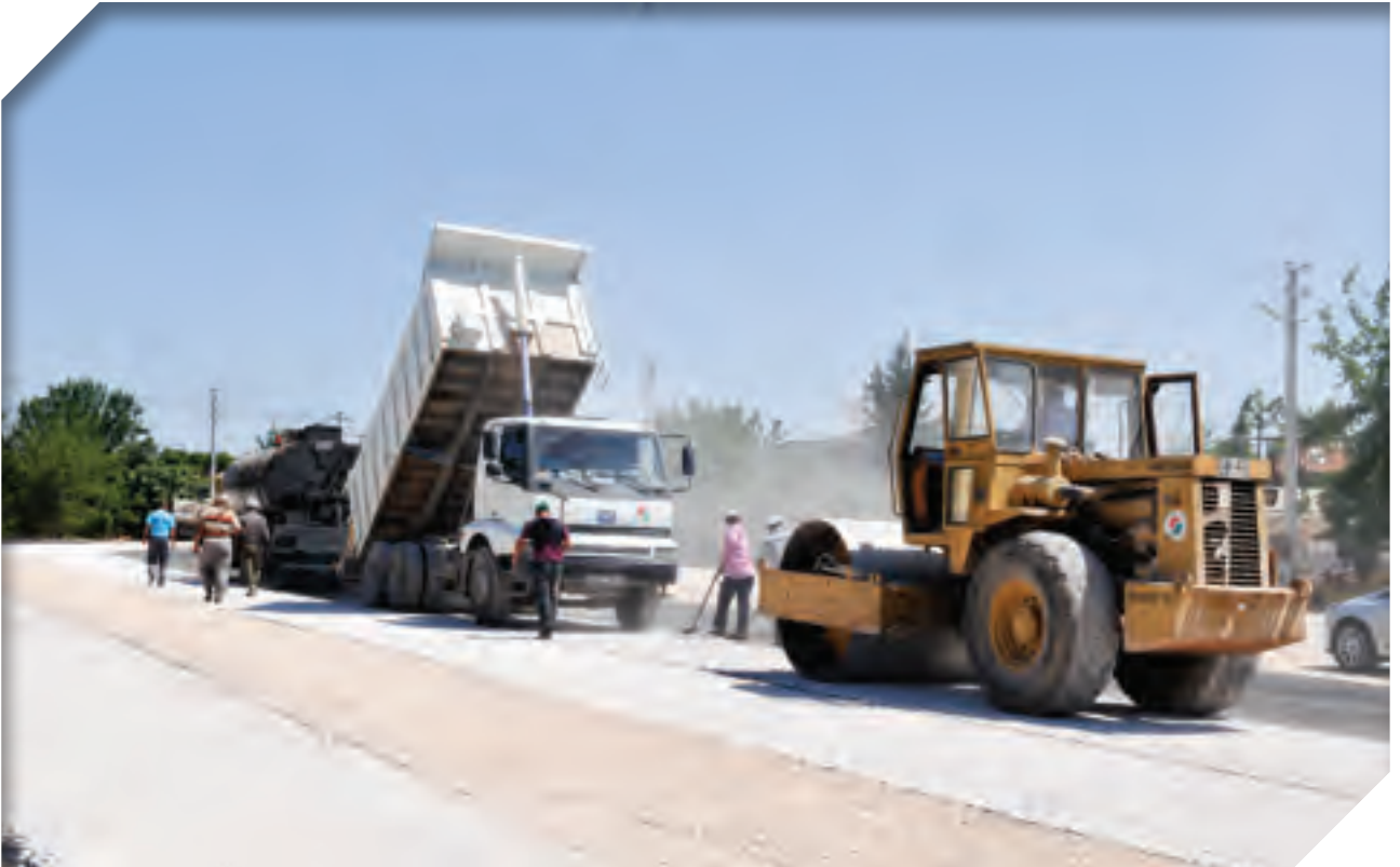
Habibler Mahallesi Sathi Kaplama Asfalt Çalışması
