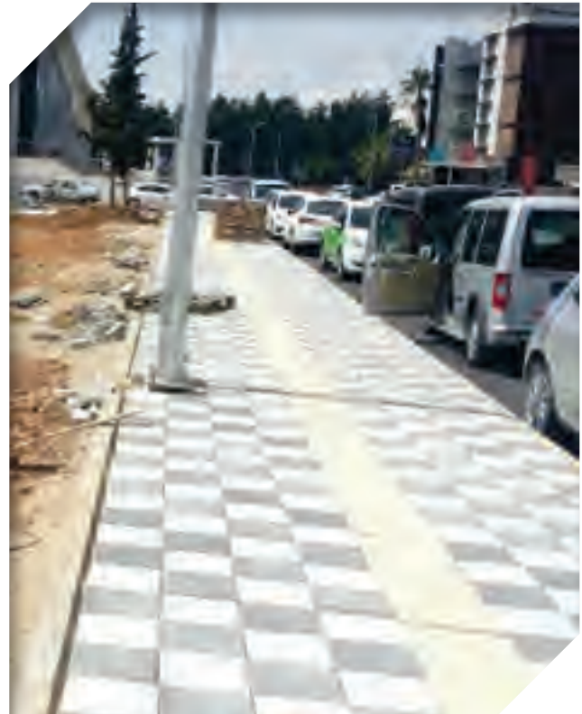
Yeşiltepe Mahallesi Halide Edip Adıvar Caddesi Kaldırım Çalışması
