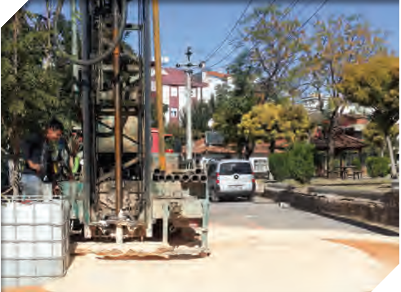
~~~~~ Düdenbaşı Mahallesi Sondaj Kuyusu Açım Çalışması
