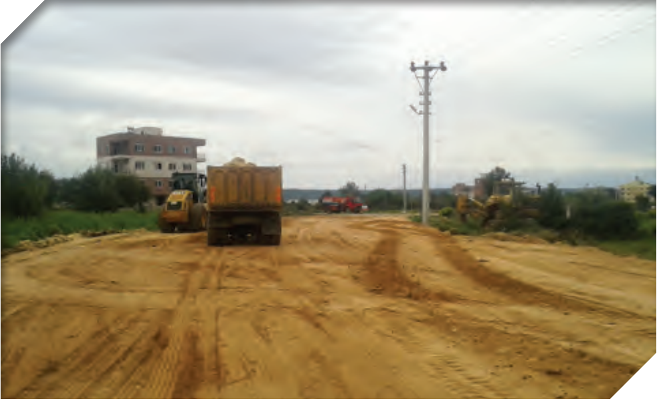
Varsak Karşıyaka Mahallesi Stabilize Yol Yapımı
