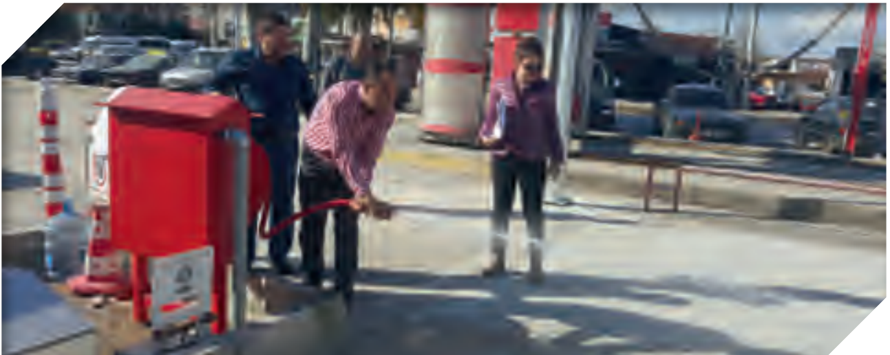
Benzin İstasyonu Yangın Söndürme Sisteminin Kontrolü
