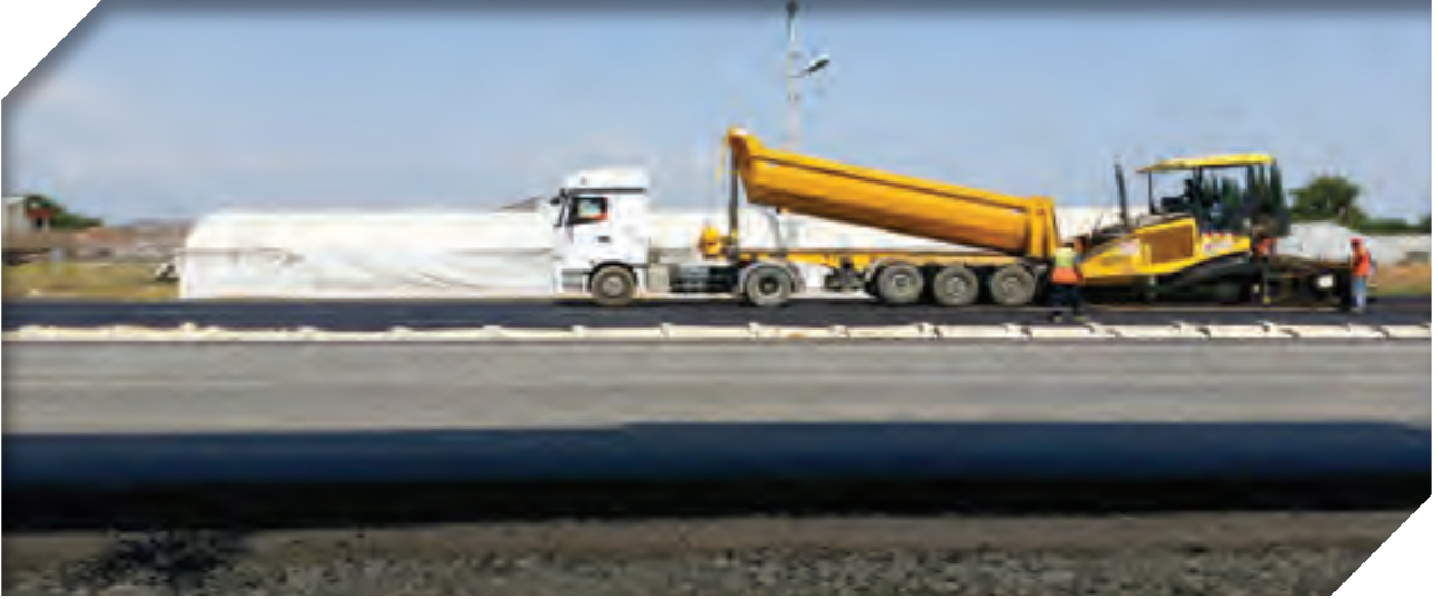
Suphi Türel Caddesi Sıcak Asfalt Serim Çalışması
