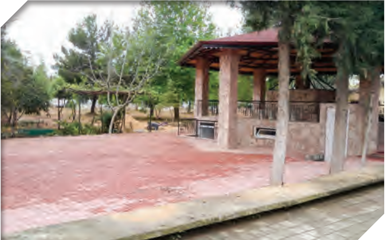
Varsak Karşıyaka Mahallesi Yeni Camiye Şadırvan Yapıldı.
