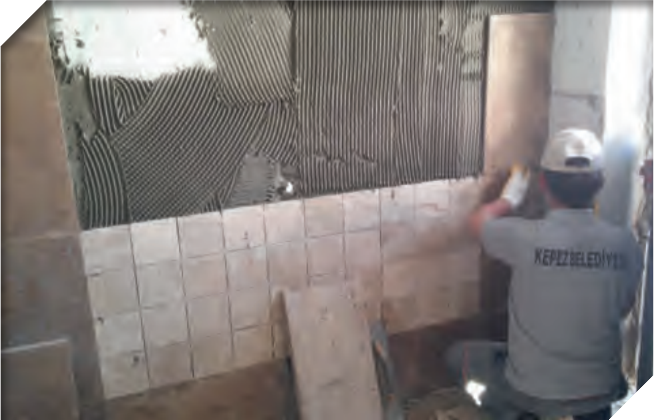
Ahatlı Mahallesi Fatih Caminde Fayans Çalışması Yapıldı.
