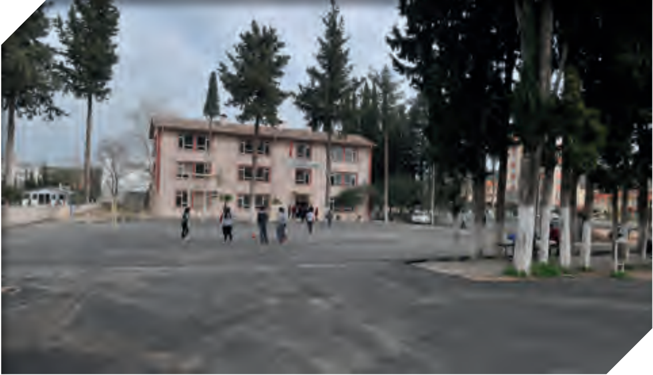
Varsak Lisesi Bahçesi Sıcak Asfalt
