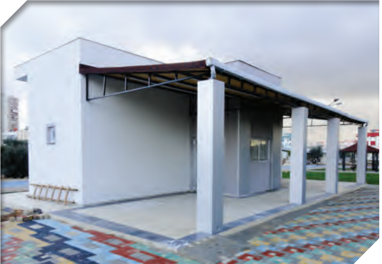
Varsak Ayanođlu Mahallesi Semt Spor Sahası Soyunma Odaları
