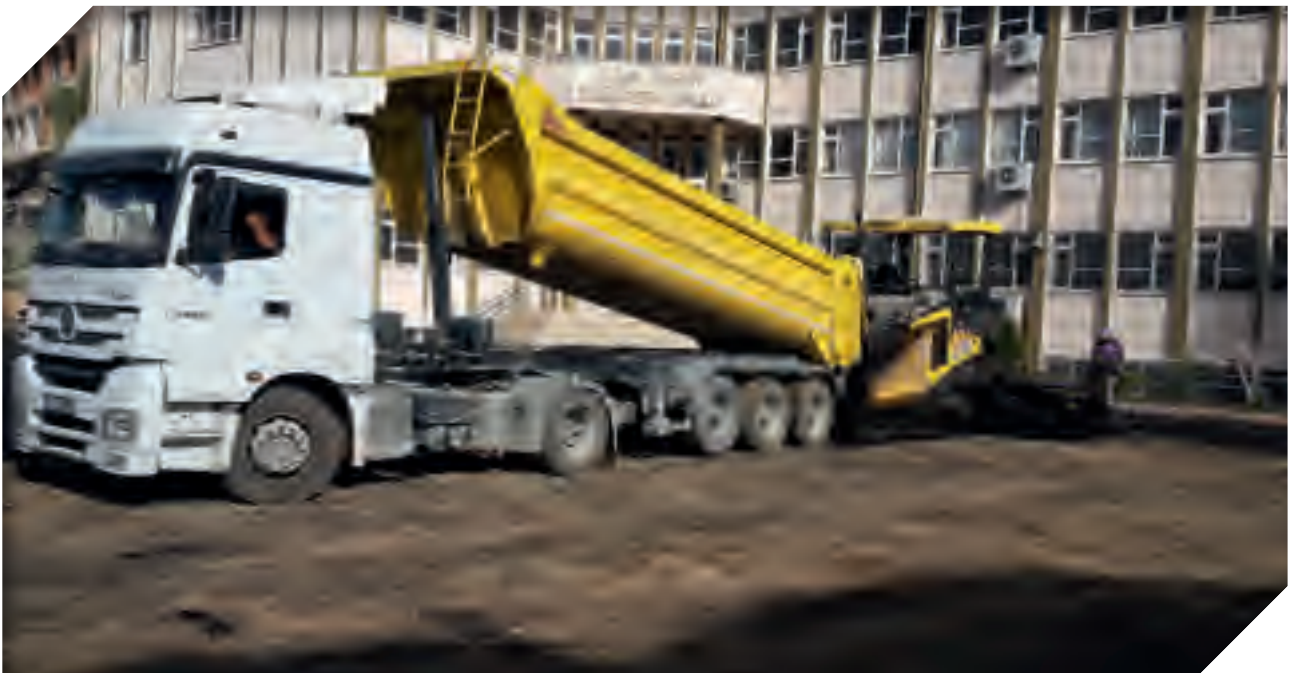
Fabrikalar Mahallesi Kaan Turan İlköğretim Okulu Sıcak Asfalt Serimi
