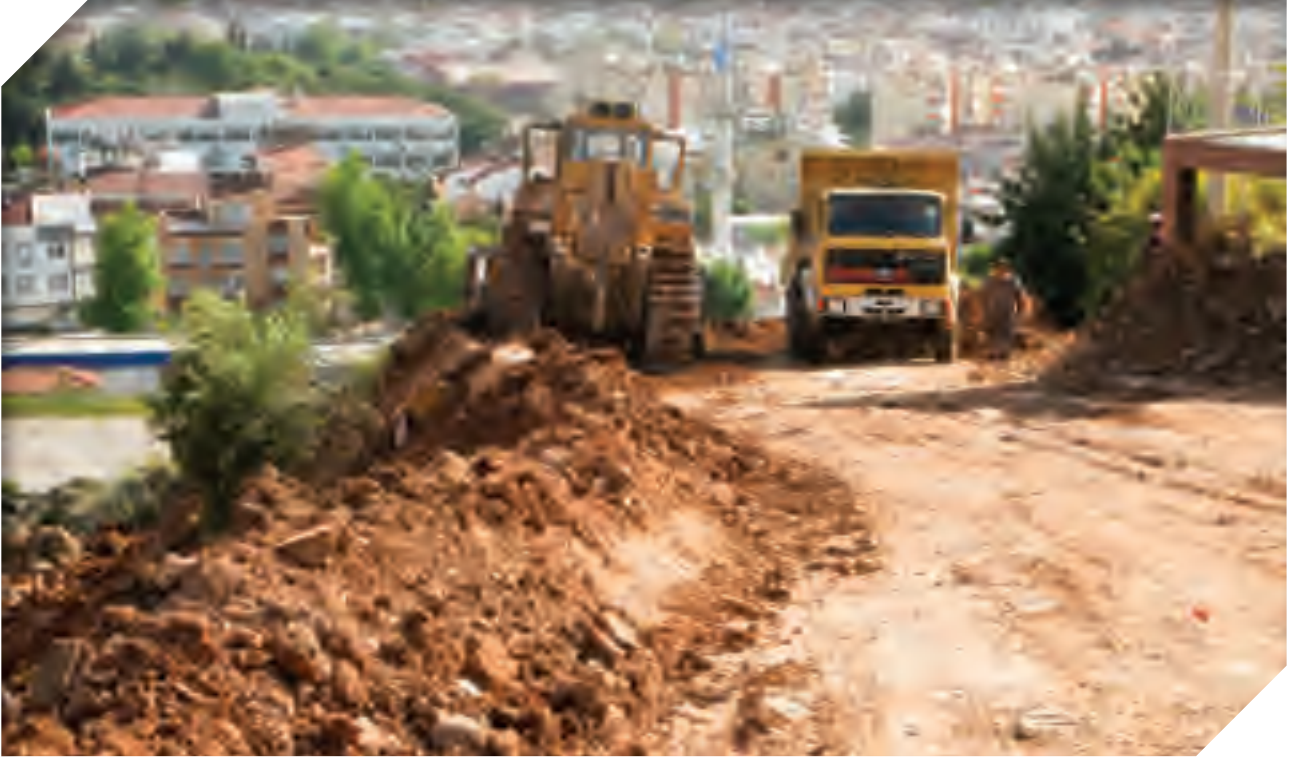
Barış Mahallesi Yeni Yol Açımı Çalışması
