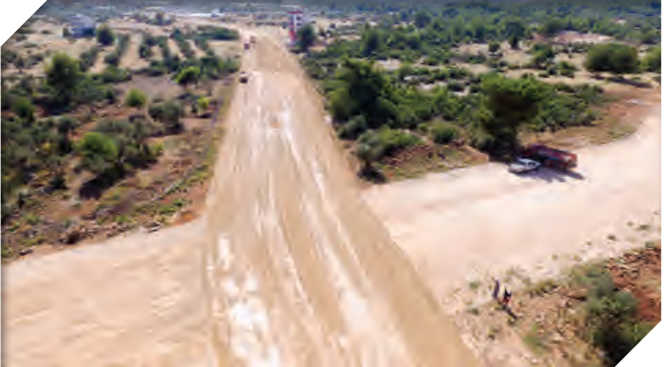
Varsak Karşıyaka Mahallesi Yeni Yol Açımı Çalışması
