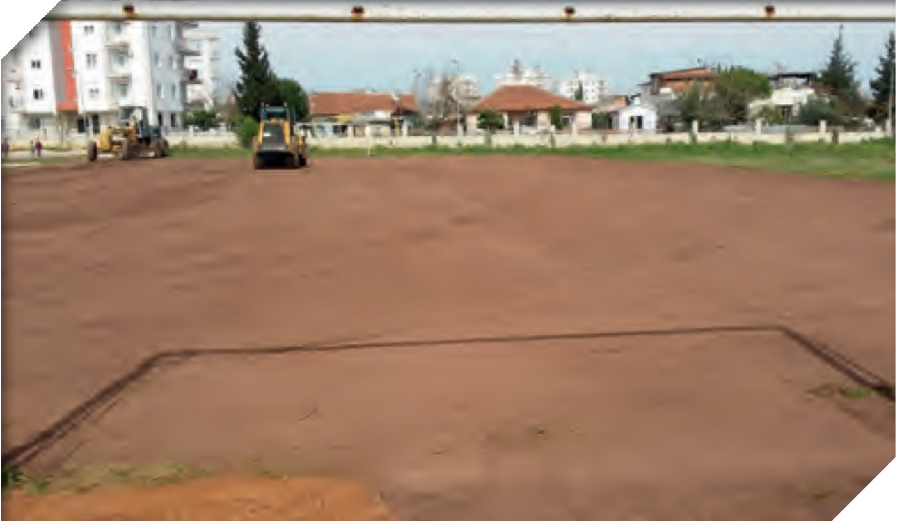
Kepez Orta Okulu Futbol Sahası Yapımı
