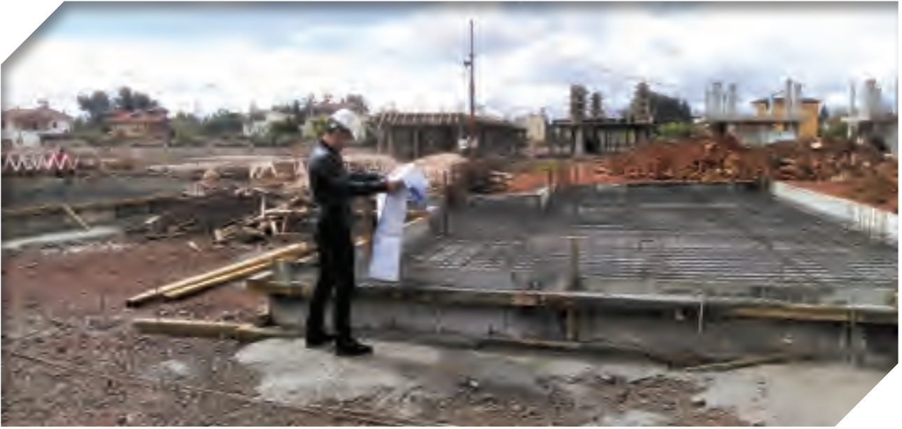
Aplikasyon Kontrolü Yapılması
