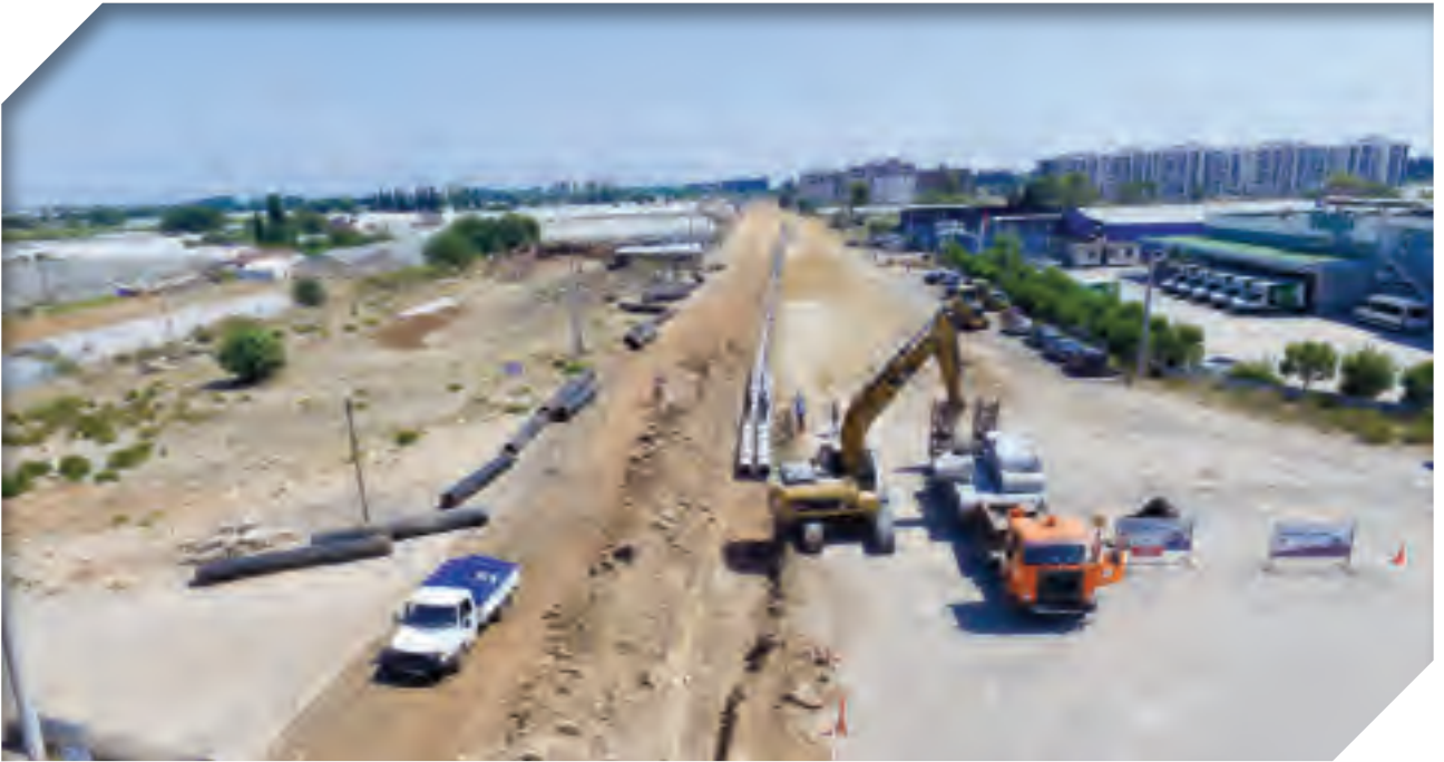
Suphi Türel Caddesi Yağmur Suyu Drenaj Çalışması
