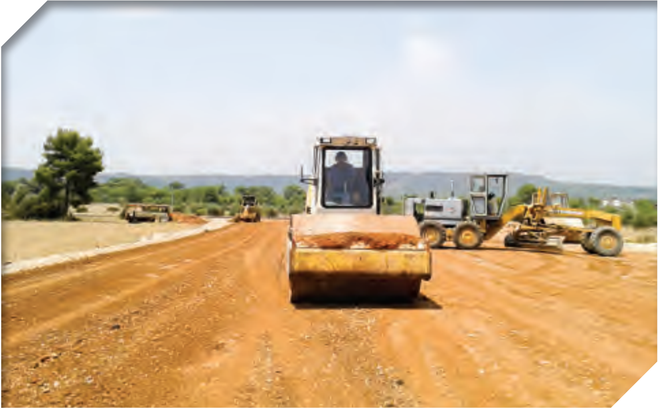
Varsak Karşıyaka Mahallesi Stabilize Yol Yapımı
