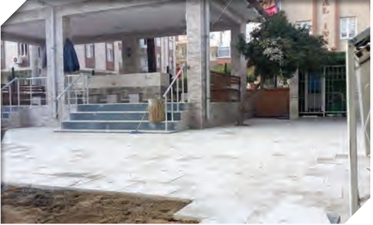
Emek Mahallesi Emek Caminde Mermer Çalışması Yapıldı.
