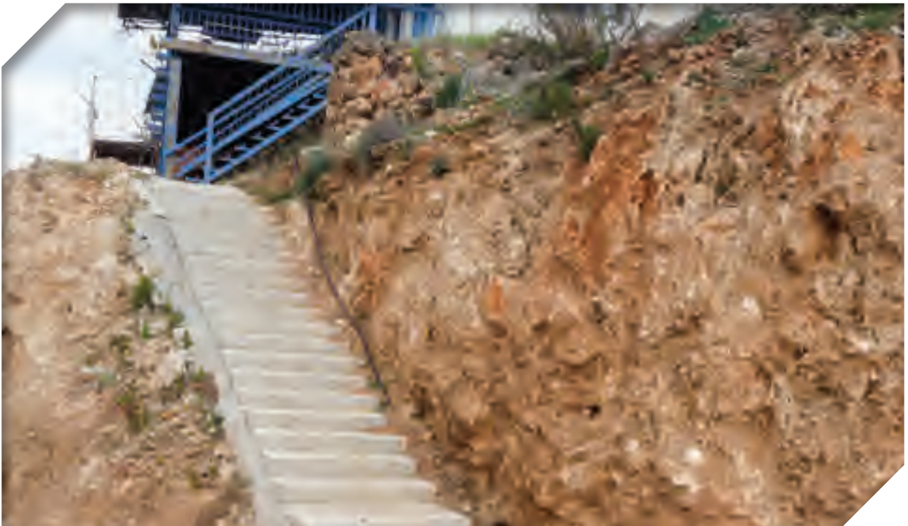
Kazım Karabekir Mahallesi Merdiven Yol Çalışması
