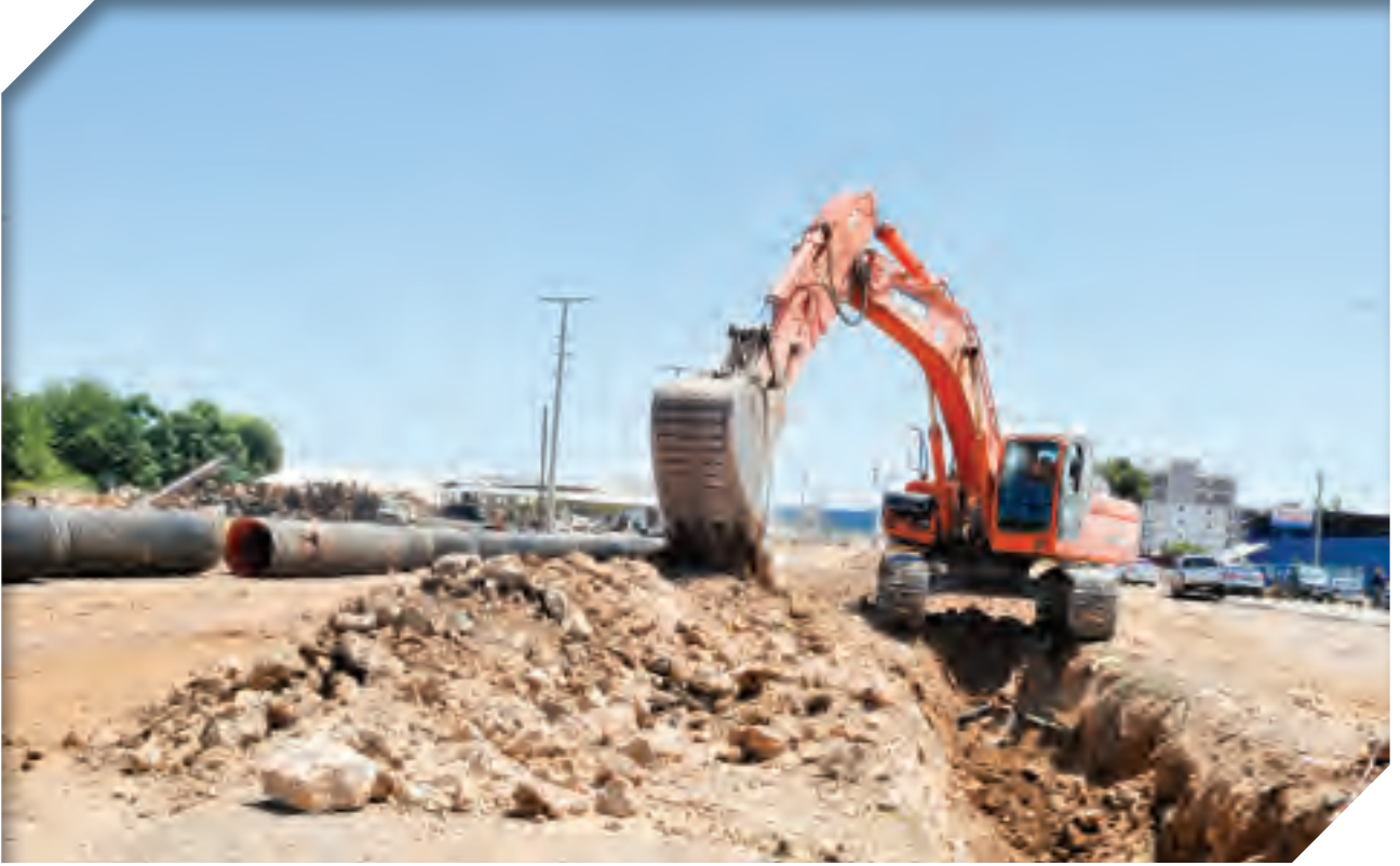
Suphi Türel Caddesi Yağmur Suyu Drenaj Çalışması
