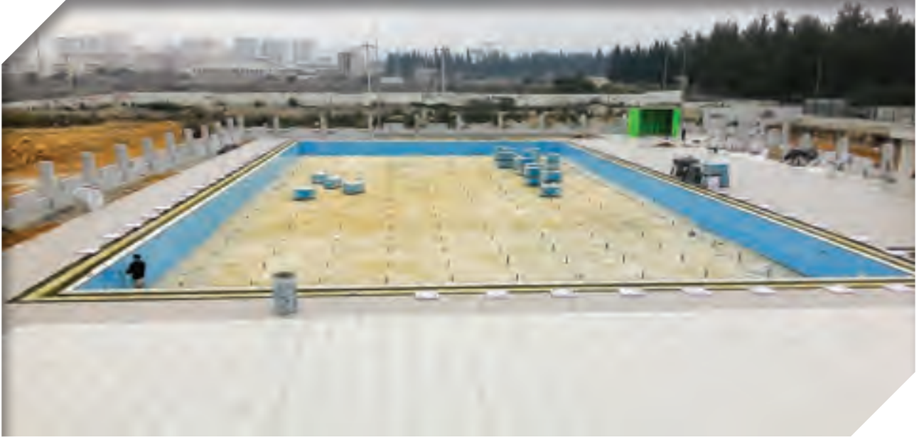
Açık Yüzme Havuzumuzun İnşaatı Hızla Devam Ediyor.
