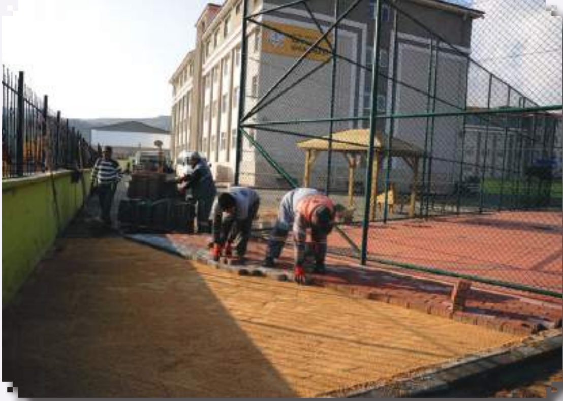
Özel Eğitim Meslek Lisesi Bahçesine Kilittaşı Döşeme Çalışması
