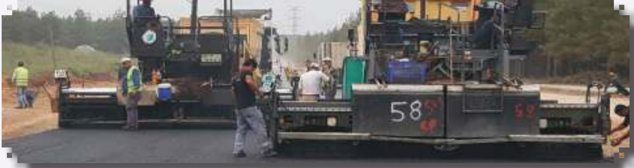
Varsak-Kirişçiler Yolu Sıcak Asfalt Dökülmesi
