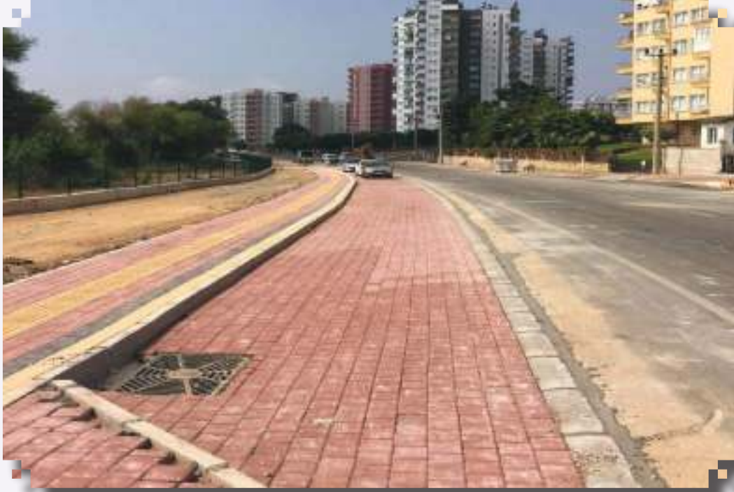
Duraliler Mahallesi Prefabrik Parke Kaldırım Yapılması
