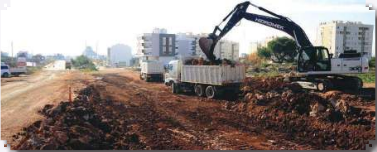
Çankaya Mahallesi Yeni Yol Açımı
