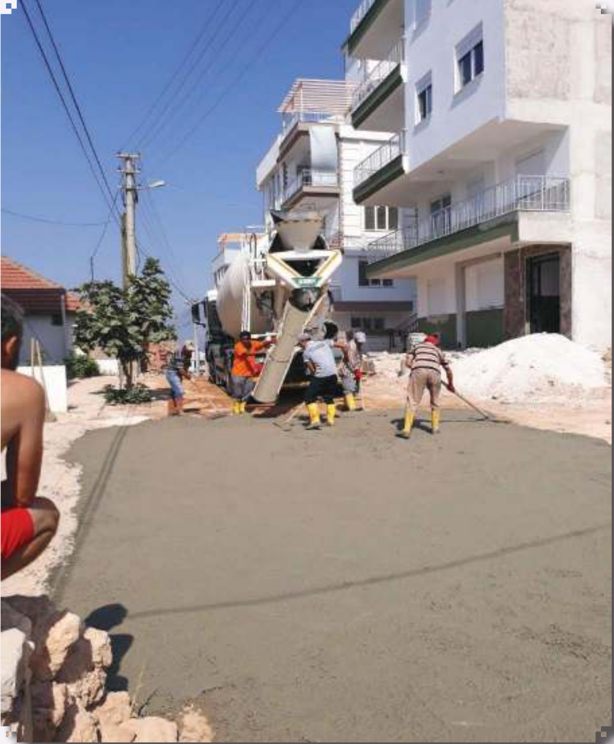
Barış Mahallesi Beton Yol Yapımı
