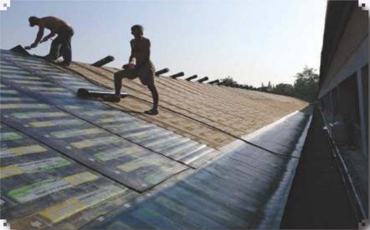
Dokuma Fabrikası Çatı Yenileme ve Tadilat Çalışmaları
