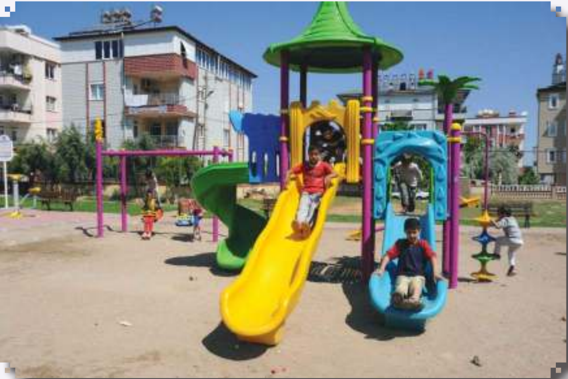
Varsak Karşıyaka Mahallesi 1565 sokak üzeri parkında çocuk oyun grubu montajı yapıldı.
