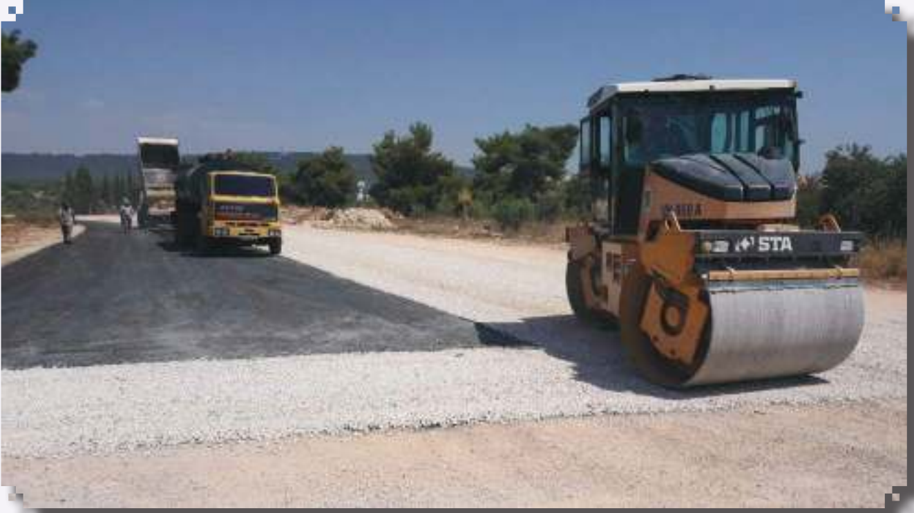
Kızıllı Mahallesi Sathi Kaplama Asfalt Dökülmesi
