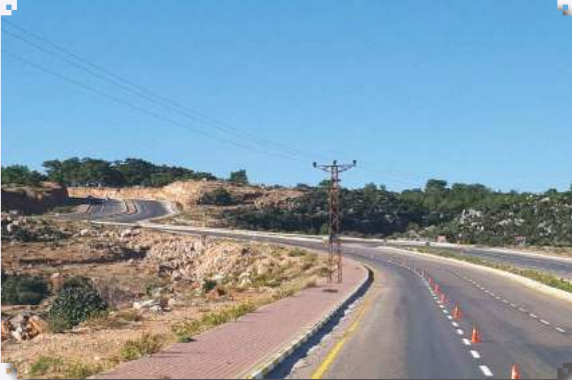
Hamza Taş Bulvarı Yol Çizgisi Yapımı
