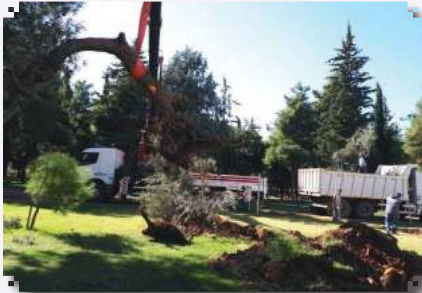
Dokuma Park'ta Zeytin Bahçesi Yapıldı.
