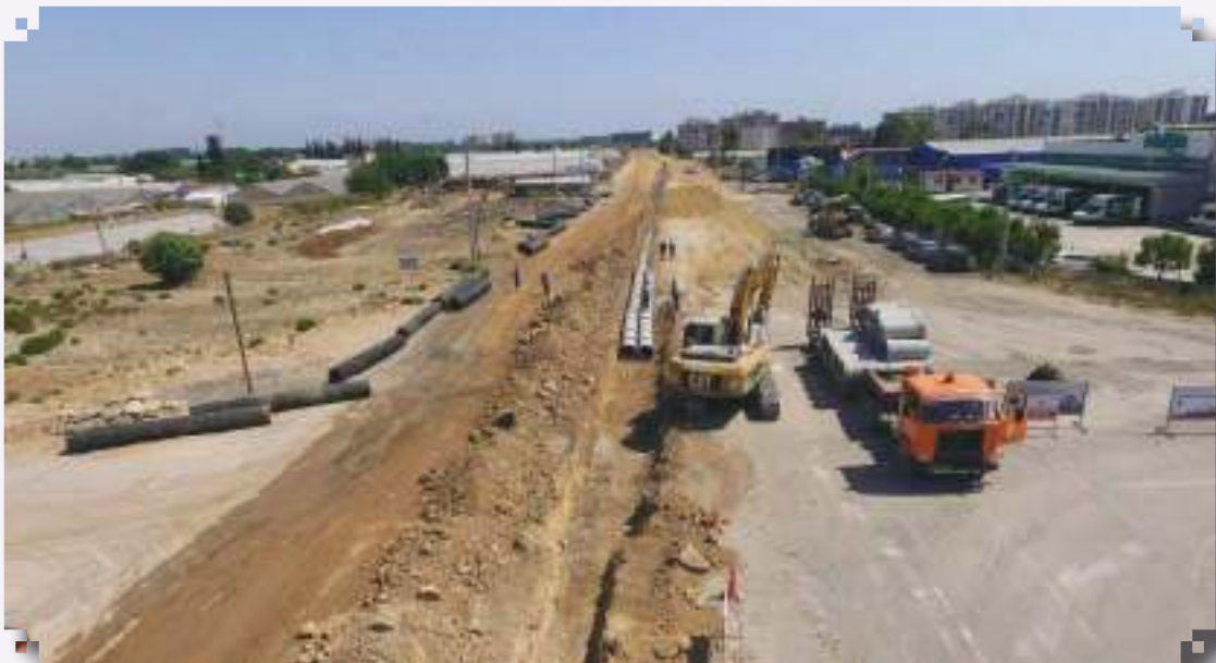
Fevzi Çakmak Mahallesi Menfez Çalışması
