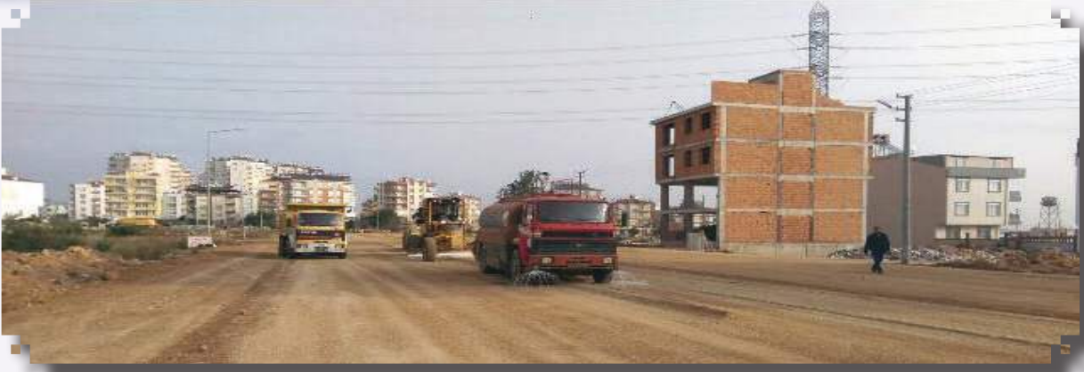
Altınova Orta Mahallesi Yeni Yol Açımı
