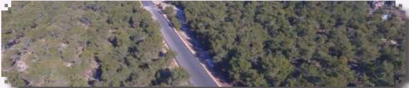
Kındıra Yolu Sıcak Asfalt Dökülmesi
