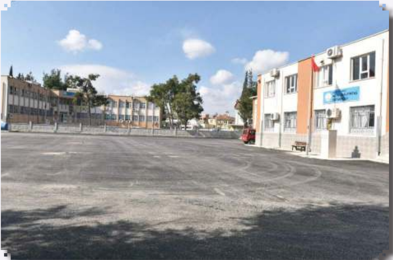
Alırıza Altıntaş Orta Okulu Bahçesine Sıcak Asfalt Dökülmesi
