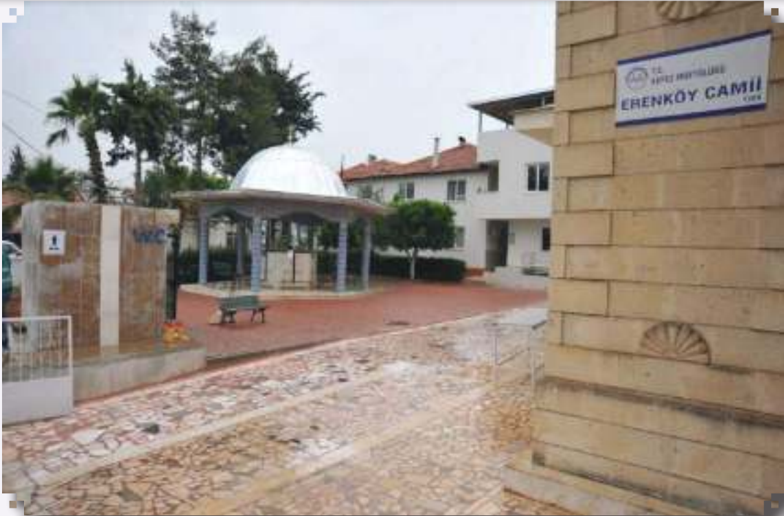
Erenköy Mahallesi Erenköy Camii Kilit taşı döşeme çalışması yapıldı.
