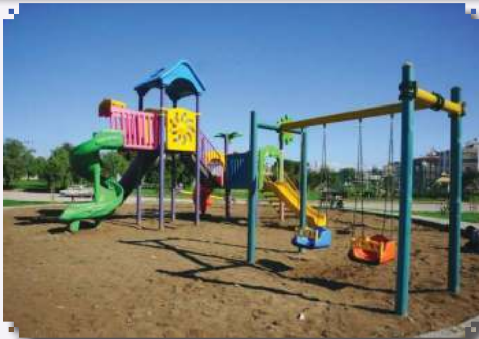
Altınova Orta Mahallesi Çocuk Oyun Grubu montaj çalışması yapıldı.
