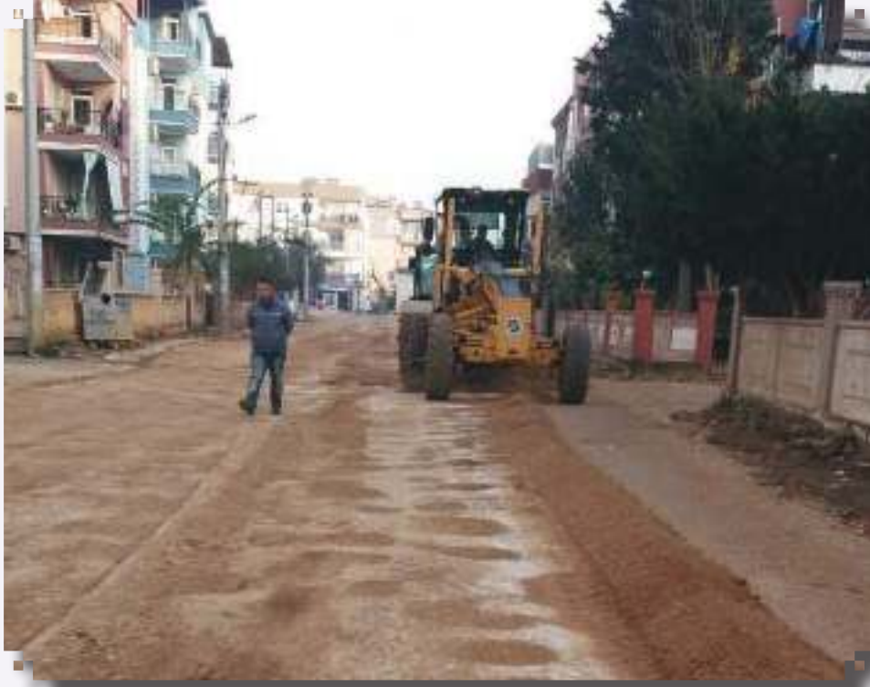
Mehmet Akif Ersoy Mahallesi Stabilize Yol Yapımı
