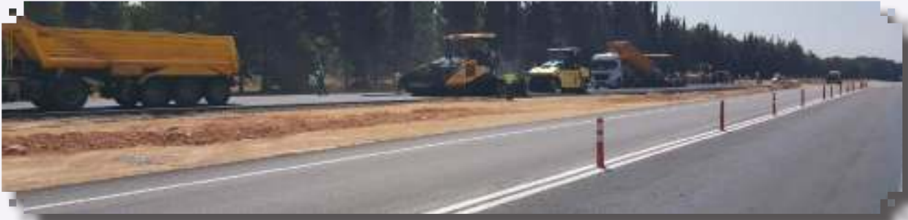
Varsak-Kirişçiler Yolu Sıcak Asfalt Dökülmesi
