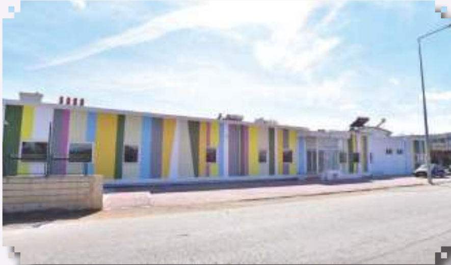
Ahatlı Kreşi Tadilatı Tamamlanmıştır.
