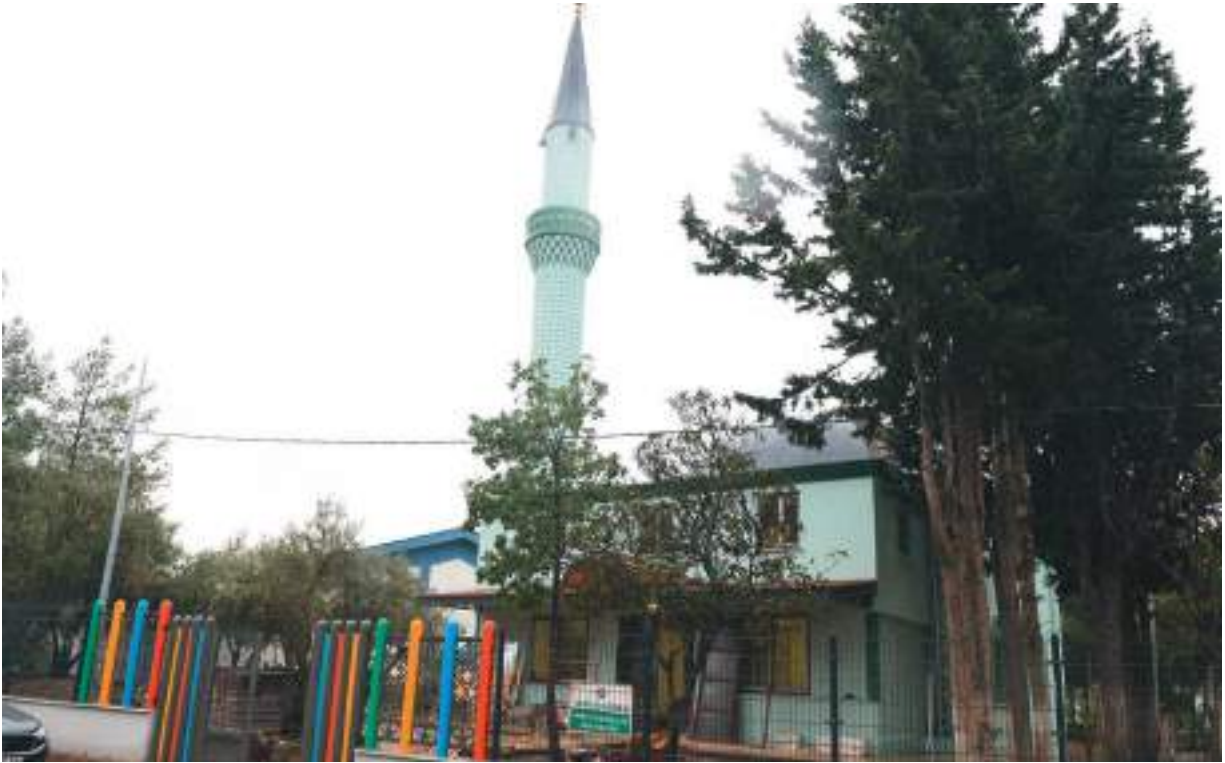
Dokuma Camii Ön Görünümü
