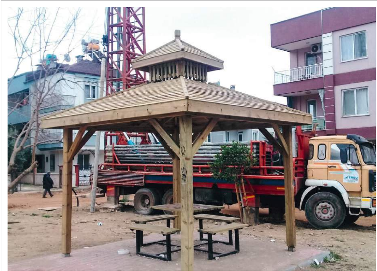
Teomanpaşa Mahallesi 2295 Sokak Parkı Sondaj Çalışması
