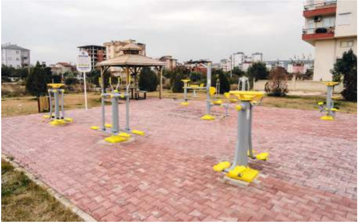
Varsak Karşiyaka Mahallesi 1452 Sokak Fitness Spor Aleti Montajı
