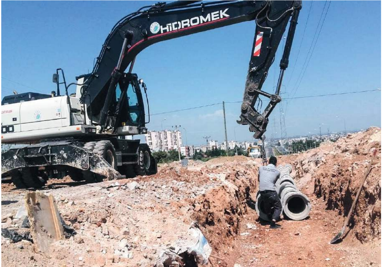
Altınova Düden Mahallesi Menfez Döşemesi
