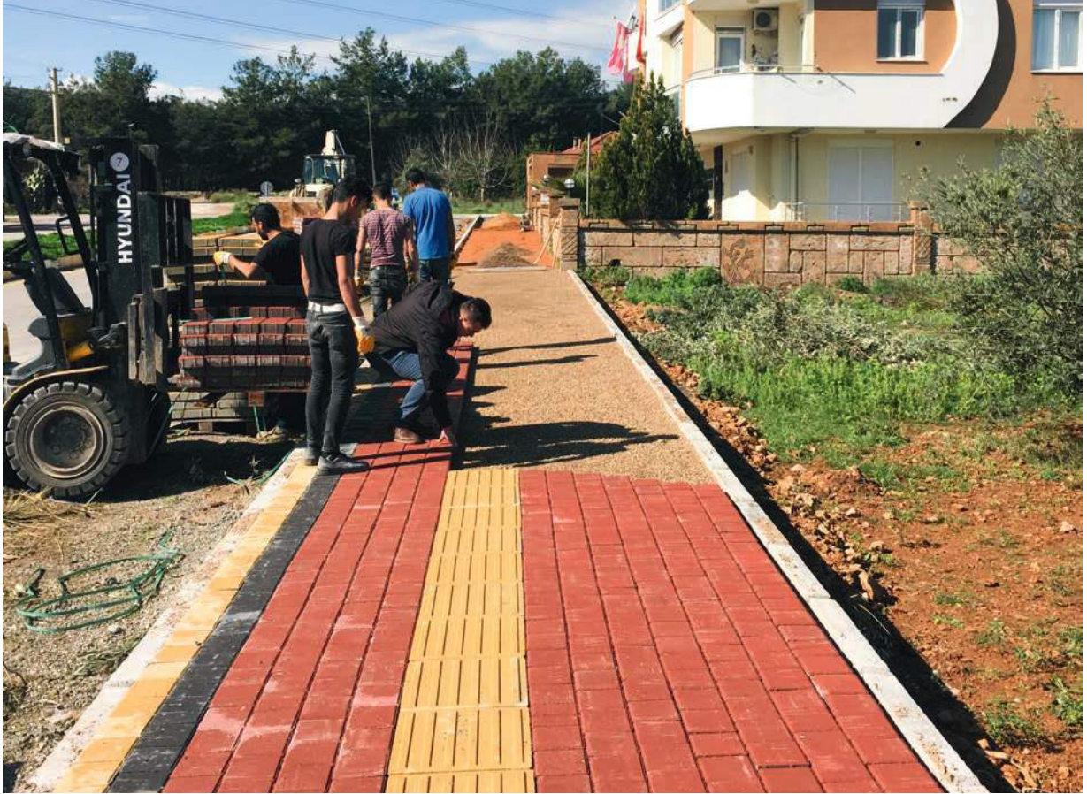
Varsak Karşıyaka Mahallesi Kaldırım Yapılıması
