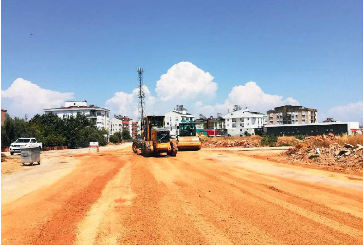
Habibler Mahallesi Stabilize Yol Yapımı
