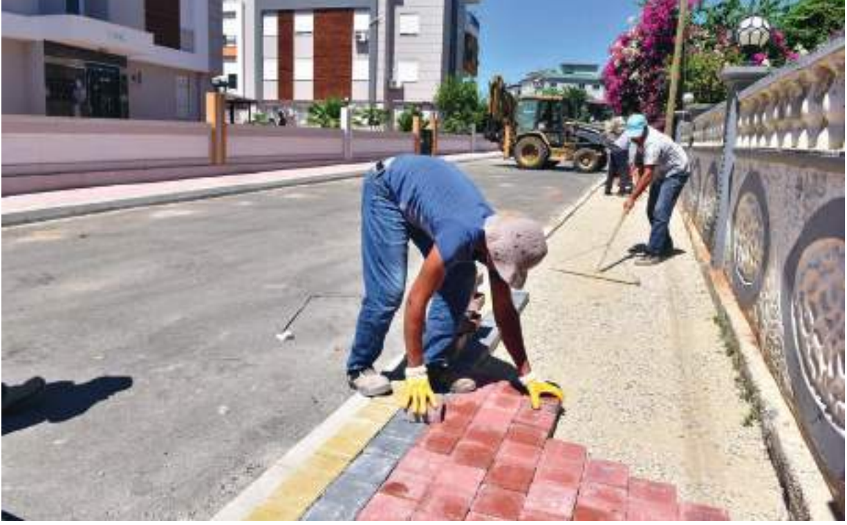
Mehmet Akif Ersoy Mahallesi Kaldırım Yapımı
