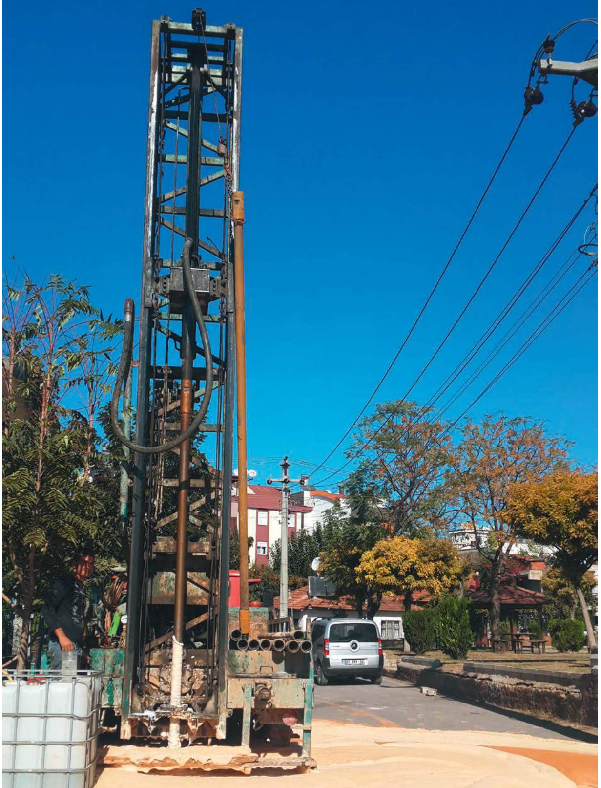
Düdenbaşı Mahallesi Sondaj Çalışması
