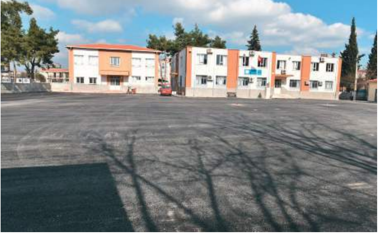
Ali Rıza Altıntaş Ortaokulu Bahçesine Asfalt Dökülmesi Yapıldı
