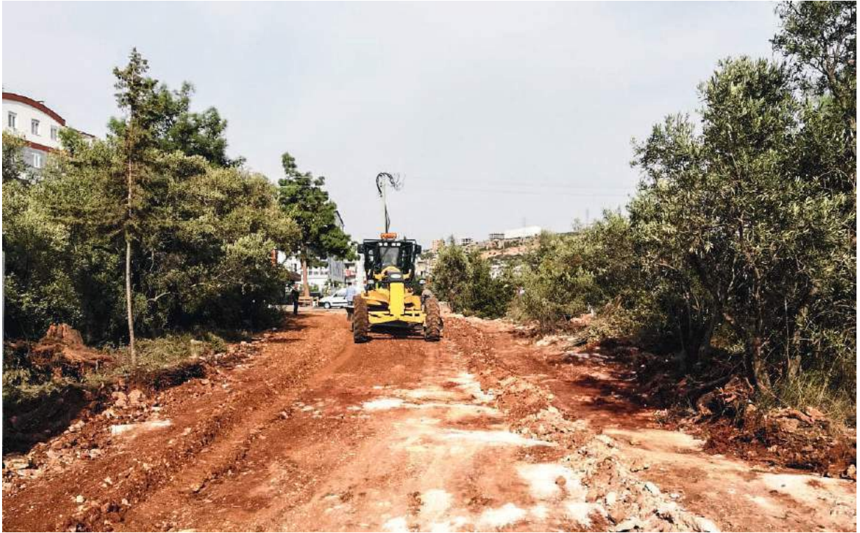
Göçerler Mahallesi Yeni Yol Yapımı
