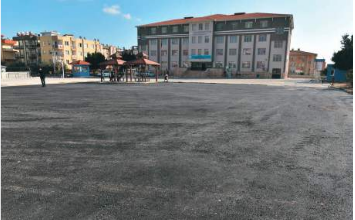
Gülgün Nihat Ortaokulu Bahçesine Asfalt Dökümü Yapıldı
