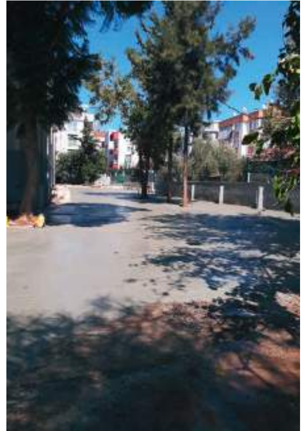
Erenköy Mahallesi Beton Yol Yapımı
