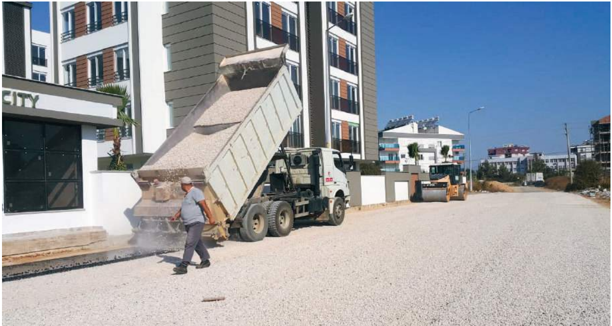
Varsak Demirel Mahallesi Sathi Asfalt Yapımı
