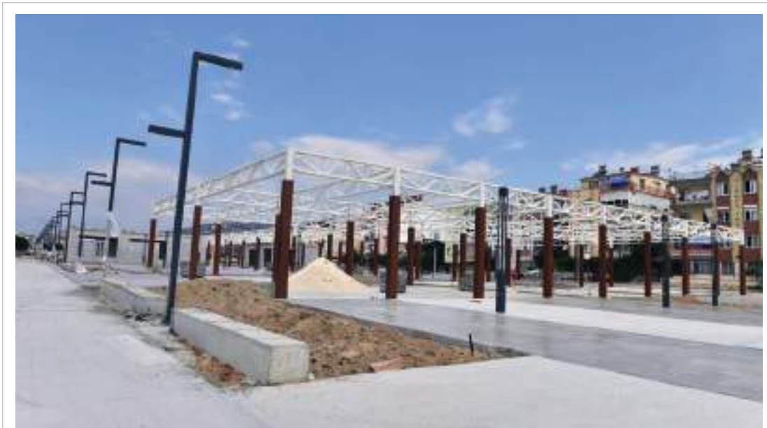
Meydan İnşaatı Devam Ediyor
