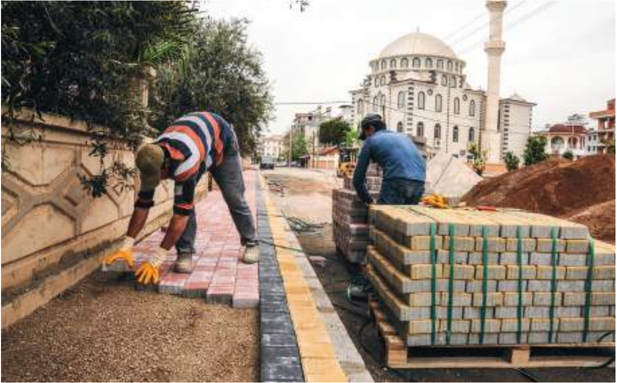
Teomanpaşa Mahallesi Kaldırım Yapımı
