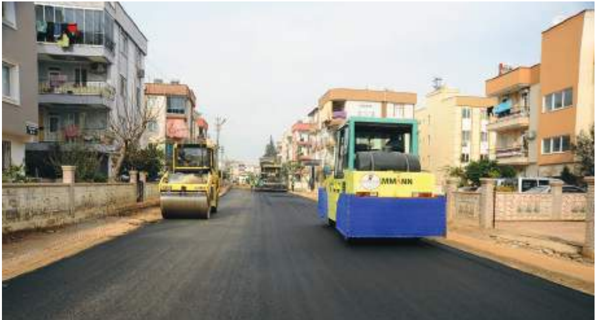
Teomanpaşa Mahallesi Asfalt Dökümü
