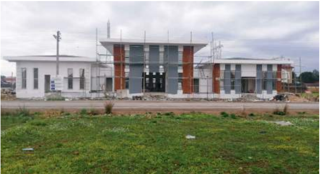
Tesisin İnşaatının Son Durum
