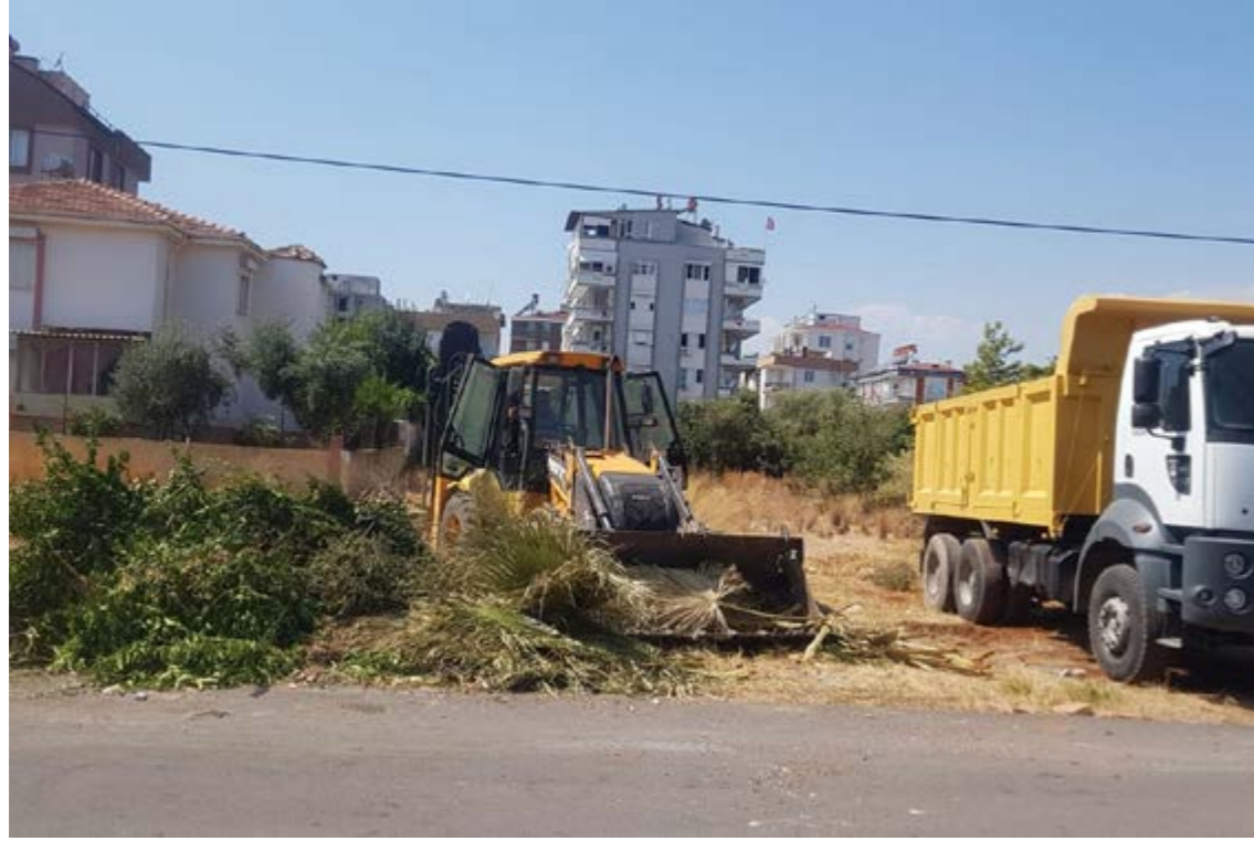
Vatandaşlarımız tarafından boş arsalarla dökülen hafriyat atıkları kepçe ve kamyonumuzla toplanmaktadır.
