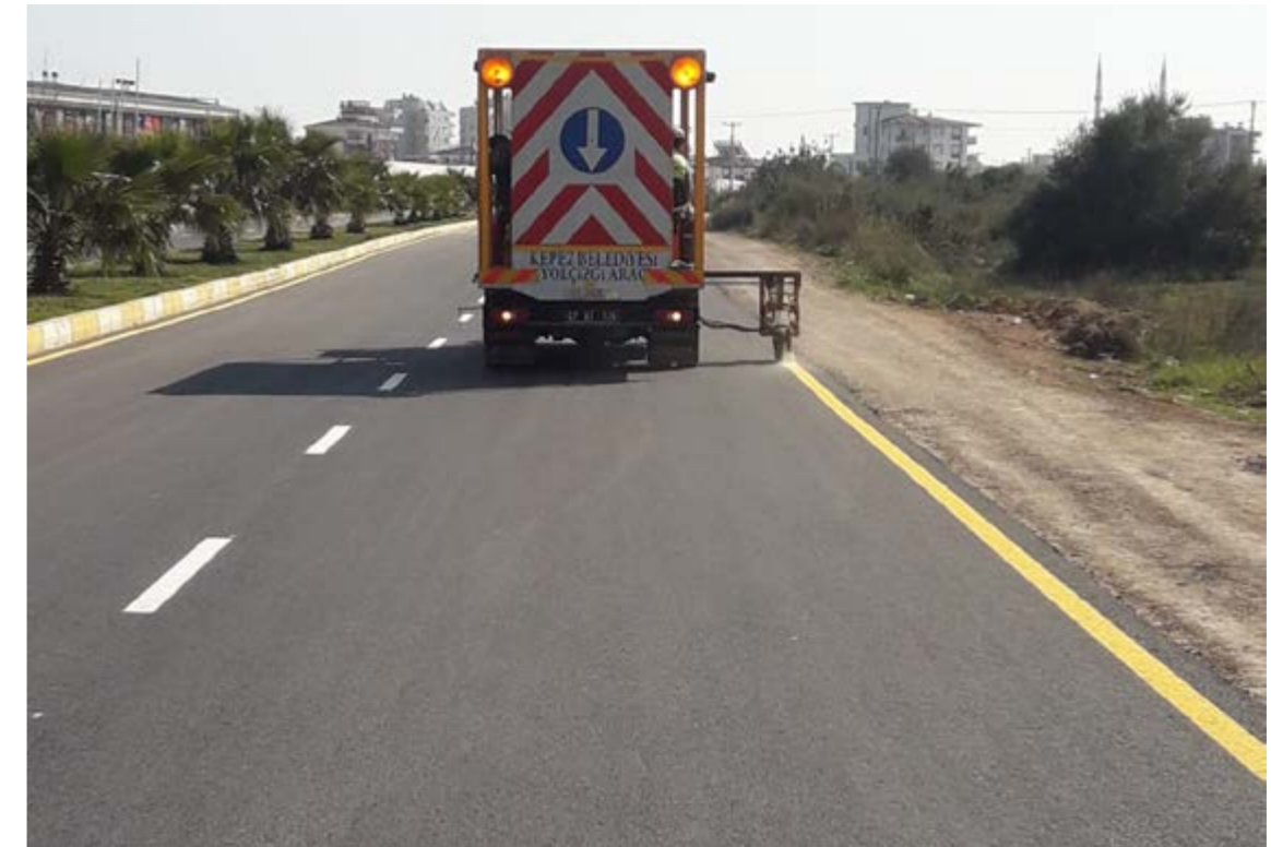
VARSAK KARŞIYAKA MAHALLESİ YOL ÇİZGİSİ ÇALIŞMASI
