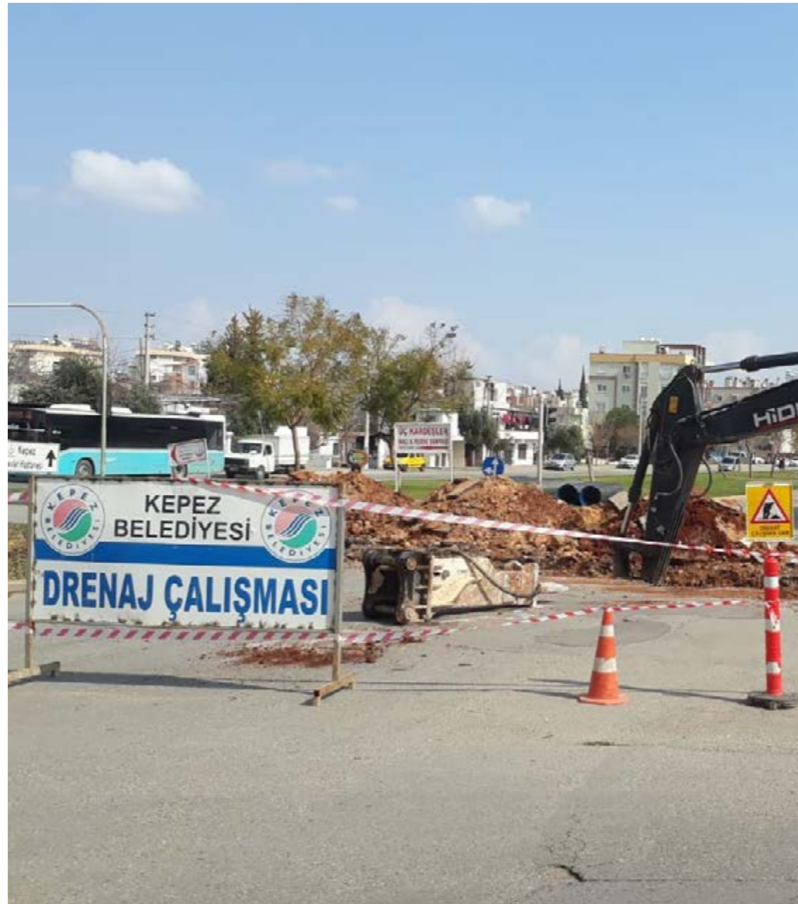
VARSAK KARŞIYAKA MAHALLESİ DRENAJ ÇALIŞMASI
