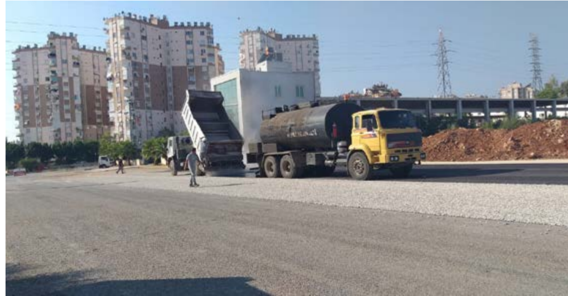
VARSAK AYANOĞLU MAHALLESİ SATHİ KAPLAMA ASFALT DÖKÜMÜ
