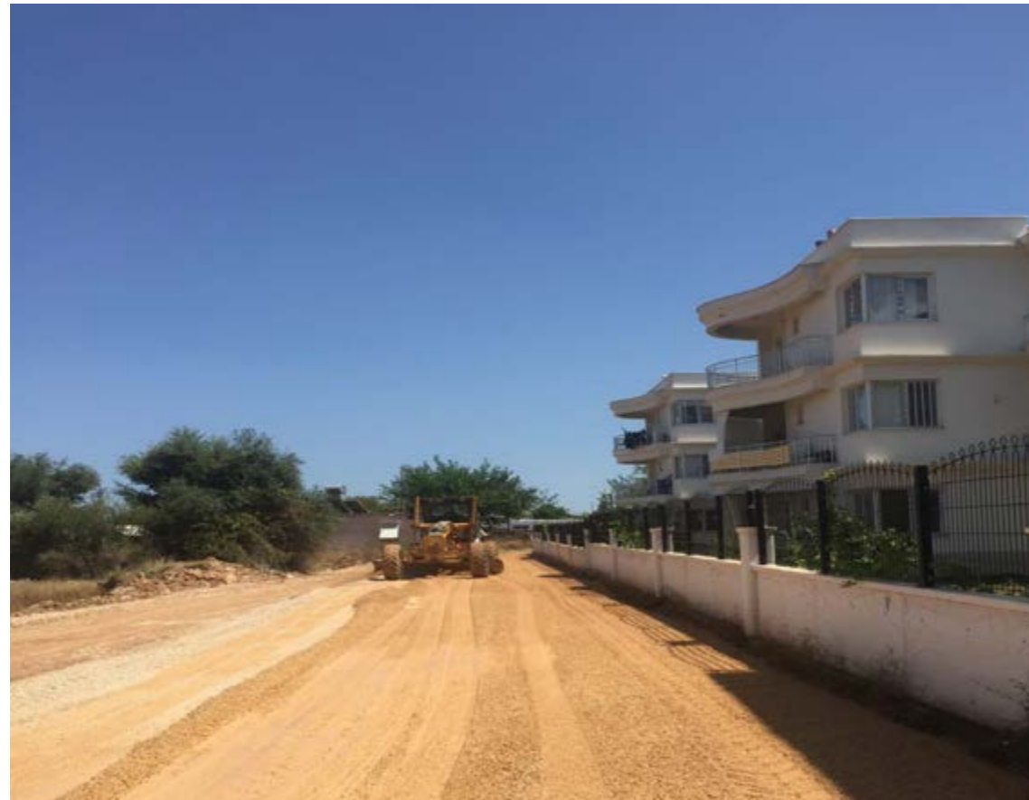
HABİBLER MAHALLESİ STABİLİZE YOL YAPIMI
