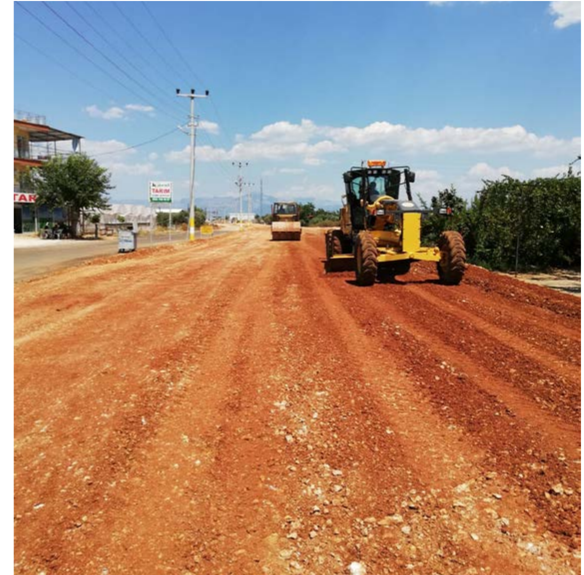
VARSAK ALTIYAK MAHALLESİ STABİLİZE YOL YAPIMI
