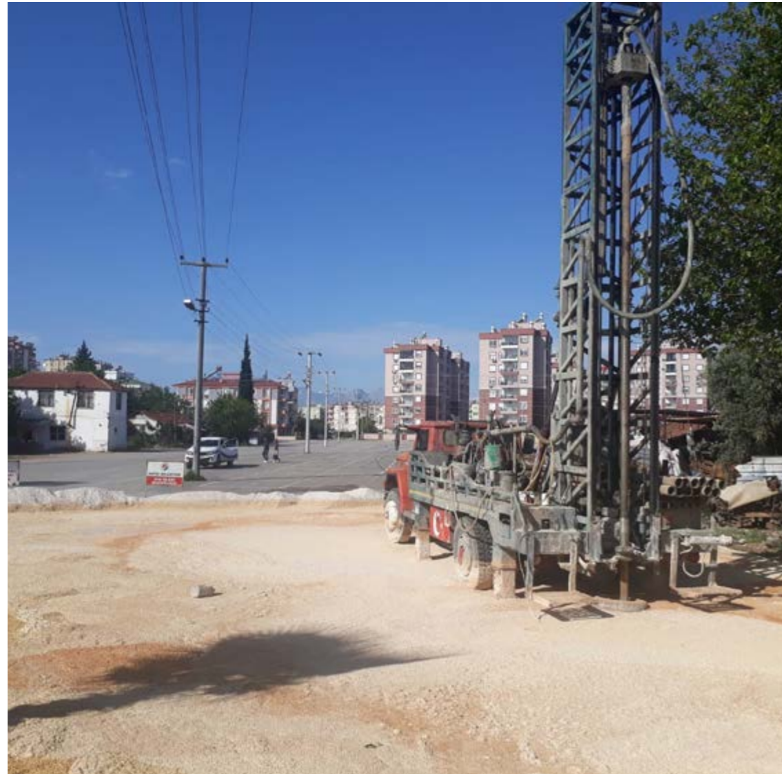
DÜDENBAŞI MAHALLESİ SONDA KUYUSU AÇILMASI
