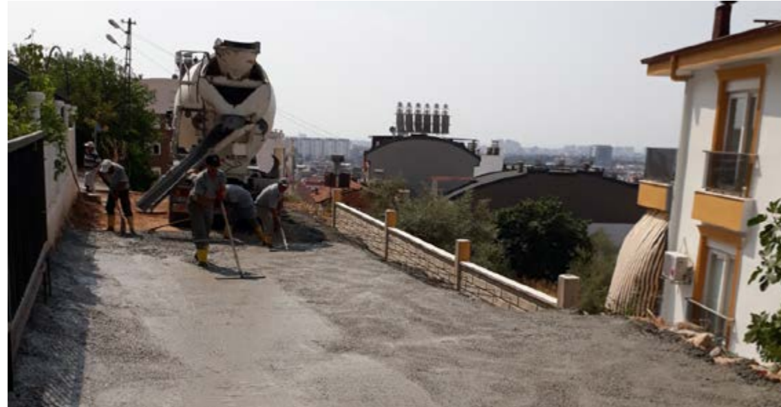
ERENKÖY MAHALLESİ BETON YOL YAPIMI
