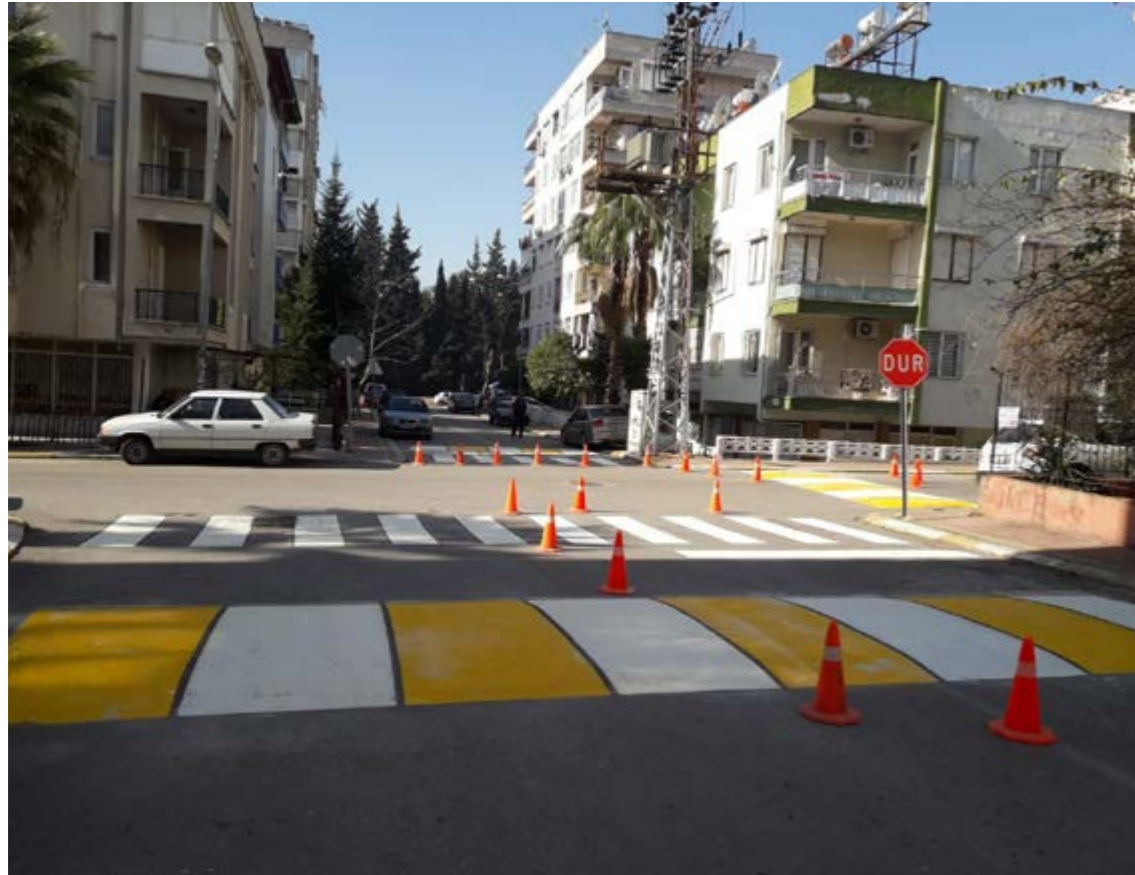
ÖZGÜRLÜK MAHALLESİ YOL ÇİZGİ ÇALIŞMASI
