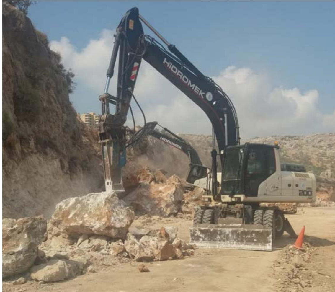
FEVZİ ÇAKMAK MAHALLESİ YENİ YOL AÇIMI
