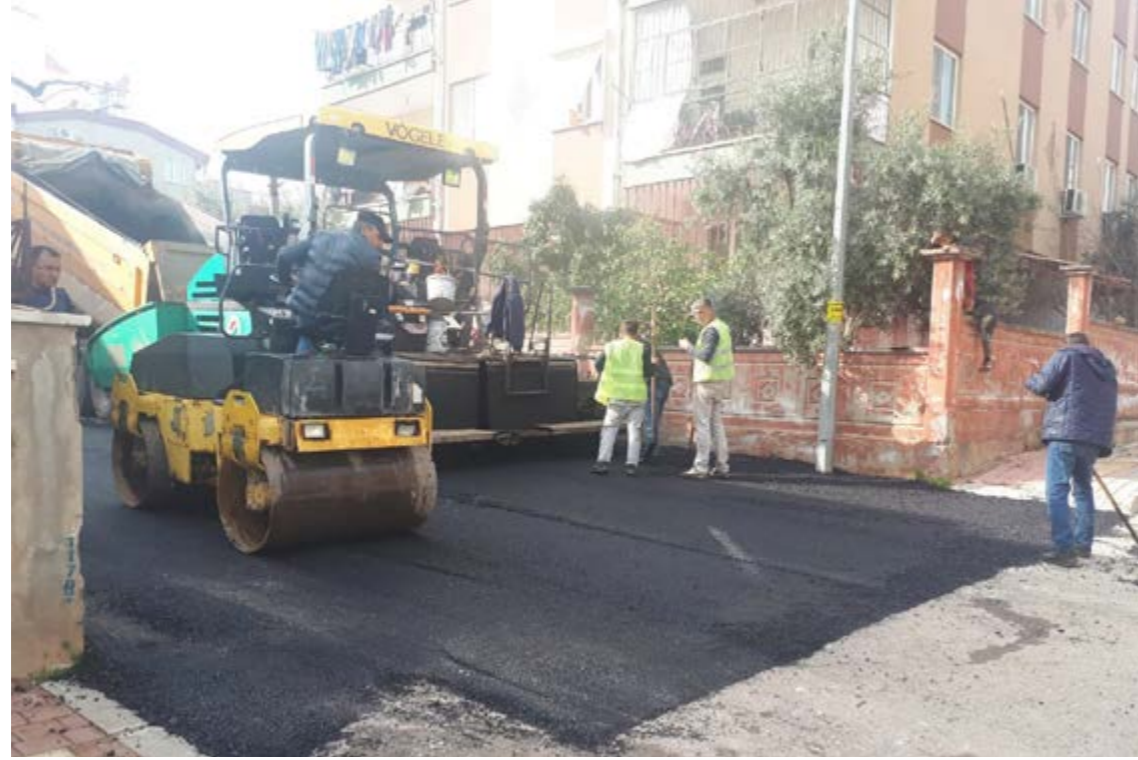
SÜTÇÜLER MAHALLESİ SICAK ASFALT DÖKÜMÜ
