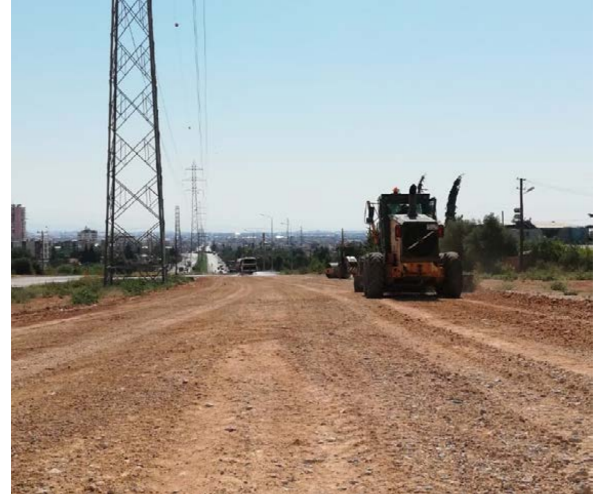
FEVZİ ÇAKMAK MAHALLESİ YENİ YOL AÇIMI
