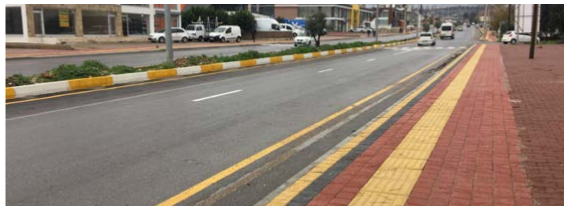
SÜTÇÜLER MAHALLESİ PREFABRİK PARKE KALDIRIM YAPIMI
