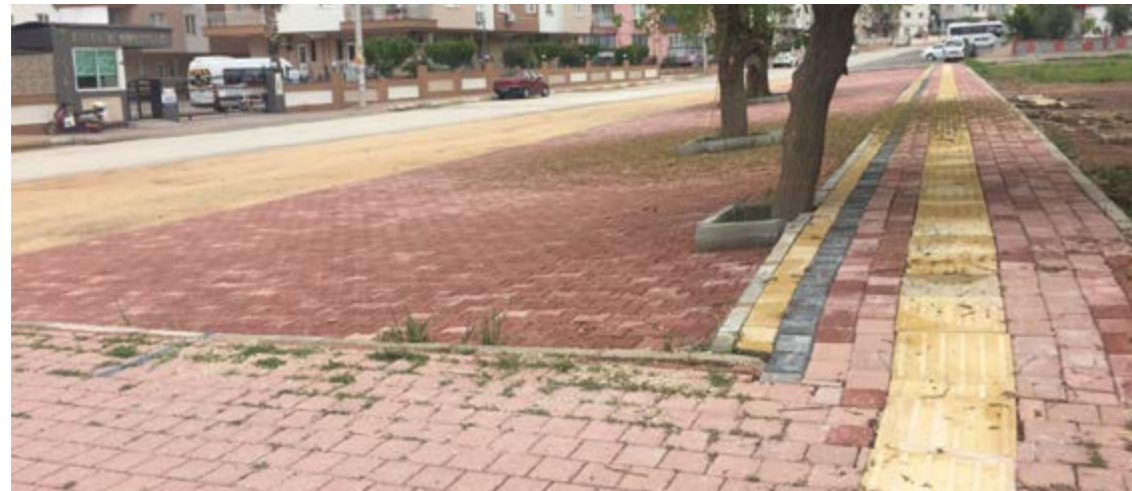
ÜNSAL MAHALLESİ PREFABRİK PARKE KALDIRIM YAPIMI
