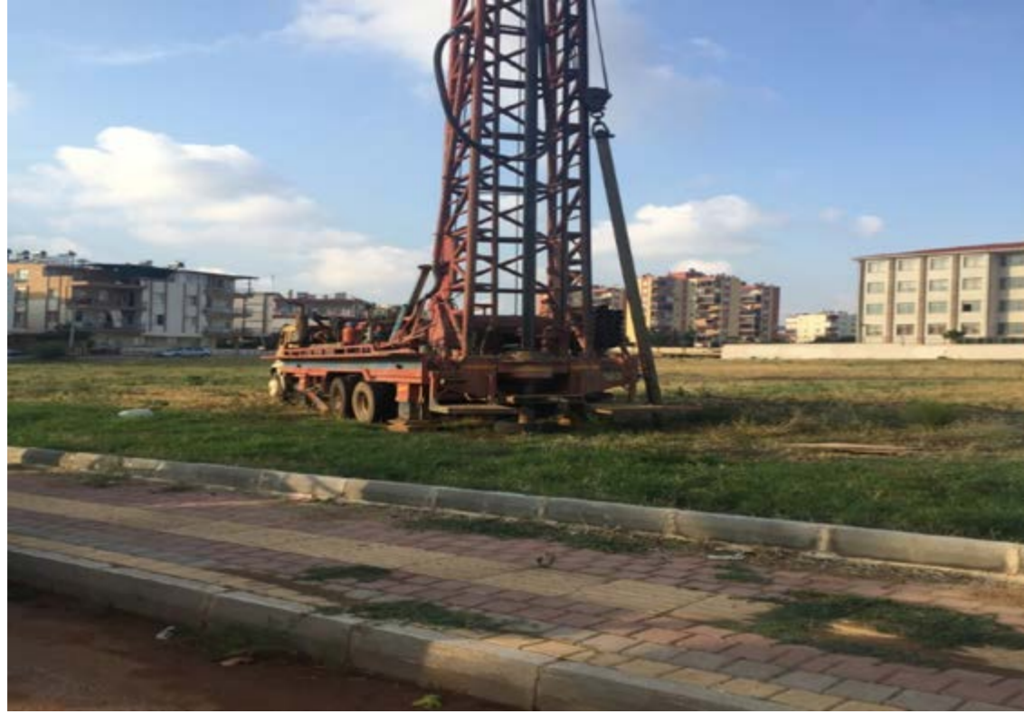
ÇAMLIBEL MAHALLESİ 4904 SOKAK ÜZERİ PARKI SONDAJ ÇALIŞMASI
