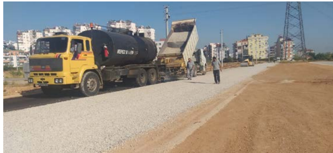
VARSAK KARŞIYAKA MAHALLESİ SATHİ KAPLAMA ASFALT DÖKÜMÜ
