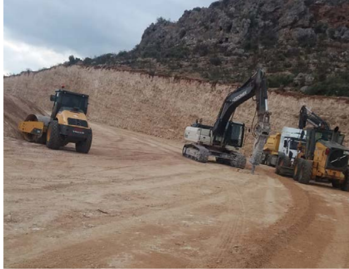
FEVZİ ÇAKMAK MAHALLESİ STABİLİZE YOL YAPIMI
