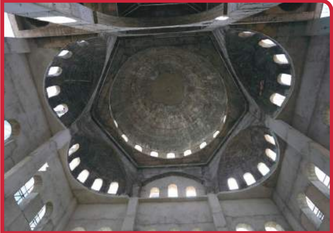
Konyalılar Cami Projesi Yapım Kontrolleri
