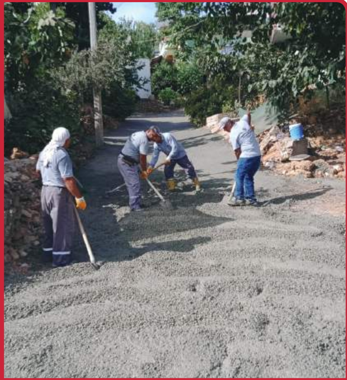
Yavuz Selim Mahallesi Beton Yol Yapımı
