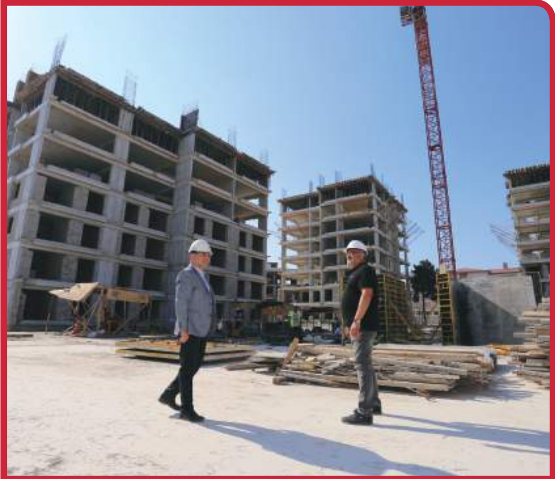
Başkanımız Gülveren Kentsel Dönüşüm Projesinde İncelemelerde Bulundu.
