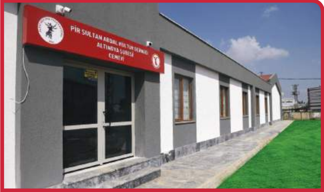
Cemevi Dış Görünüş
