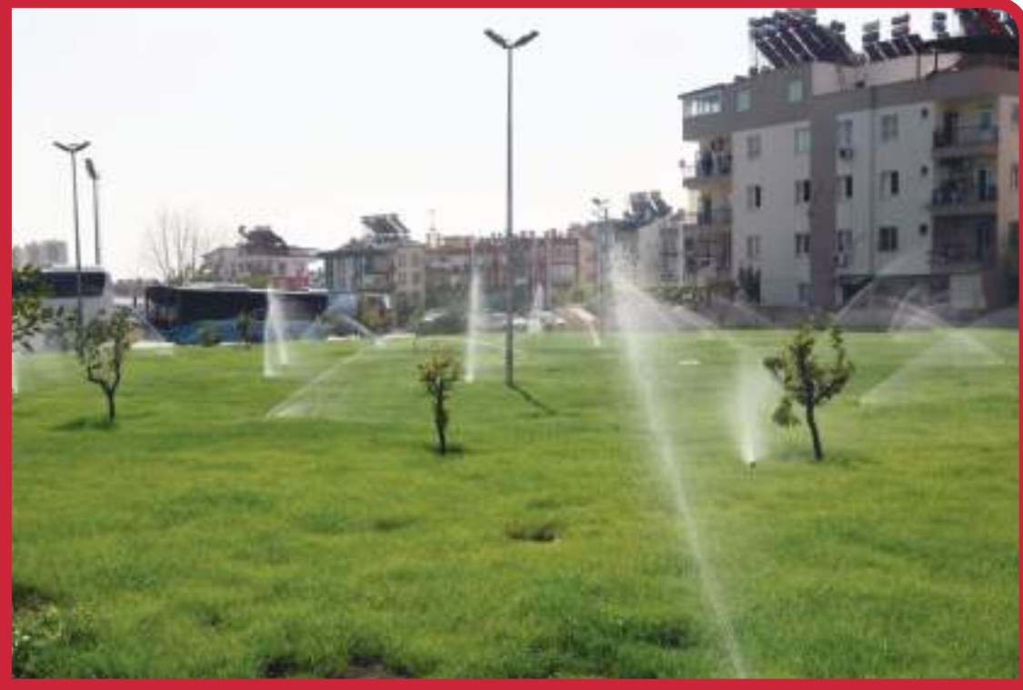
Kuzeyyaka Mahallesi 2535 - 2550 Sokak Kesişimi Yeşil Alan sulama çalışması
