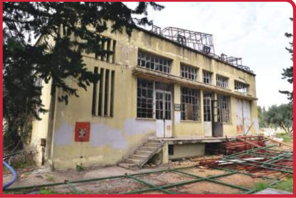
Trafo Binası Eski Görünümü
