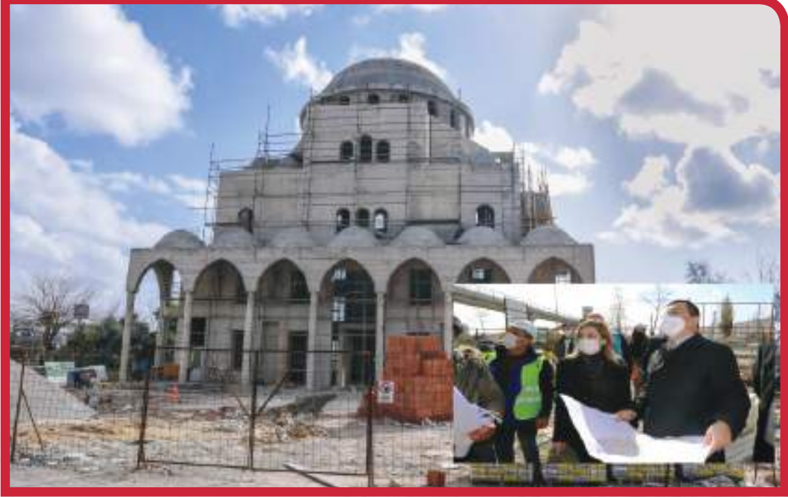
Konyalılar Cami Projesi Yapım Kontrolleri
