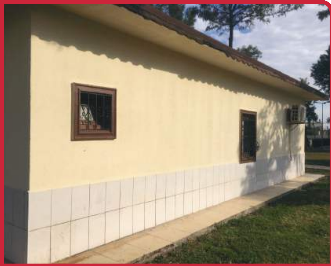
Düdenbaşı Mahallesi Muhtarlık Binası boya çalışması yapıldı
