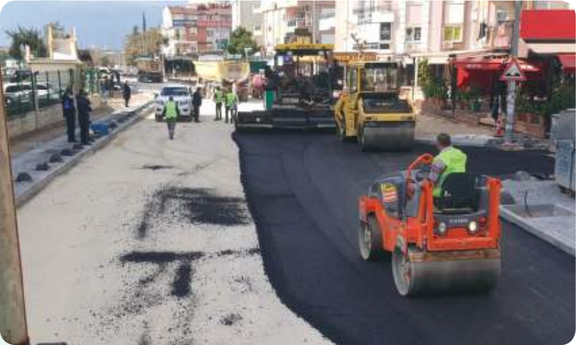
Kültür Mahallesi Sıcak Asfalt Dökümü
