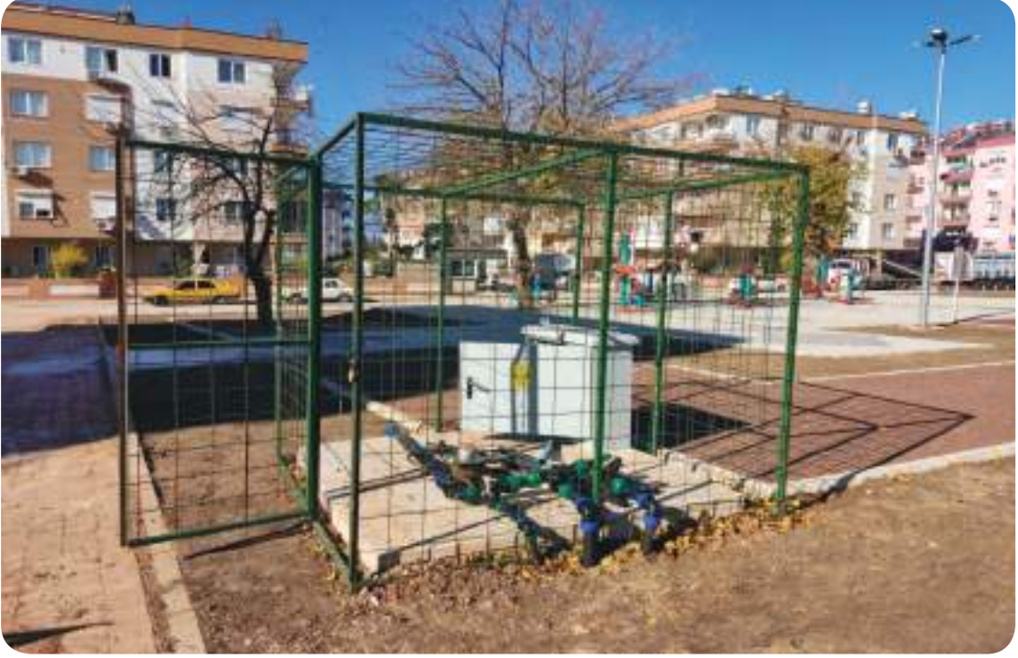
Ünsal Mahallesi 5109-5116 Sokak Kesişim Yeni Park Sondaj Kuyusu Çalışması
