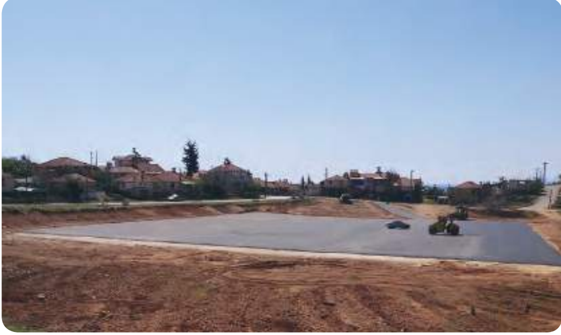
Yavuz Selim Mahallesi Pazar Yeri Yapımı
