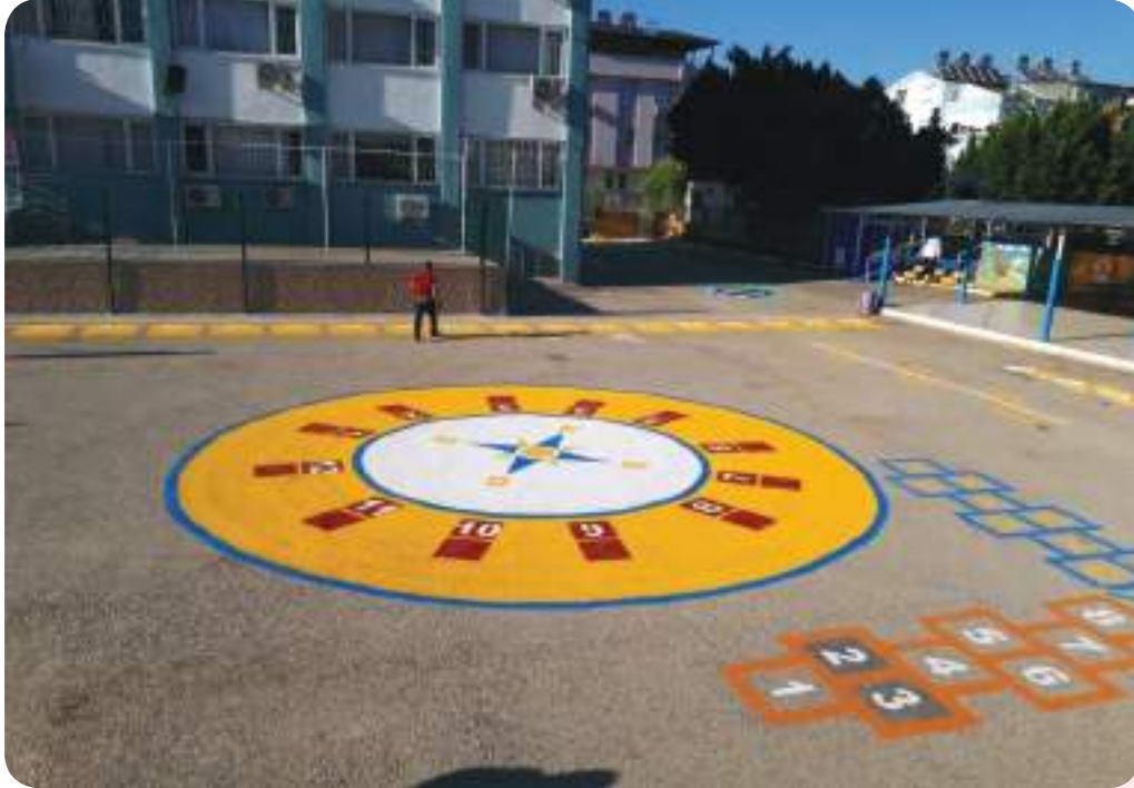
Fabrikalar Mahallesi Ersoy İlkokulu Boya Çalışması
