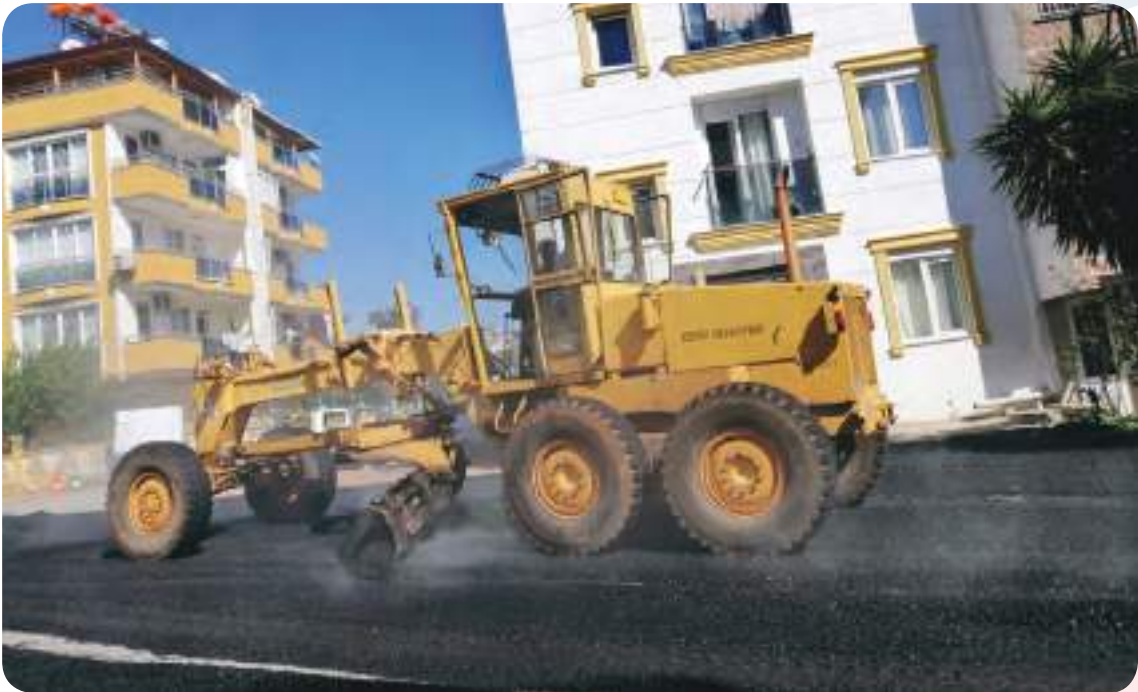
Yeşilyurt Mahallesi Asfalt Serme Çalışması
