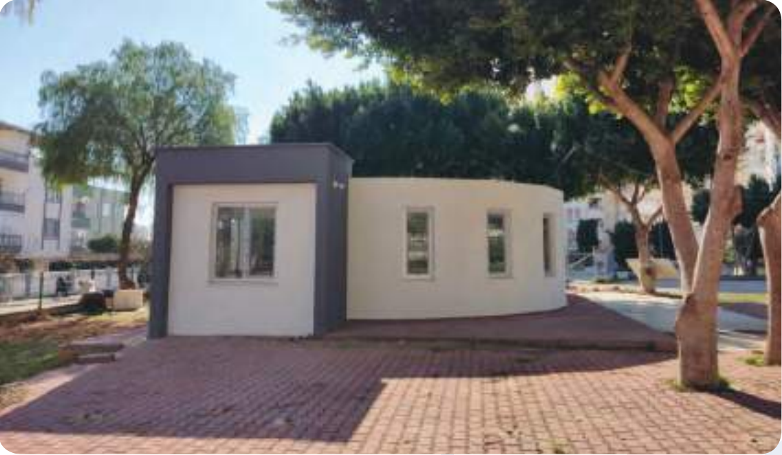
Atatürk Mahallesi Aile Sağlığı Merkezi Görünümü
