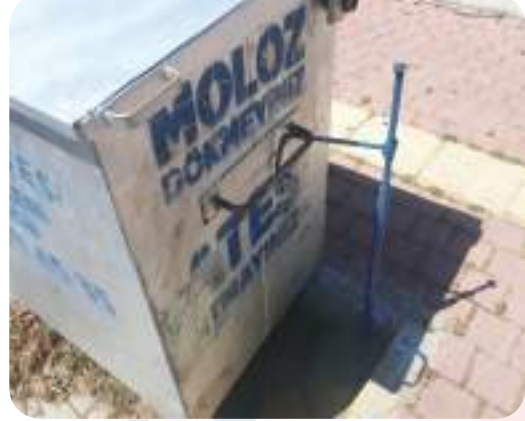
Konteynerlerin yer sabitlenmesinin yapılması ve reflektörler montajlarının yapılması
