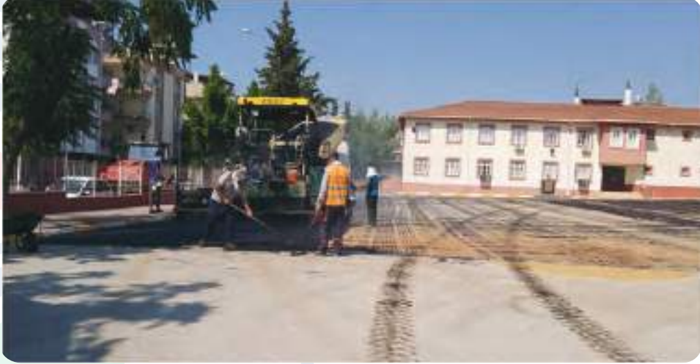
Şafak Mahallesi-Yıldırım Beyazıt İlkokulu Bahçesine Asfalt Dökümü Yapıldı.
