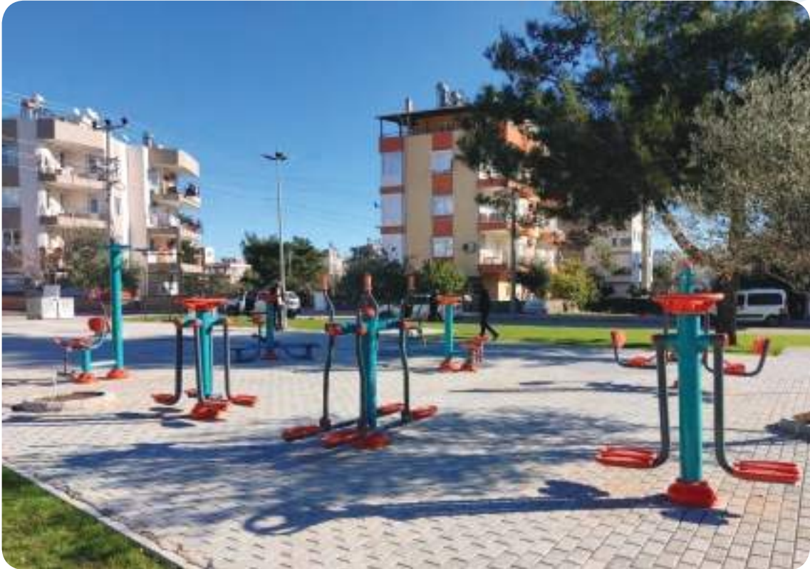
V. Aktoprak Mahallesi 1153 - 1181 Sokak Parkı Fitness Spor Aleti Montajı
