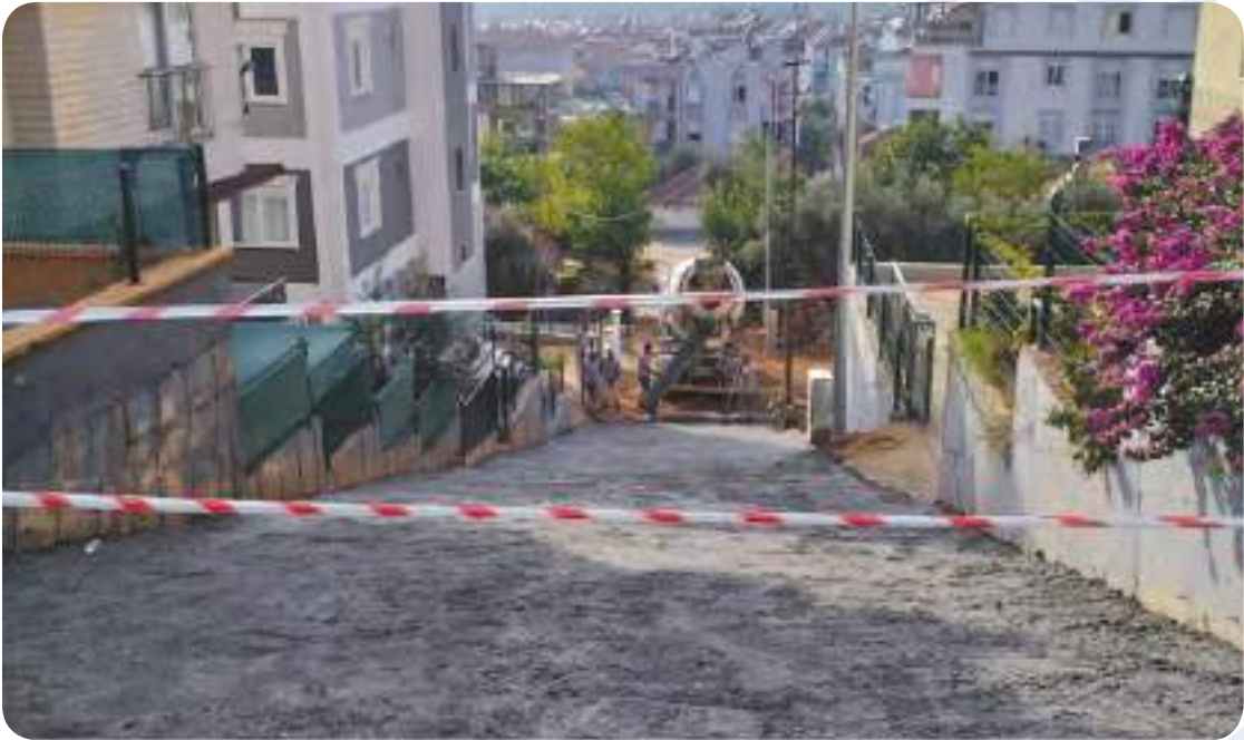
Erenköy Mahallesi Beton Yol Yapımı
