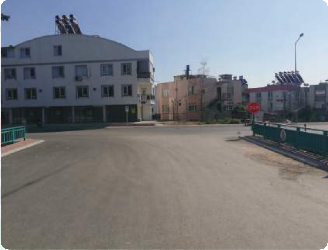
Kütükçü Mahallesi Köprüsü
