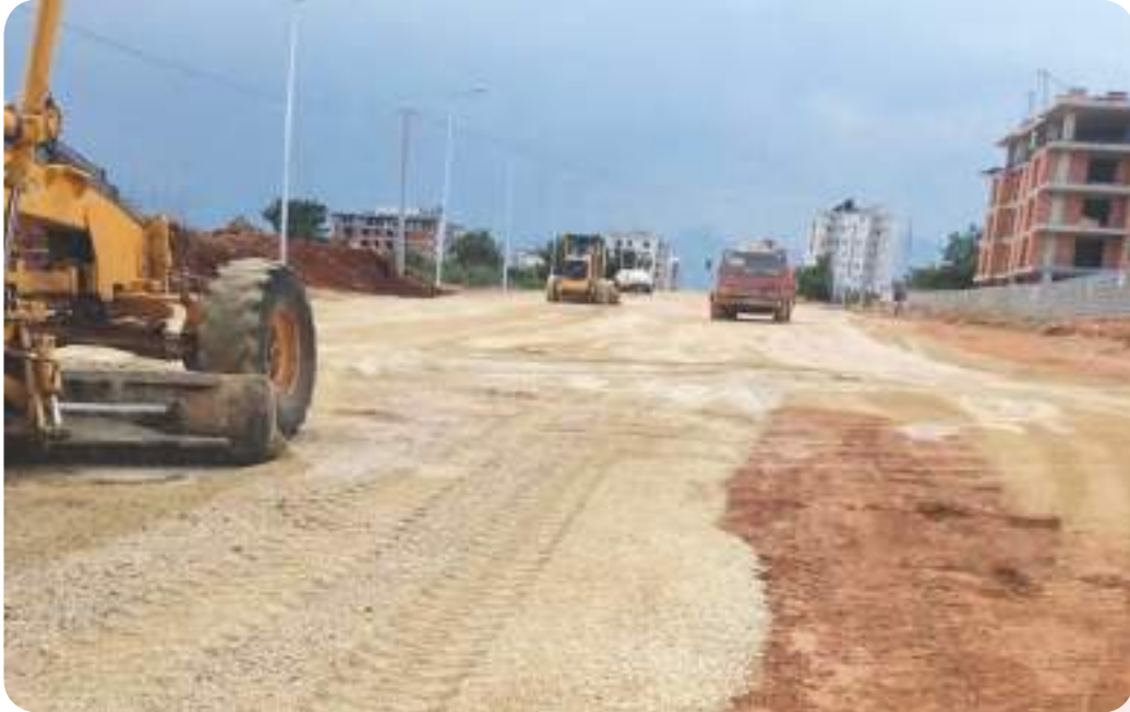
Çankaya Mahallesi Stabilize Yol Yapımı
