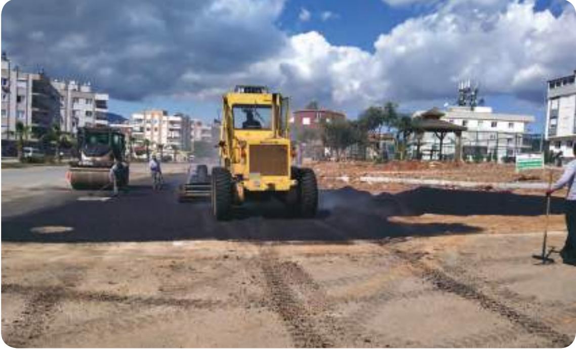
Ünsal Mahallesi Sıcak Asfalt Dökümü
