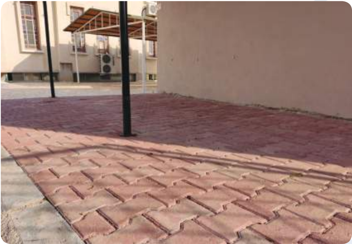
Yeni Emek Mahallesi Eyüp Sultan Cami Parke Taşı Döşeme Çalışması
