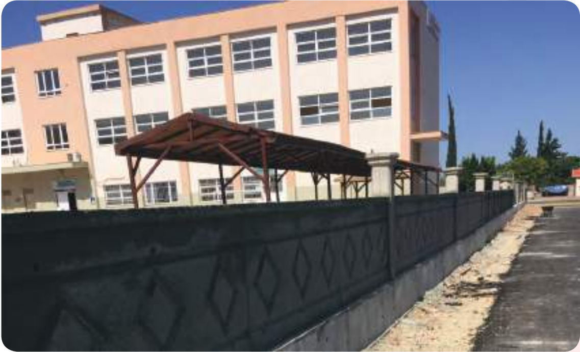
Hüsnü Karakaş Mahallesi Okul Çevre Duvarı Yapımı
