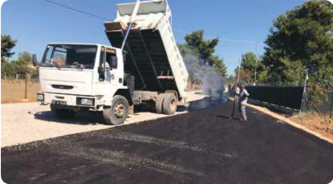
Duacı Mahallesi Sathi Kaplama Asfalt Çalışması
