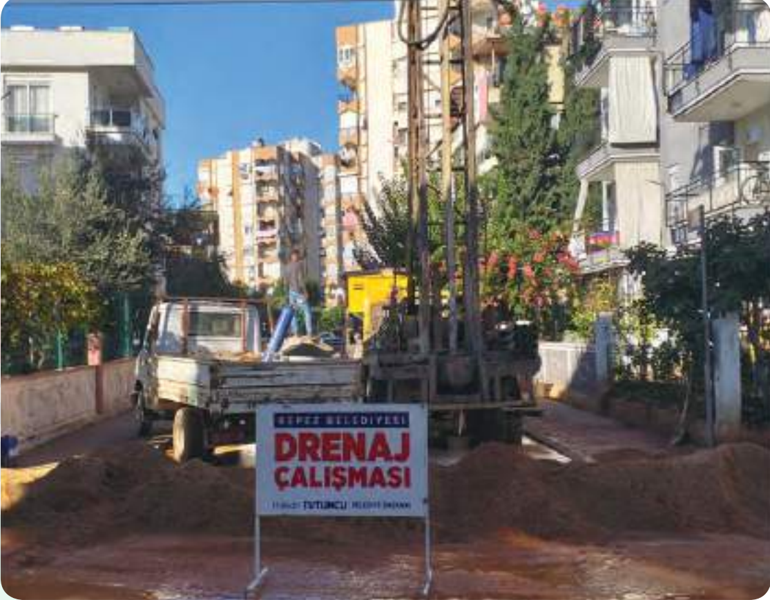
Güneş Mahallesi Sondaj Kuyusu Açılması
