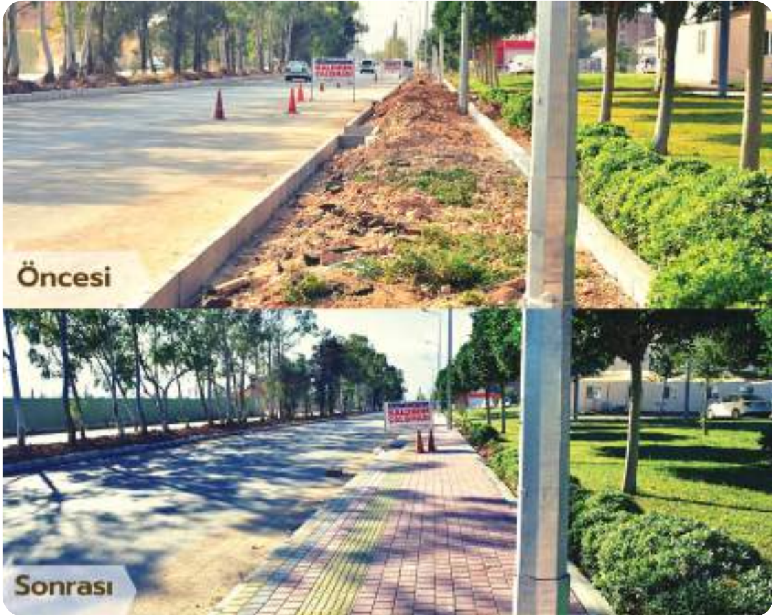
5 Temmuz Caddesi Kaldırım Çalışması
