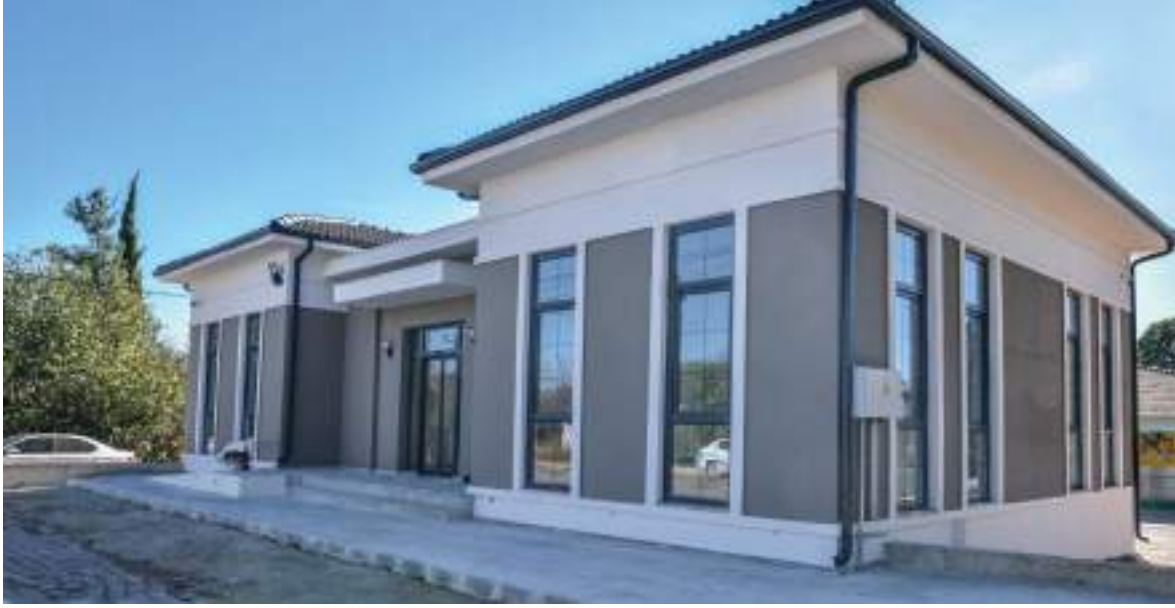
Başköy Hizmet Binası Yapımı Tamamlandı.
