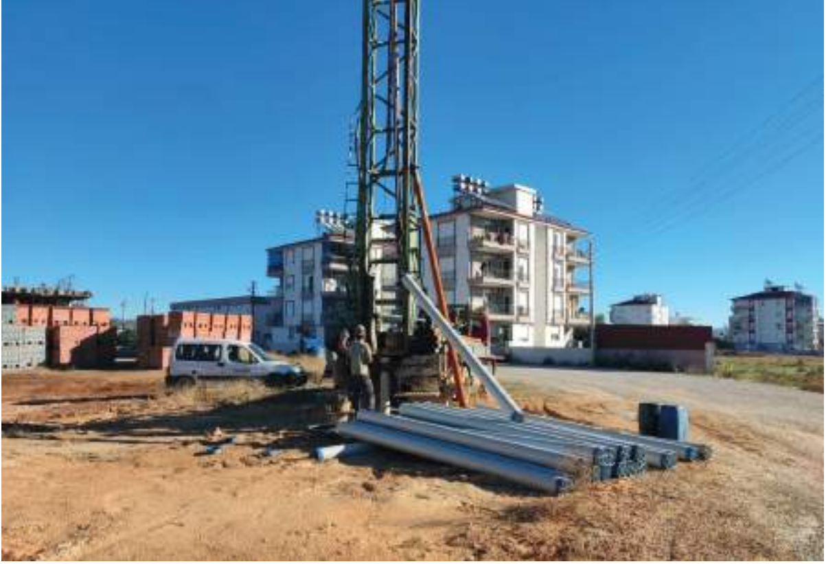
Ayanođlu Mahallesi 1907-1908 Sokak Kesiřimi Sondaj Kuyusu Ađılması
