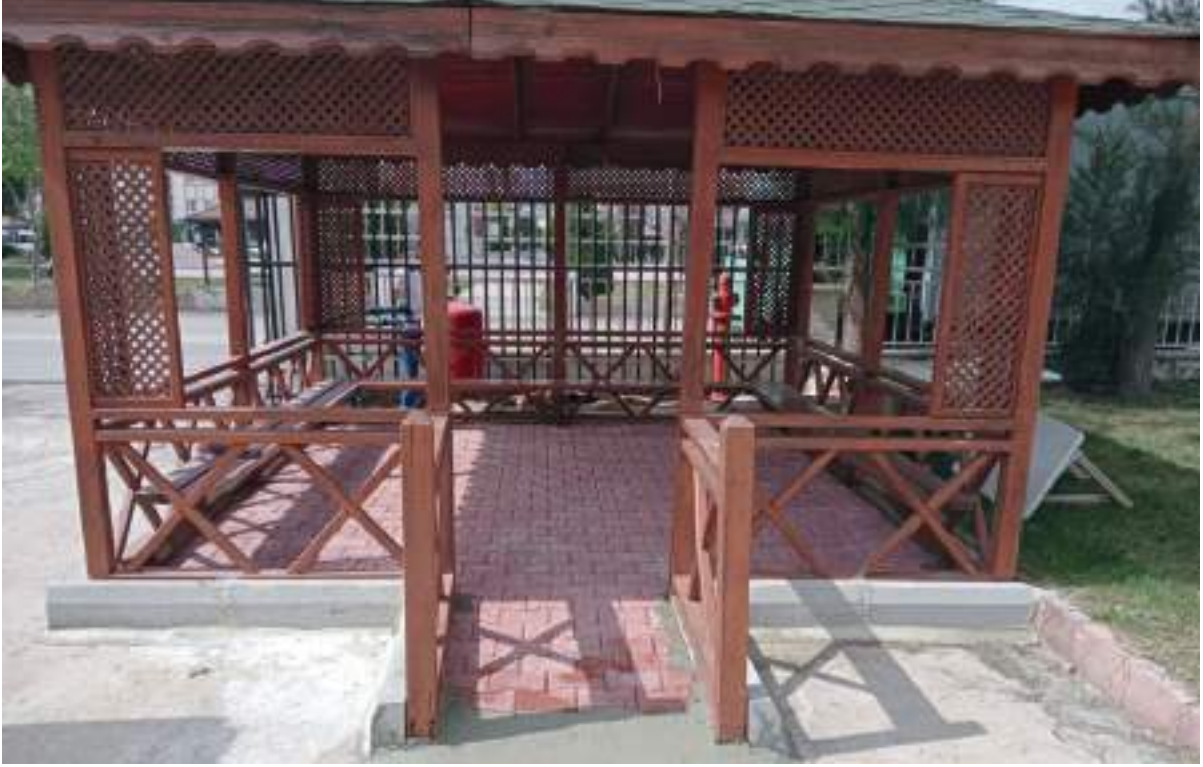
Yeşilyurt Mahallesi 4336 Sokak Gülsüm Ahmet Şimşek Anaokulu Pergola Alanı Bordür Parke Taşı İmalatı
