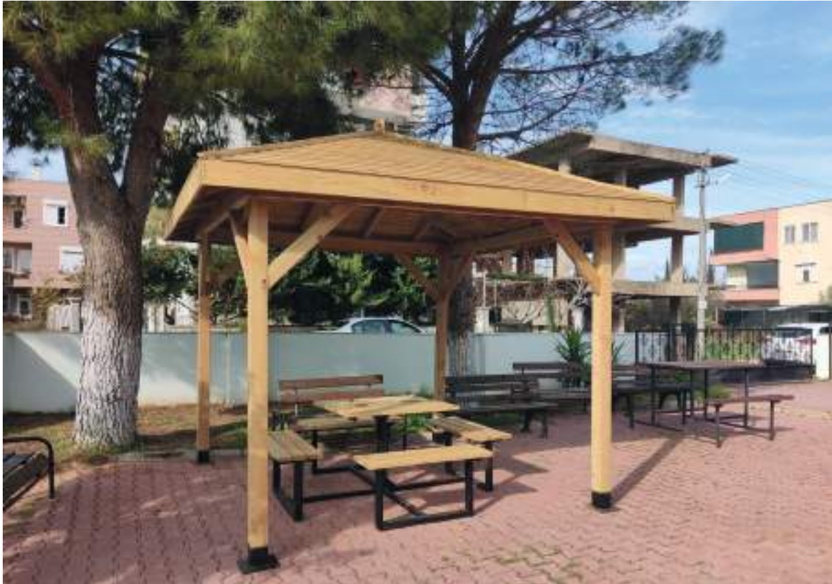
Demirel Mahallesi 2036 Sokak Gümüşköy Cami Pergola Montajı
