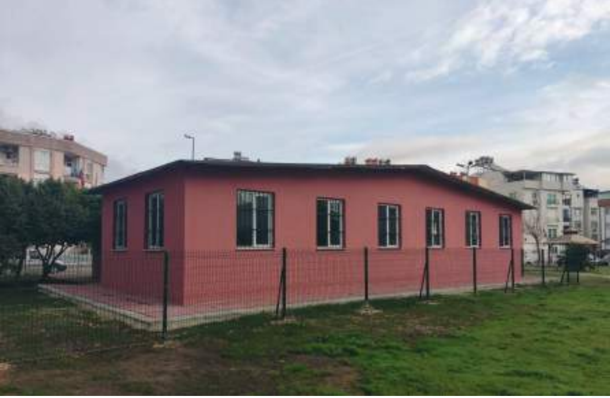
Taziye Evi Dış Görünüm
