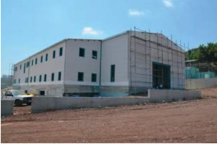
Konteynir Üretim Atölyesi İnşaatı Tamamlandı.
