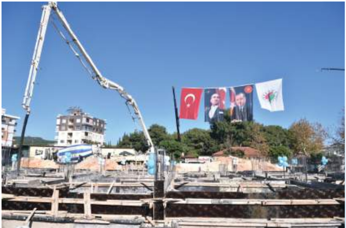
Temel Atma Alanı Görünümü
