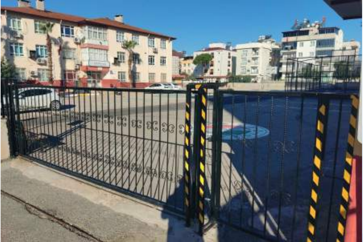
Ahatlı Mahallesi 3137 Sokak Şehit Hüseyin Gökhan Eriç İlkokulu Bahçe Girişi Sürgü Kapı İmalatı
