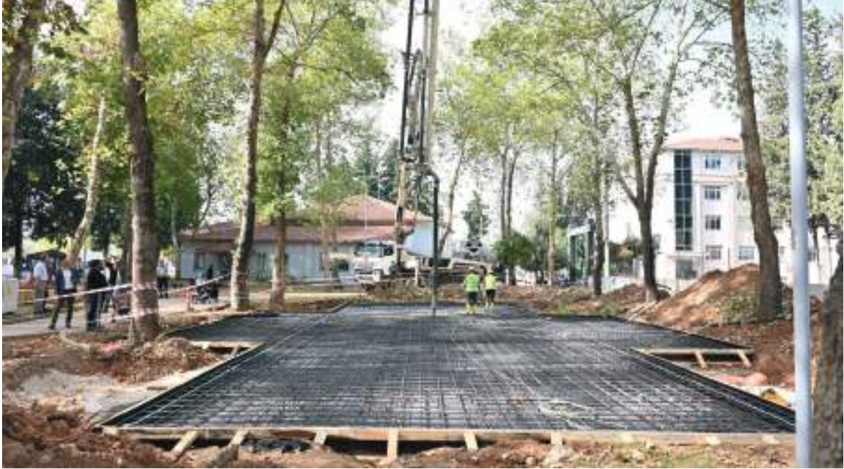
Kent Meydanı İnşaat Alanı
