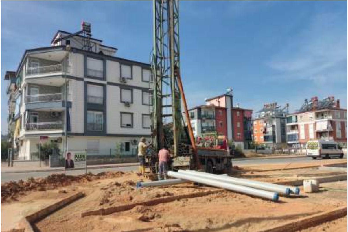
Gazi Mahallesi 6544-6555 Sokak Kesiřimi Parkı Sondaj Kuyusu Ađılması
