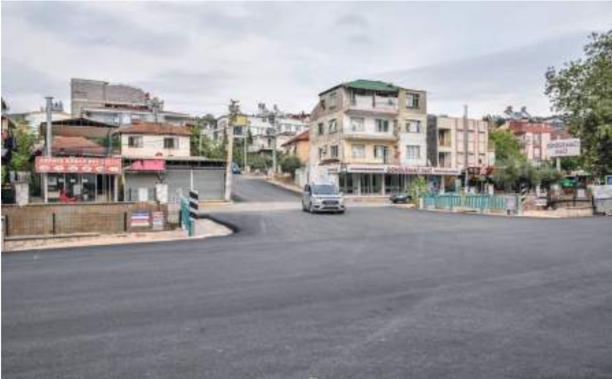
Erenköy Mahallesi Köprü Yapımı
