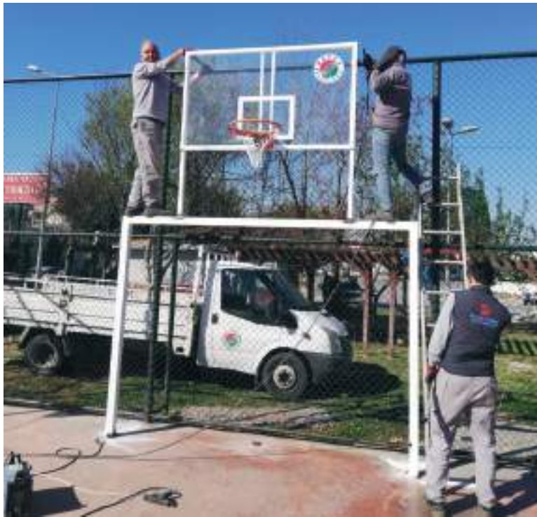
Teoman Paşa Mah. 2211 Sokak Parkı Basketbol Sahası Yapımı
