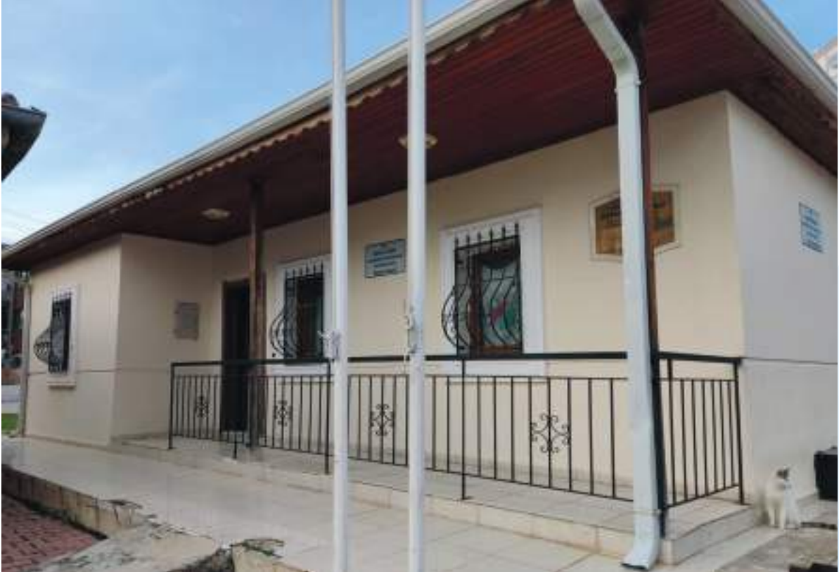
Ayanoğlu Mahallesi Muhtarlık Binası Dış Cephenin Boyanması
