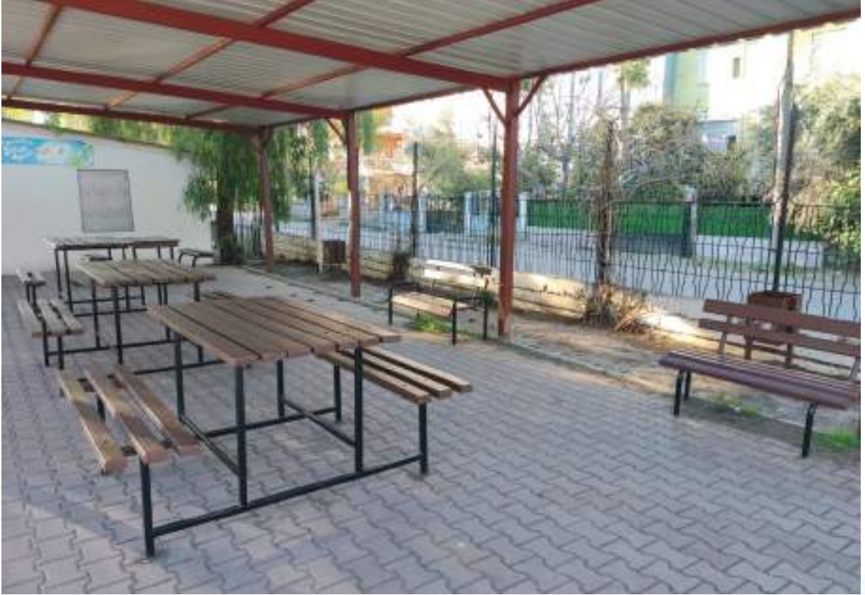
Gülveren Mahallesi 3750 Sokak Gülveren İlkokulu Bordür Tamirata ve Kent Mobilyaları Boya Yapımı
