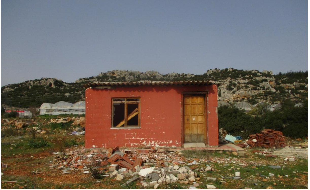
VARSAK ALTIYAYAK - 30746 ADA 1 PARSEL - 8023 SOKAK - BİLA NO –
