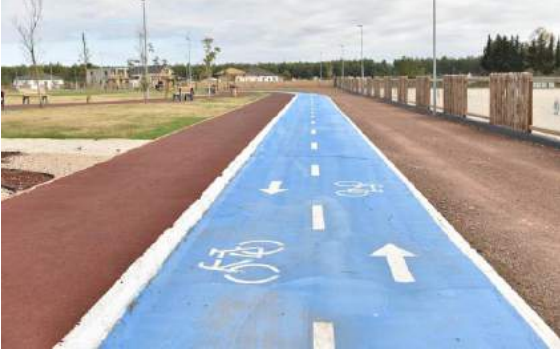
Duacı Parkı Yaya Yürüyüş Yolları Yapımı
