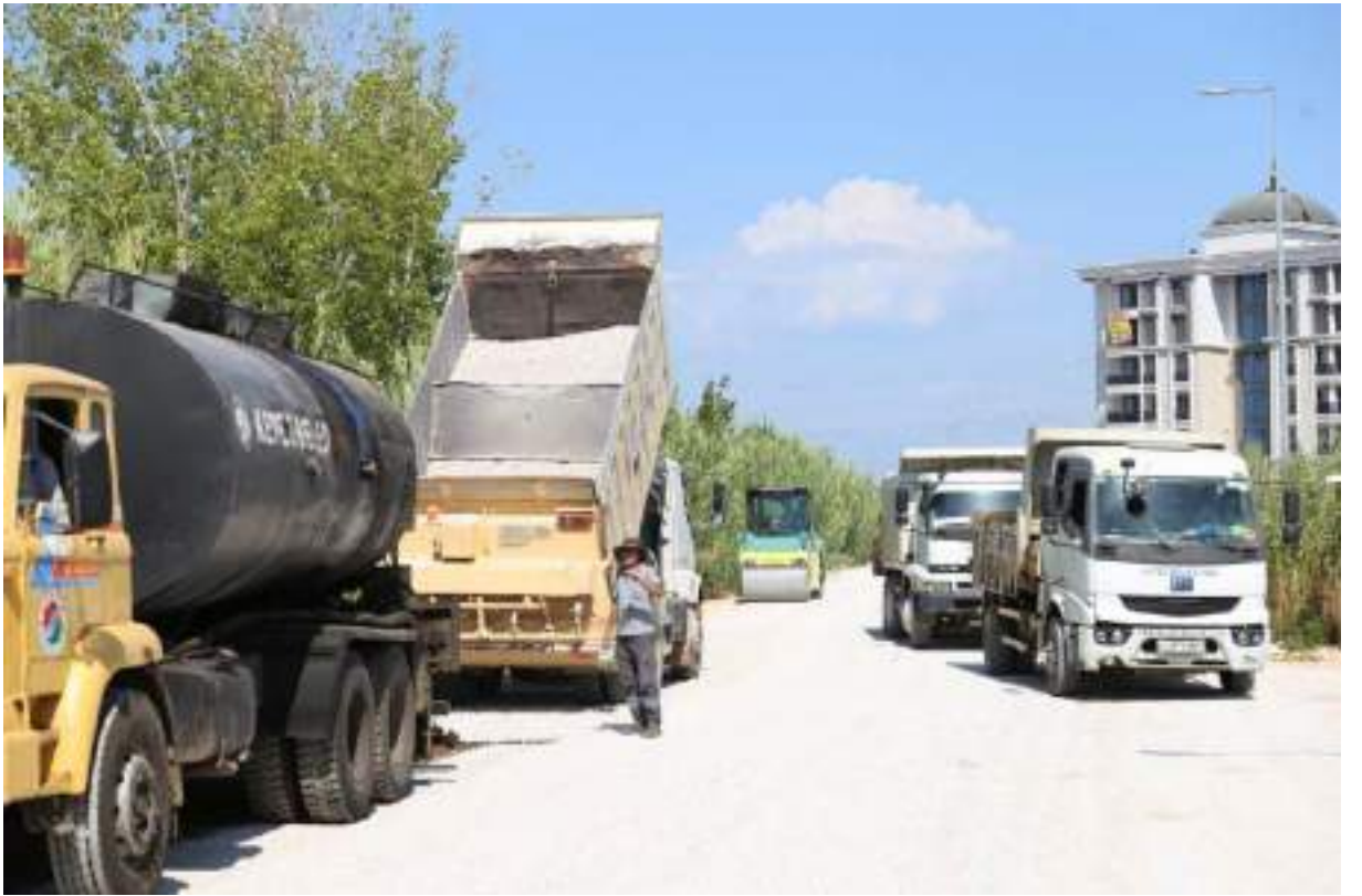
Göksu Mahallesi Sathi Asfalt Yapımı
