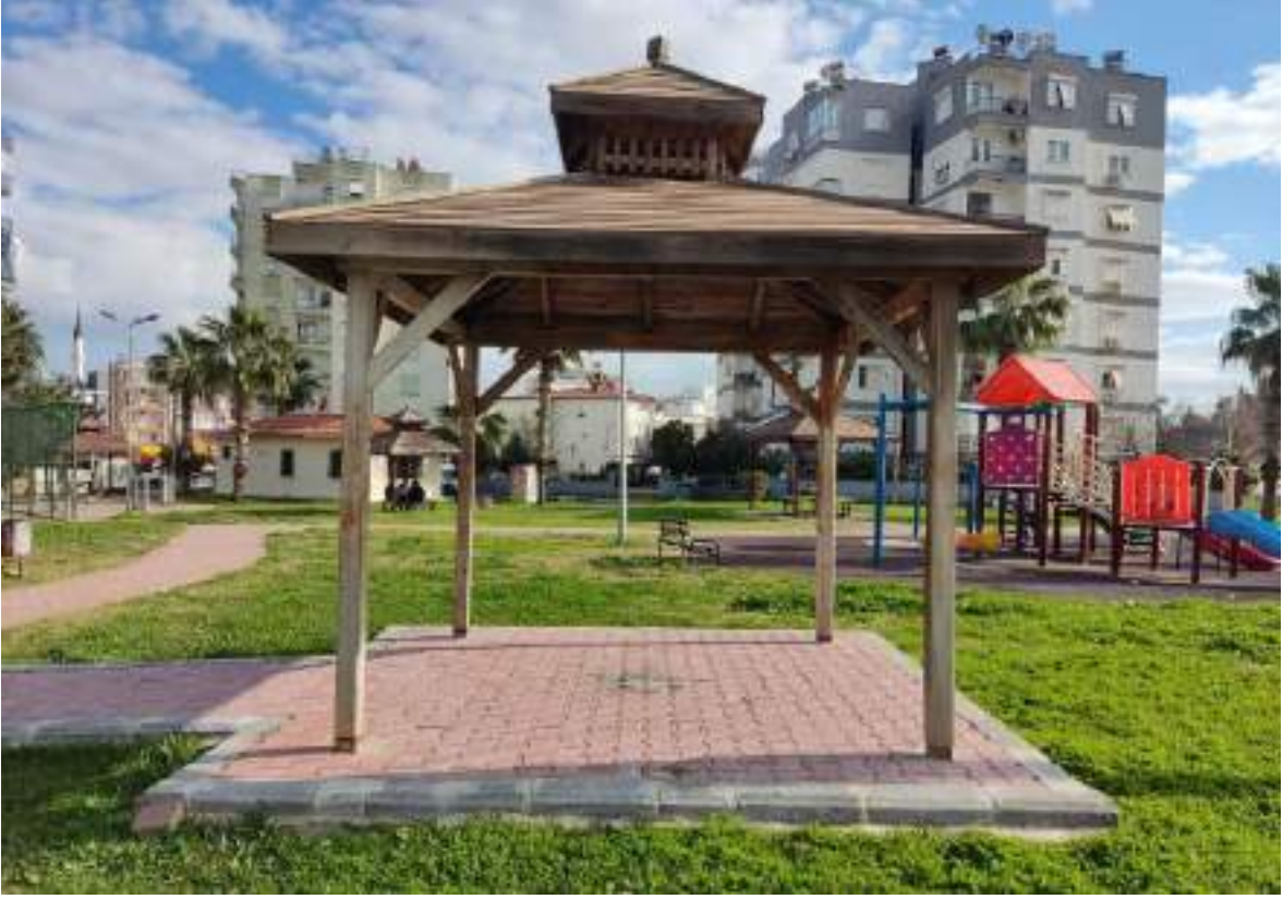
Şelale Mahallesi Muhtarlığı Pergola Çalışması
