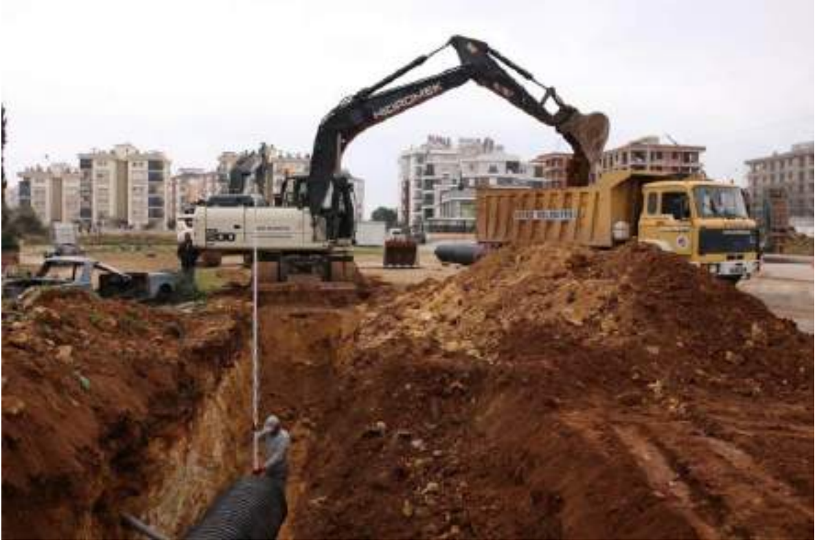
Göksu Mahallesi Menfez Döşeme Çalışması
