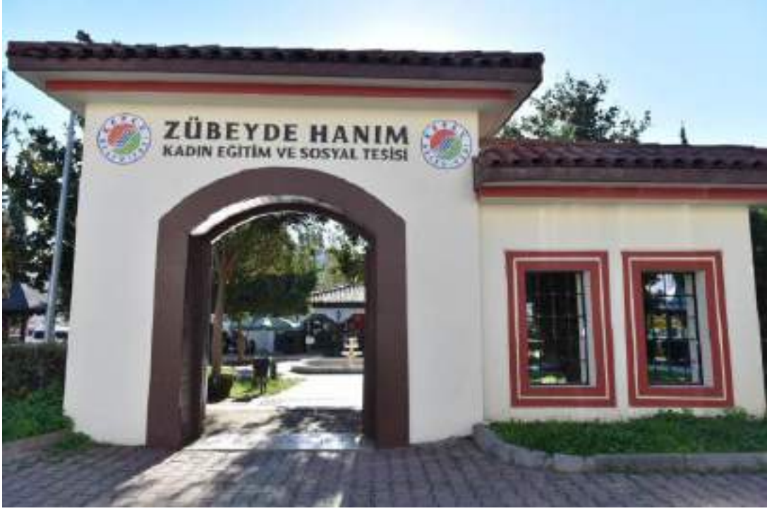
Tesisin Dış Görünümü
