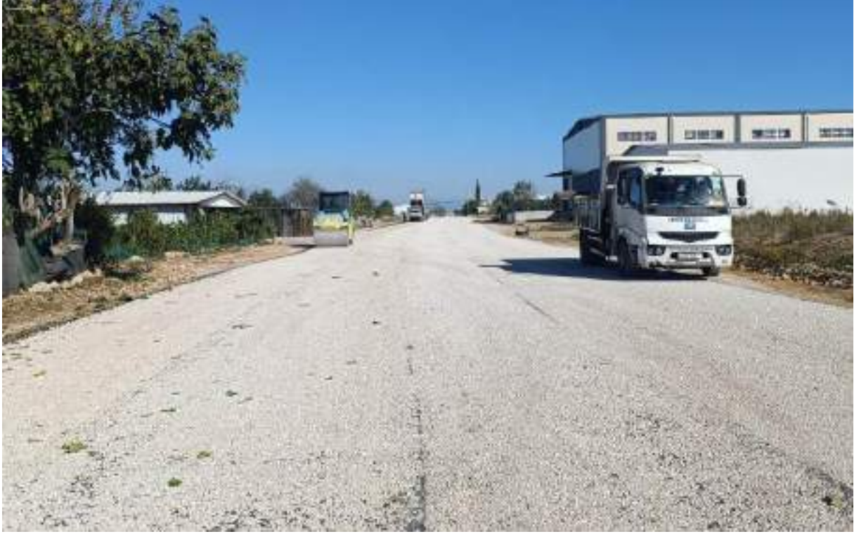
Altınova Menderes Mahallesi Sathi Asfalt yapımı
