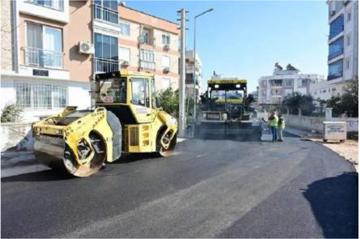
Yeni Emek Mahallesi Sıcak Asfalt Yapımı
