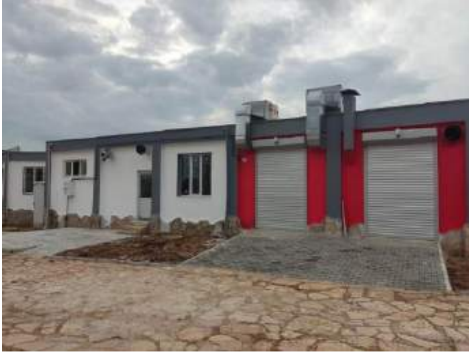
Tesisin Girişi tamamlandı
