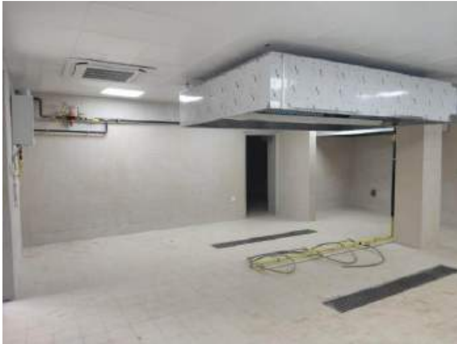
İnşaat, Mekanik ve Elektrik Tesisat Tadilat İşleri Tamamlandı.
