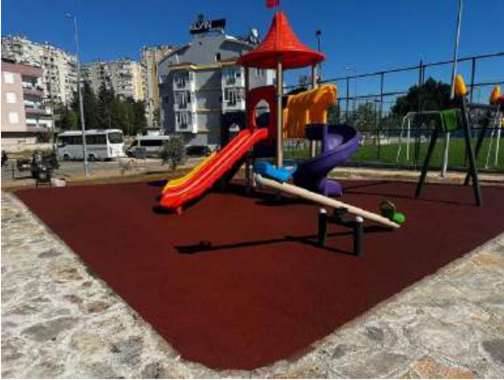
Düdenbaşı Mahallesi Kauçuk Zemin Uygulaması
