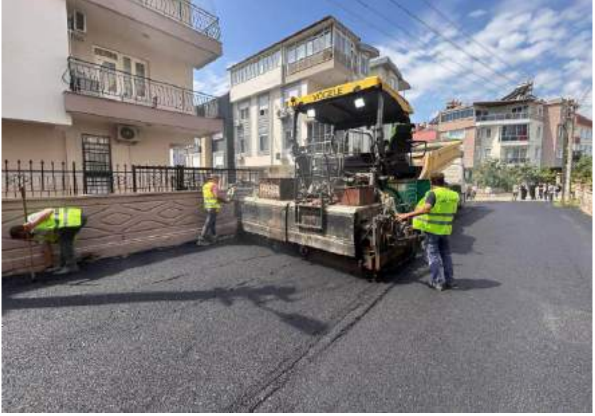
Barış Mahallesine Sıcak Asfalt Yapımı
