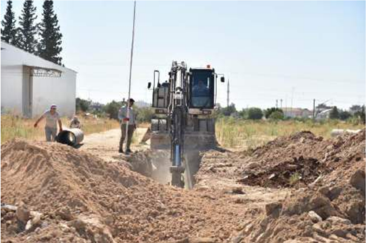
Altınova Menderes Mahallesi Menfez Döşeme Çalışması
