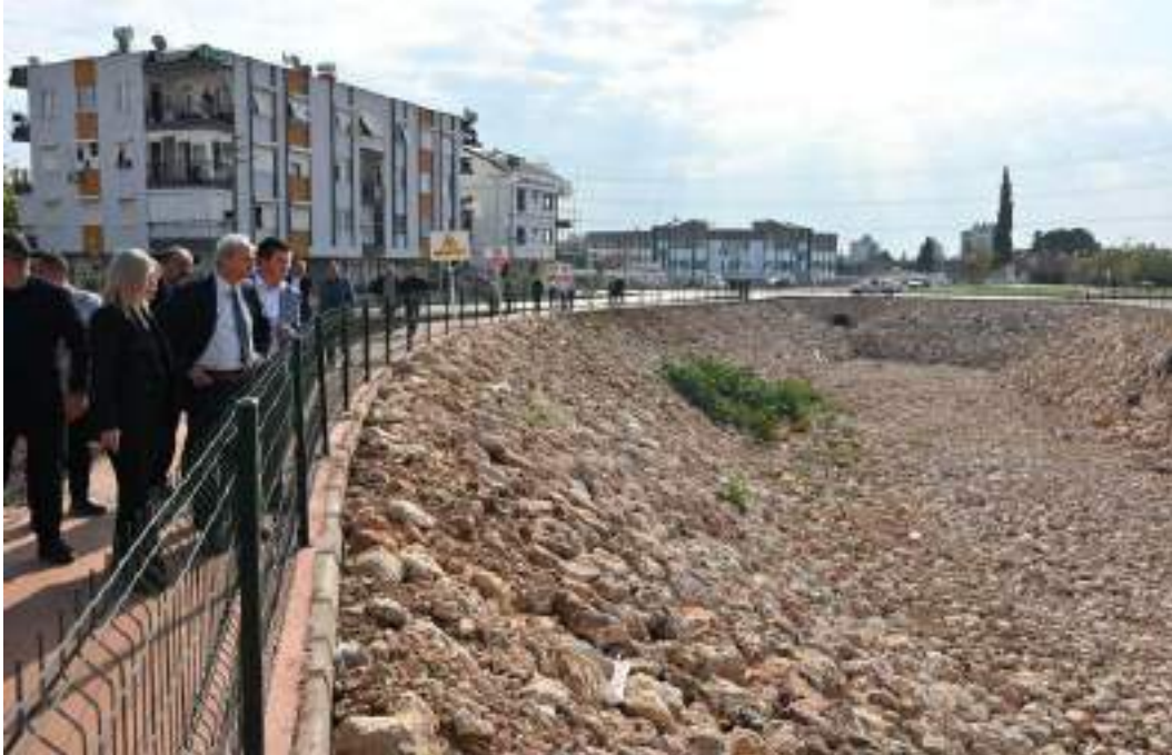
Başkanımız Şelale Parkında Yapılan Drenaj Çalışmalarını İncelediler.
