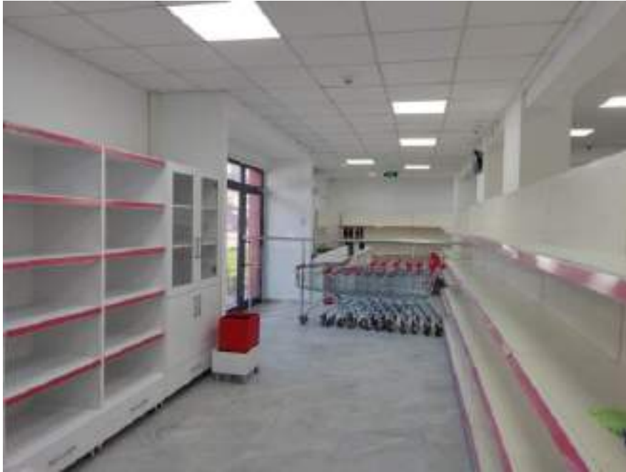
Ürünlerin Yerleştirilmesi İçin İç Market Rafları, Dolaplar Ve Montaj Çalışmaları Tamamlandı.
