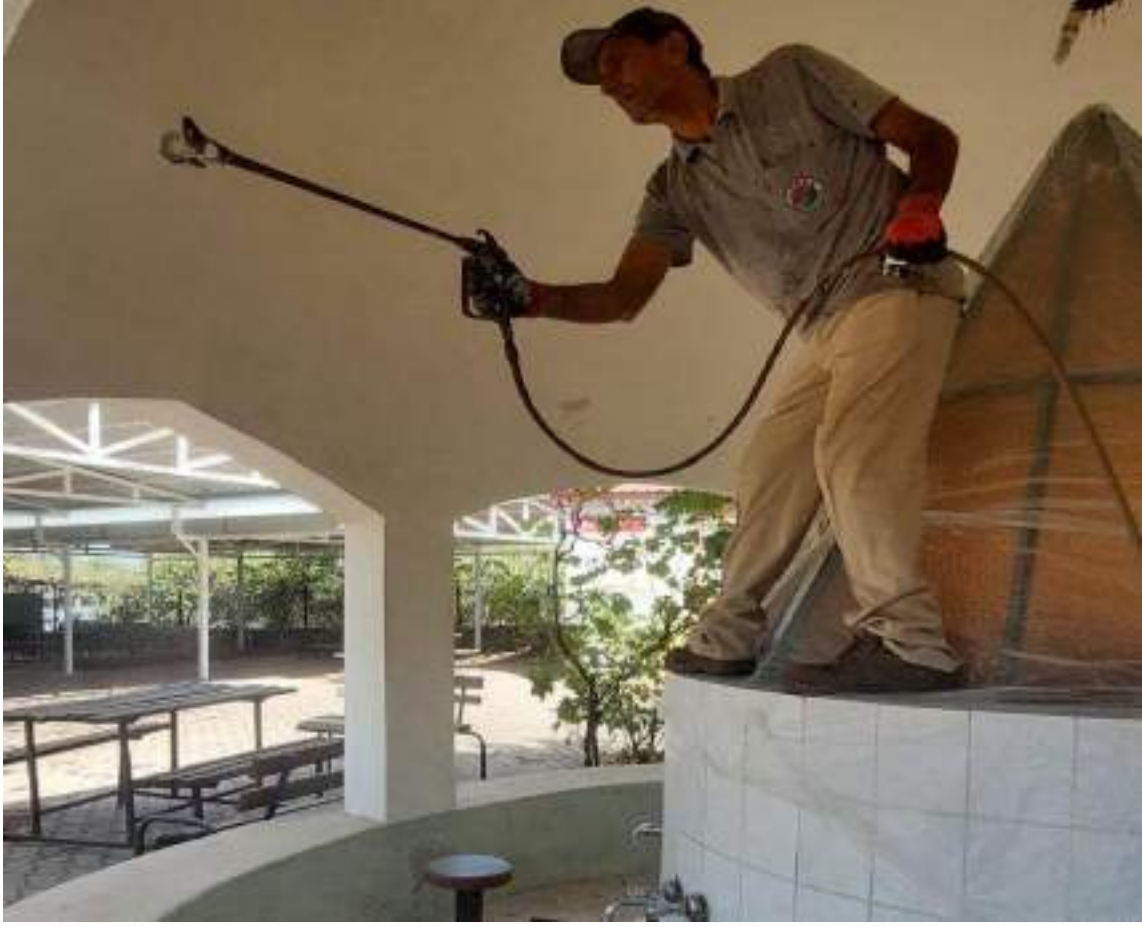
Hacıaliler Cami Şadırvan Badanası Yapılması
