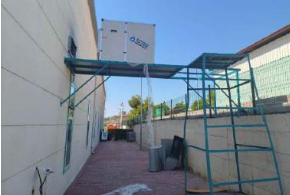
Konteyner İmalat Atölyemize Havalandırma Sistemi Yapıldı.
