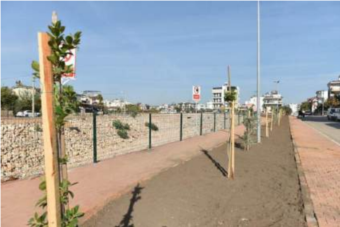
Şelale Parkı Yaya Yürüyüş Yolları Yapımı
