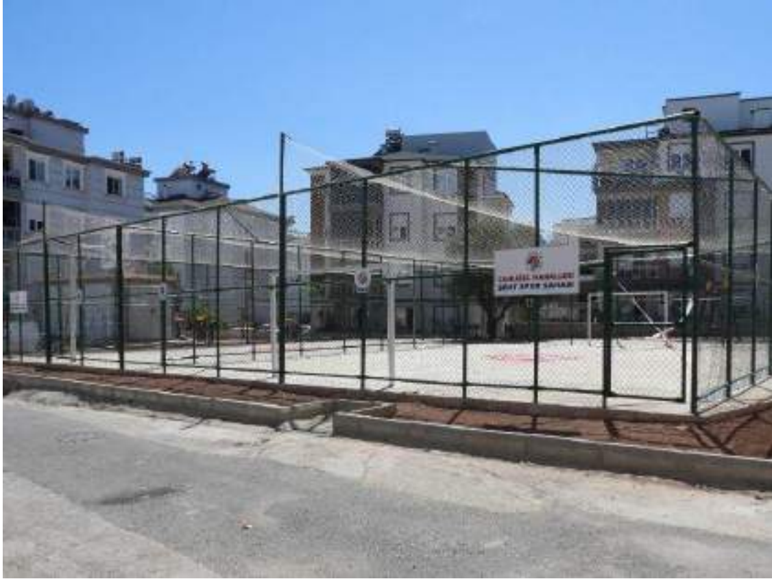
Çamlıbel Mahallesi Basketbol ve Futbol Sahası Yapımı
