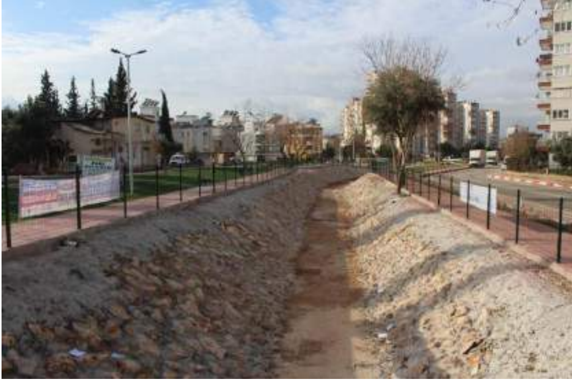
İslah Çalışması Dere İslahı ve Taş Tahkimat Uygulaması
